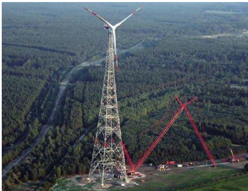
Rys. 3.5. Najwyższa na świecie elektrownia wiatrowa zbudowana w 2007 roku w Laasow (Niemcy) [Pau08]
