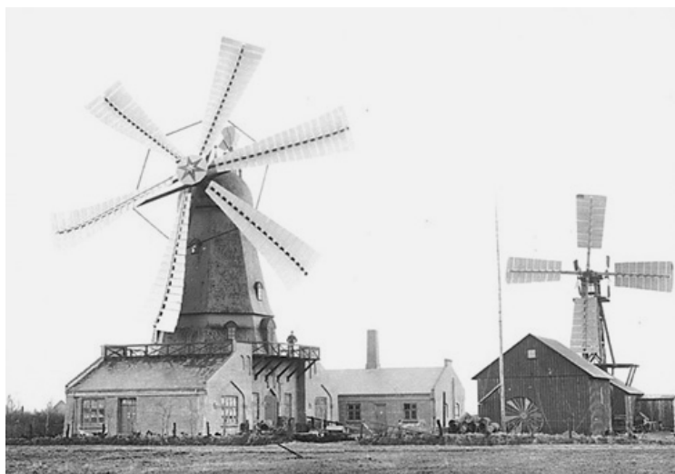
Rys. 2.1. Elektrownia wiatrowa zaprojektowana przez Poul'a la Coure'a [Enw]
