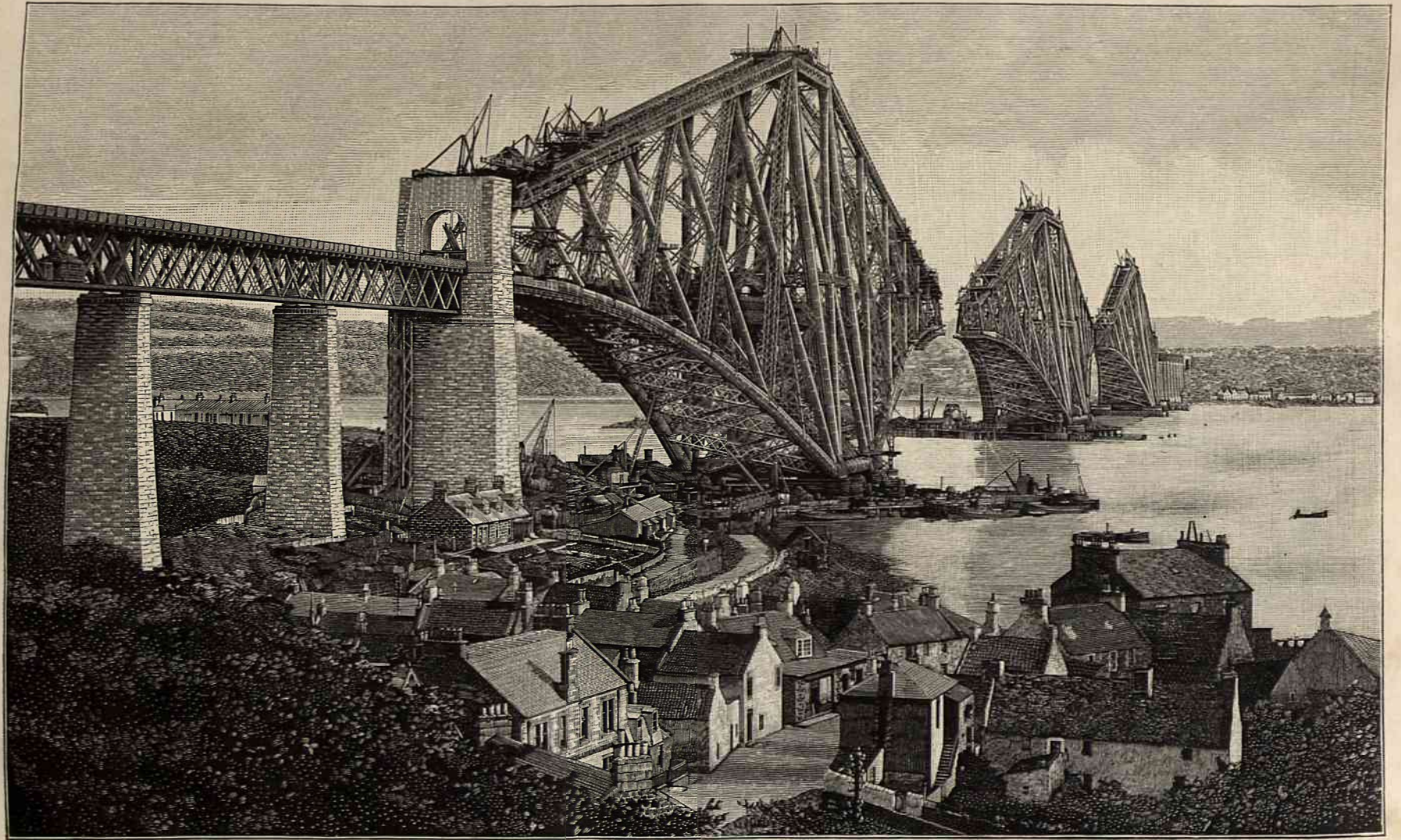
Die Forthbrücke. Gesamtansicht.
