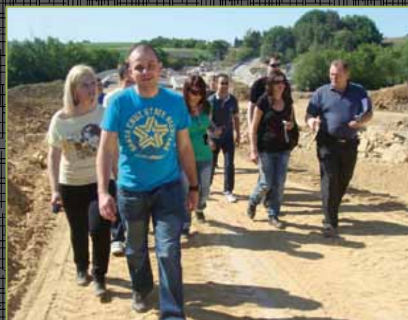
Zwiedzanie budowy drogowo-mostowej
