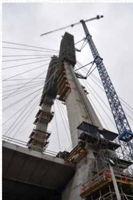
Do pylonu w kształcie litery H usytuowanego na wyspie, podwieszane będą dwie niezależne, trójpasmowe jezdnie
