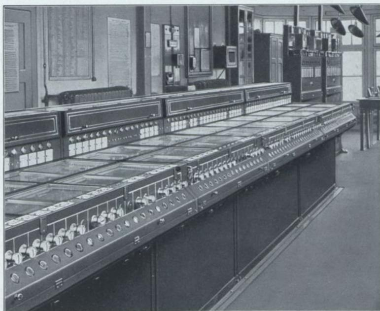
Abb. 89. Anordnung der Blockwerke seitlich vom Schalterwerk.
