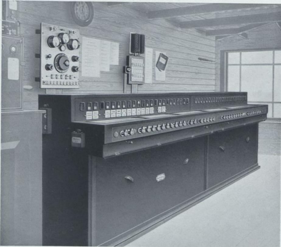
Abb. 68. Weichen- und Signalschalterwerk Uppsala.
