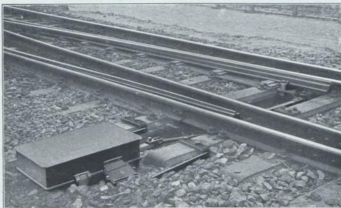
Abb. 30. Weichenantrieb ohne Zungenüberwachung (geschlossen) an einer einfachen Weiche.
