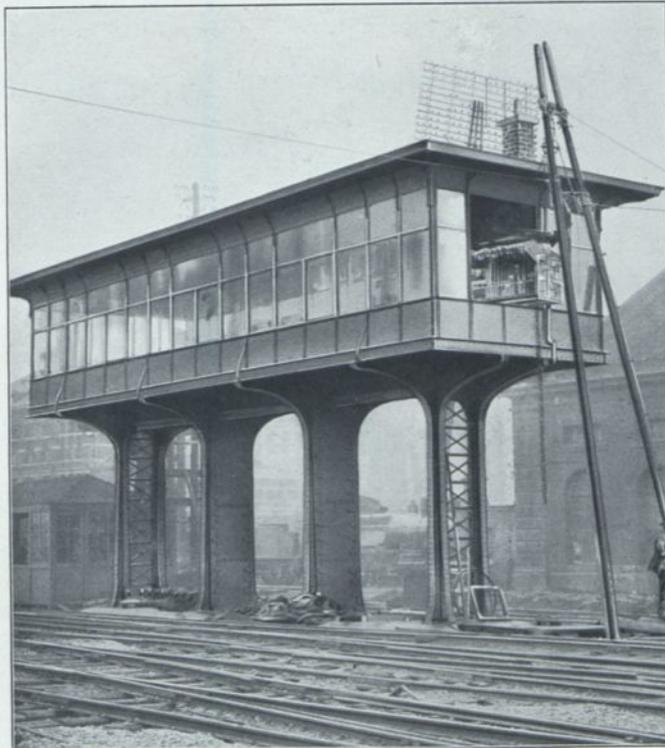
Abb. 70. Einbringen eines Schalterwerkes in das Stellwerkgebäude
