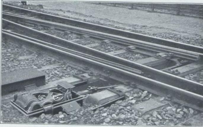
Abb. 23. Weichenantrieb ohne Zungenüberwachung (geöffnet) an einer einfachen Weiche.
