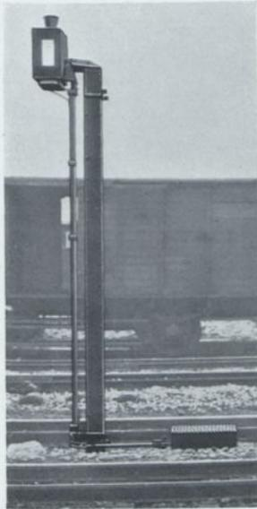
Abb. 37. Weichenantrieb am Signal 14.
