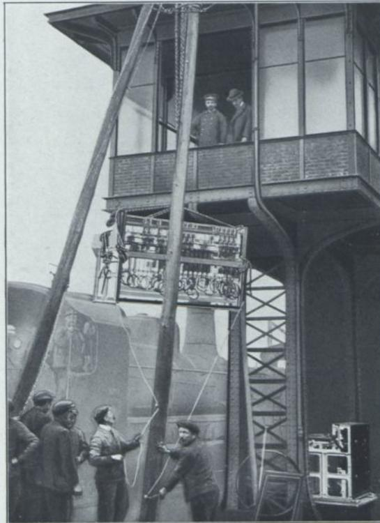
Abb. 69. Einbringen eines Schalterwerkes in das Stellwertgebäude
