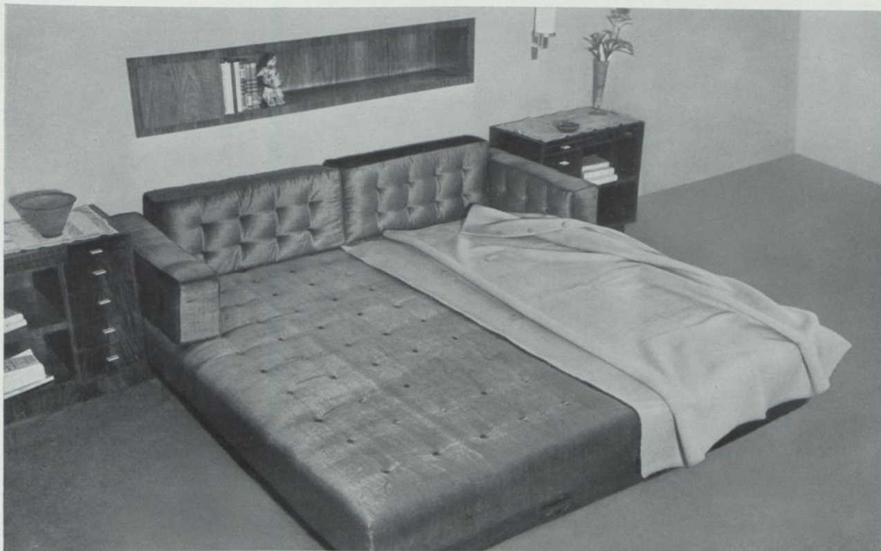
Auf einem ausziehbaren Rost liegen bei Tag zwei Matratzen übereinander; bei Nacht werden sie nebeneinandergelegt und als Bett bezogen. Entwurf Ludwig Kozma, Budapest
