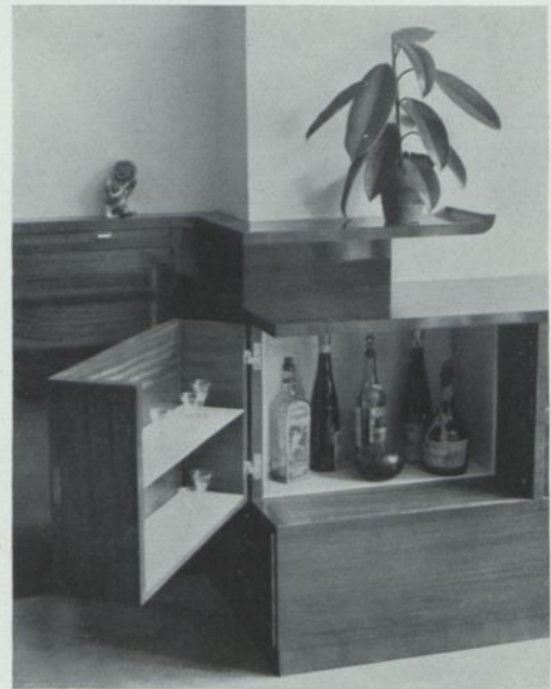
In diesem Speisezimmer von Erwin Katona in Prag sind der Gläser- und Geschirrschrank aus kaukasischem Nußbaum in die Wand eingelassen. Ein Wandvorsprung ist durch einen ausschwenkbaren Kasten in origineller Weise zu einem kleinen Likörschrank ausgebildet
