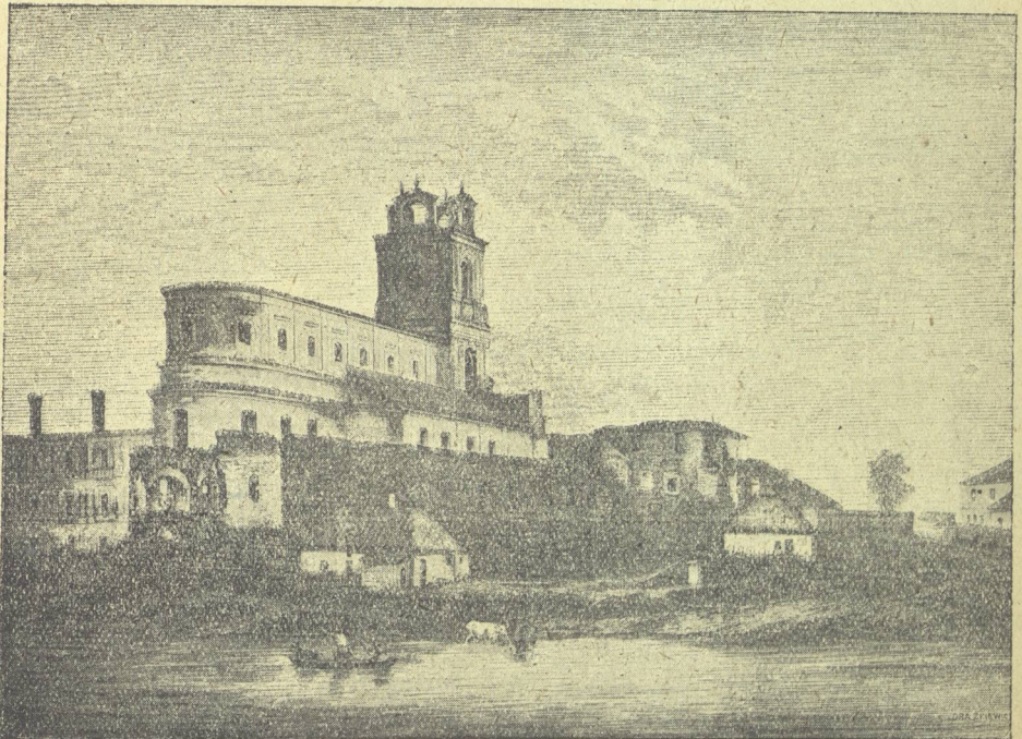
Ruiny klasztoru i kościoła po-dominikańskiego od strony Styru.
