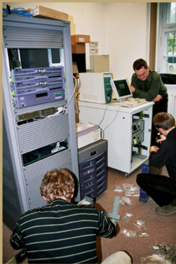
Montaż serwerów do celów informatyzacji uczelni
