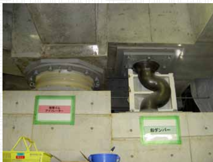
Jeden z wibroizolatorów podpierających 10-kondygnacyjny budynek w Osace
