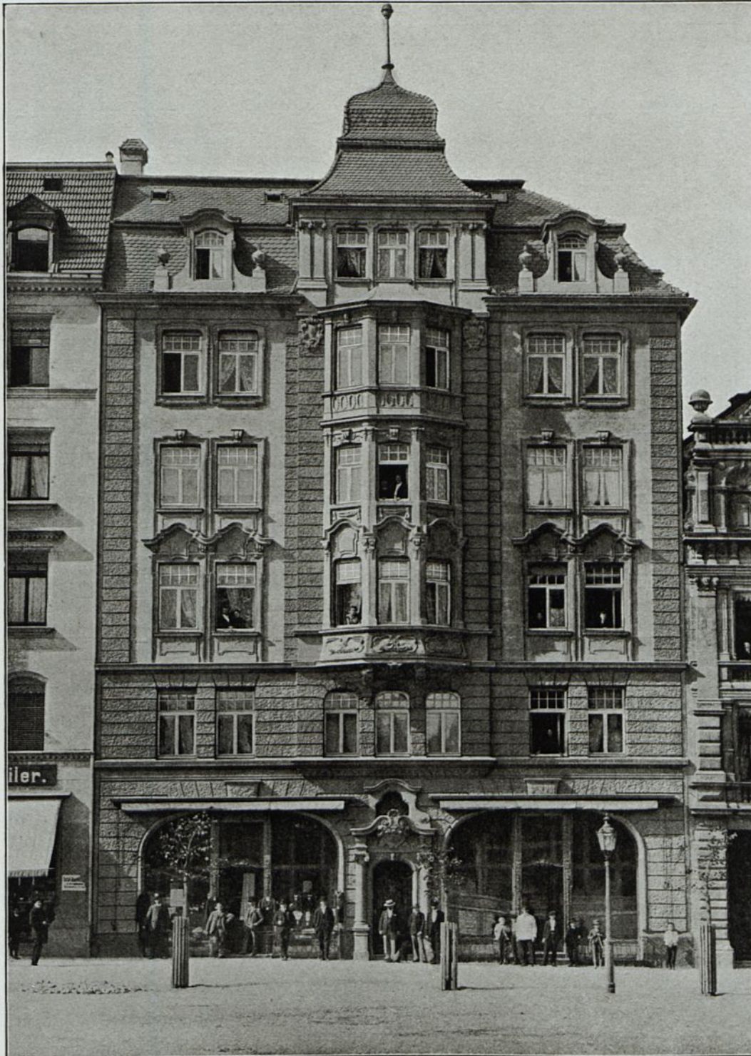
Abb. 58. Wohn- und Geschäftshaus in Ulm a. D. Betonwerksteine der Firma E. Schwenk, Ulm a. D.
