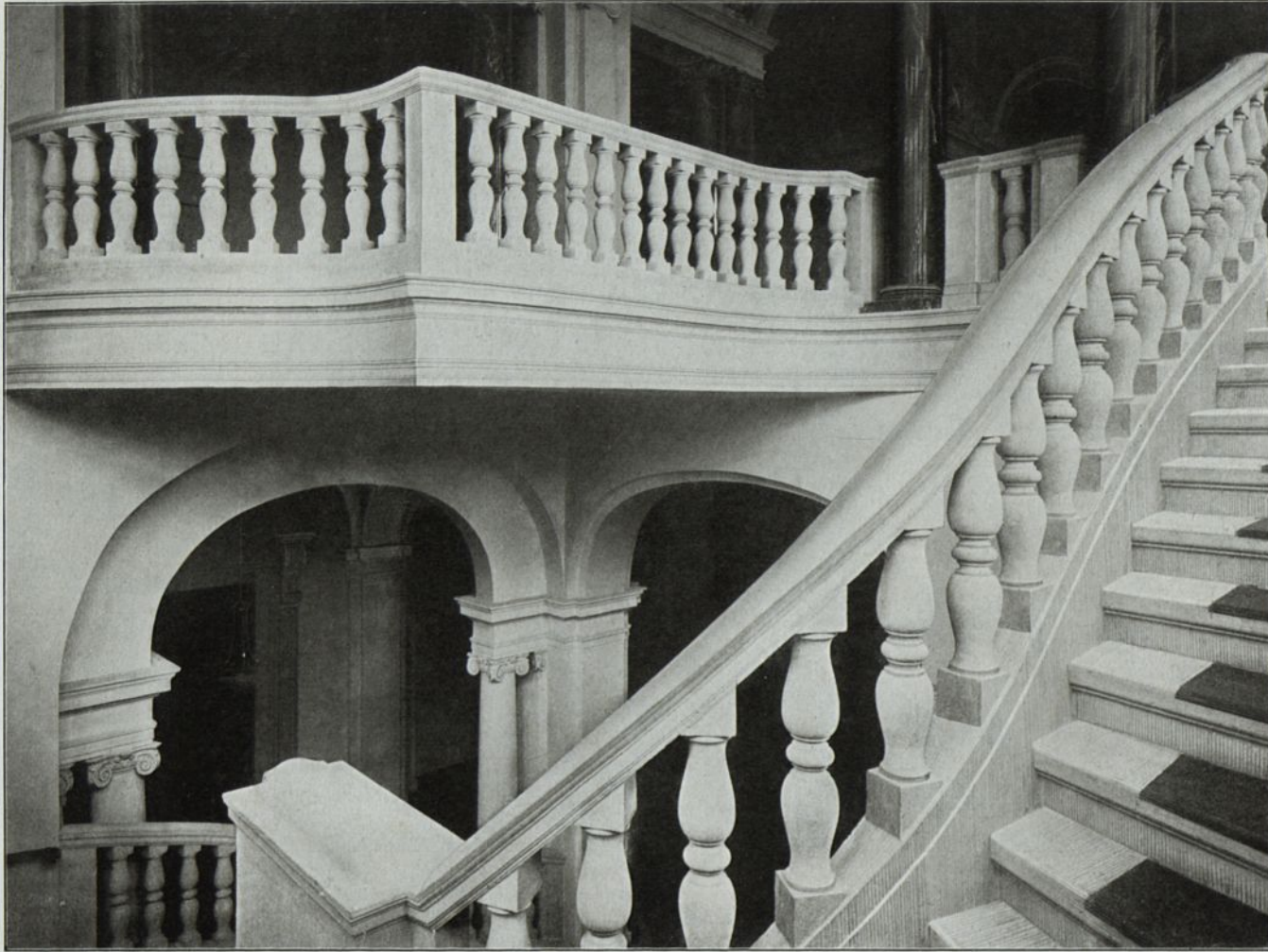
Abb. 130. Treppe im Oberverwaltungsgericht zu Berlin. Ausgeführt von der Firma M. Czarnikow & Cie., Berlin.
