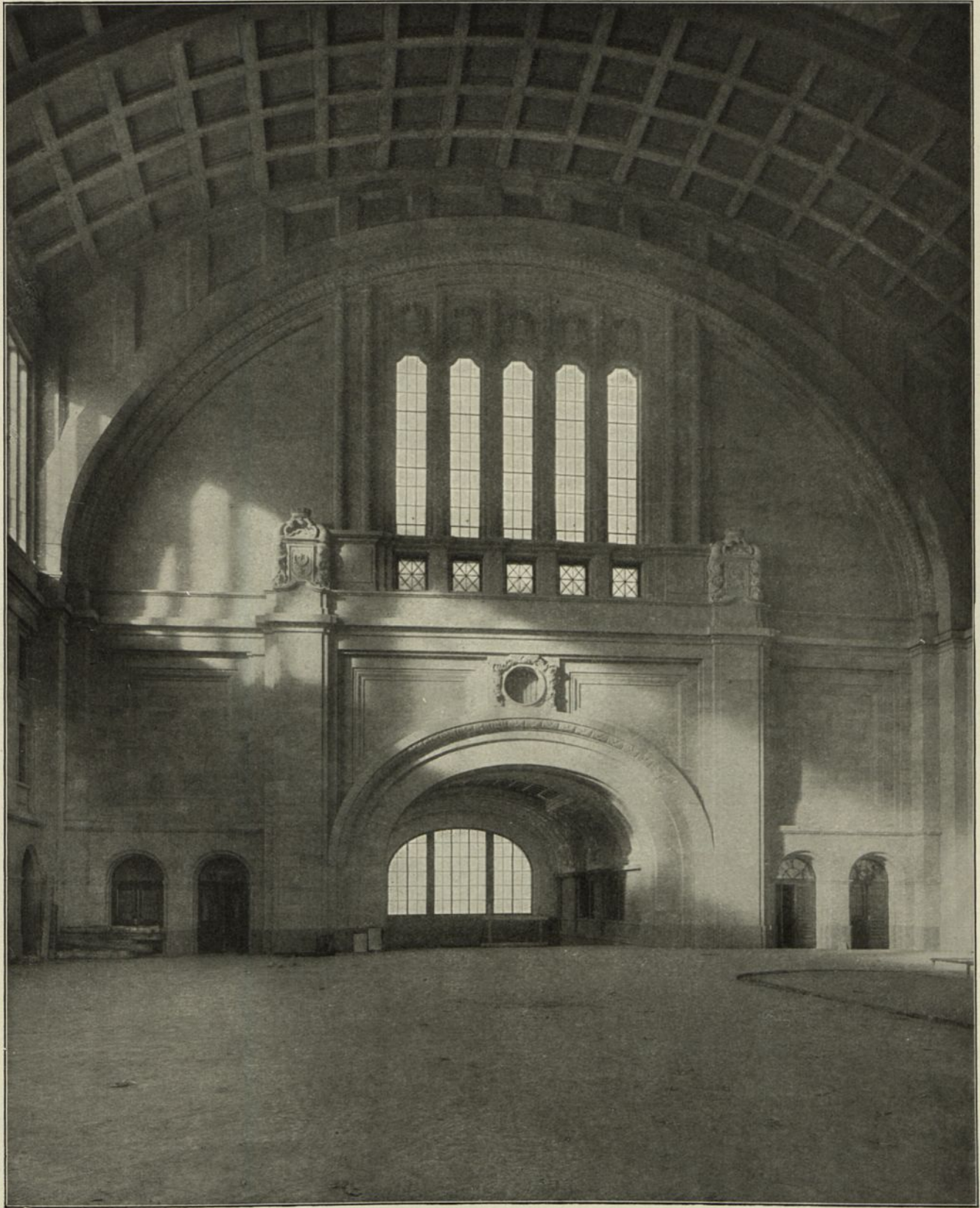
Abb. 215. Querbahnsteighalle Leipzig, Abschlusswand. Ausgeführt von der Firma Dyckerhoff & Widmann, A.-G., Dresden.
