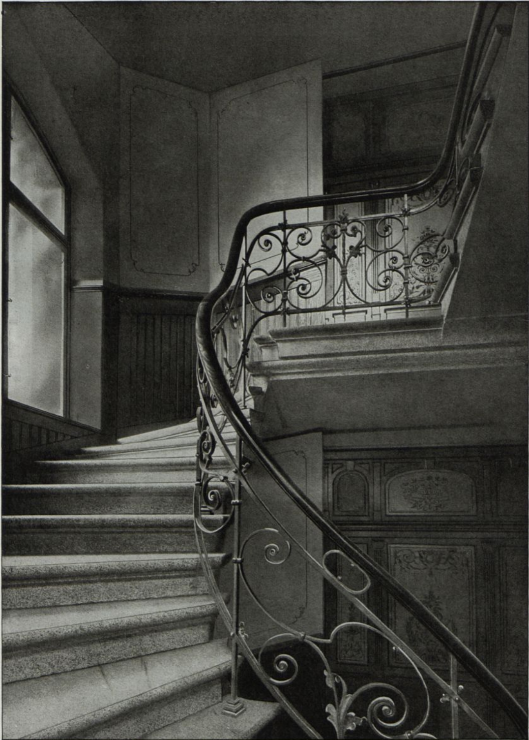
Abb. 128. Treppe im Wohnhaus Bürkle in Ulm a. D. Ausgeführt von der Firma E. Schwent, Ulm a. D.
