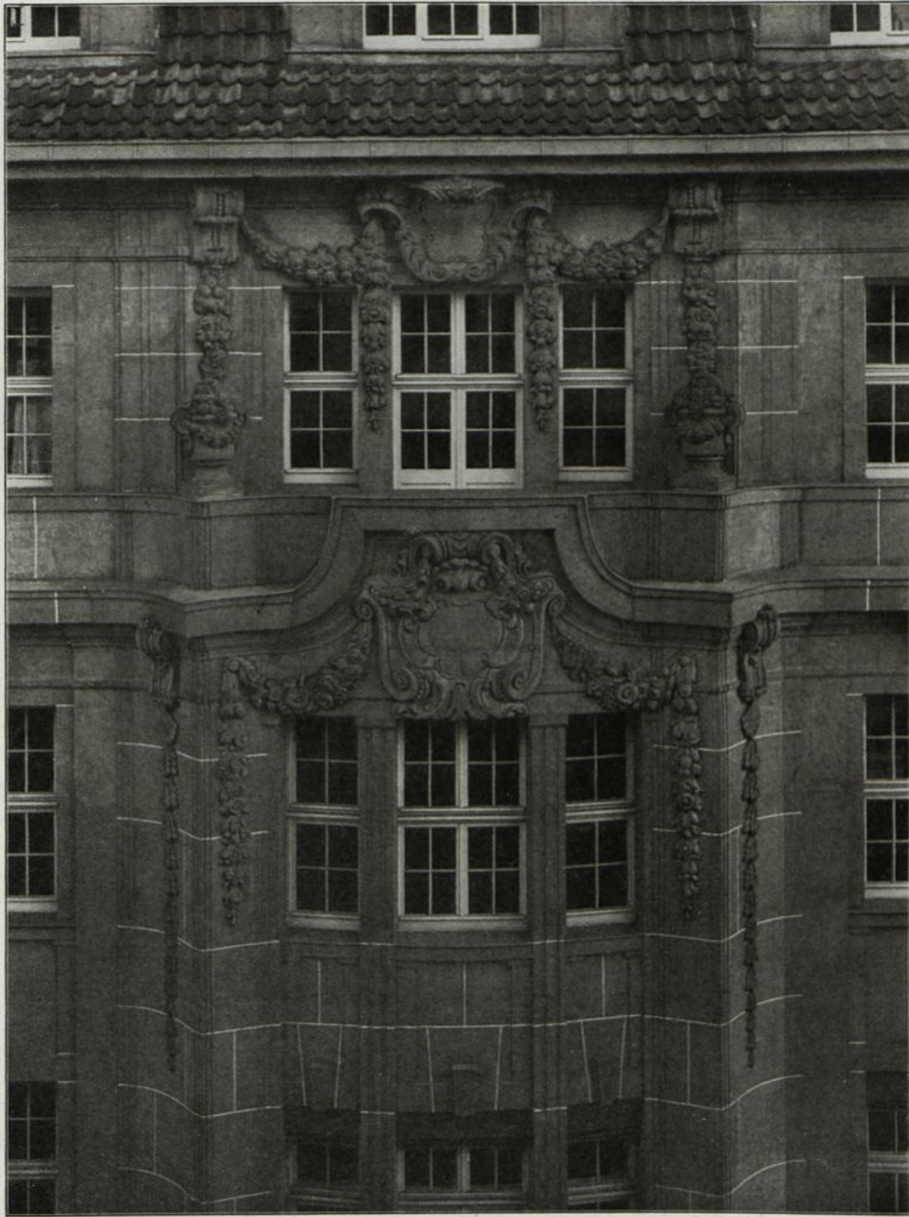
Abb. 85. Geschäftshaus der Cementbau-Aktiengesellschaft Hannover. Betonwerksteine der Firma Cementbau-Aktiengesellschaft Hannover.
