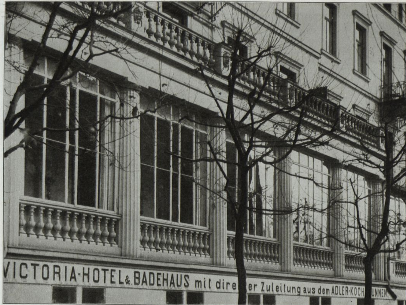
Abb. 16. Betonsteinsäulen am Viktoria-Hotel in Wiesbaden. Geliefert von der Firma Dyckerhoff & Widmann, Viebrich.
