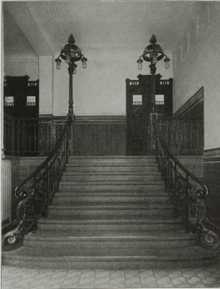
Abb. 129. Treppe im Geschäftshaus Herzfeld & Viktorius zu Graudenz.
