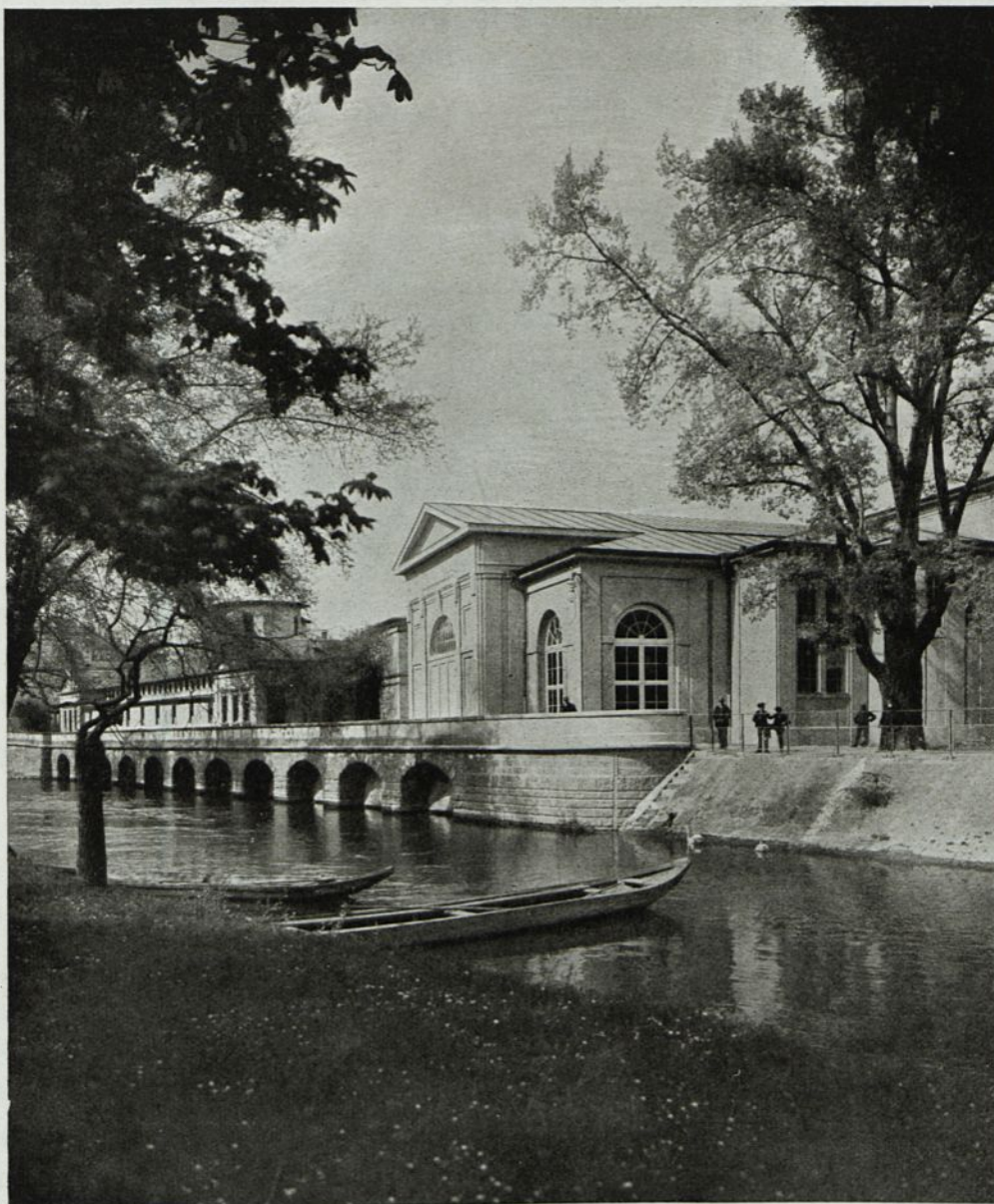
Abb. 223. Trinkhalle in Bad Rissingen. Ausgeführt von der Firma Dyckerhoff & Widmann, A.-G., Nürnberg.
