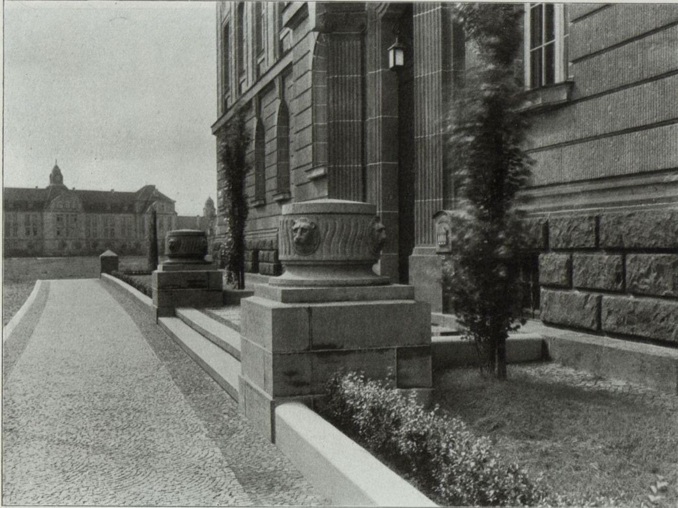
Abb. 118. Einfriedigung der Oberpostdirektion Hannover. Ausgeführt von der Firma Otte & Fölsch, Hannover.
