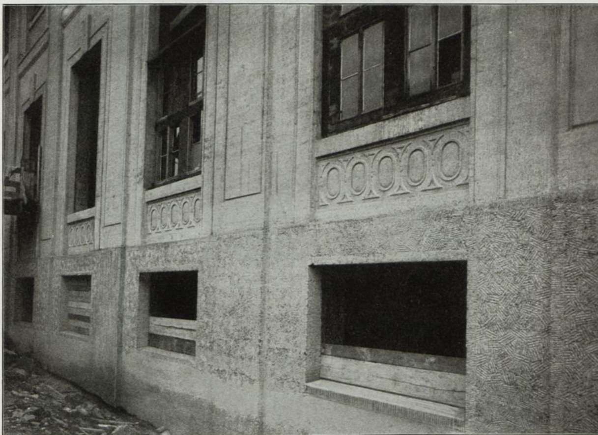
Abb. 232. Deutsches Museum, München, Nordseite, Sockel und Erdgesch. Bauteil der Firma Rud. Wolle, Leipzig.
