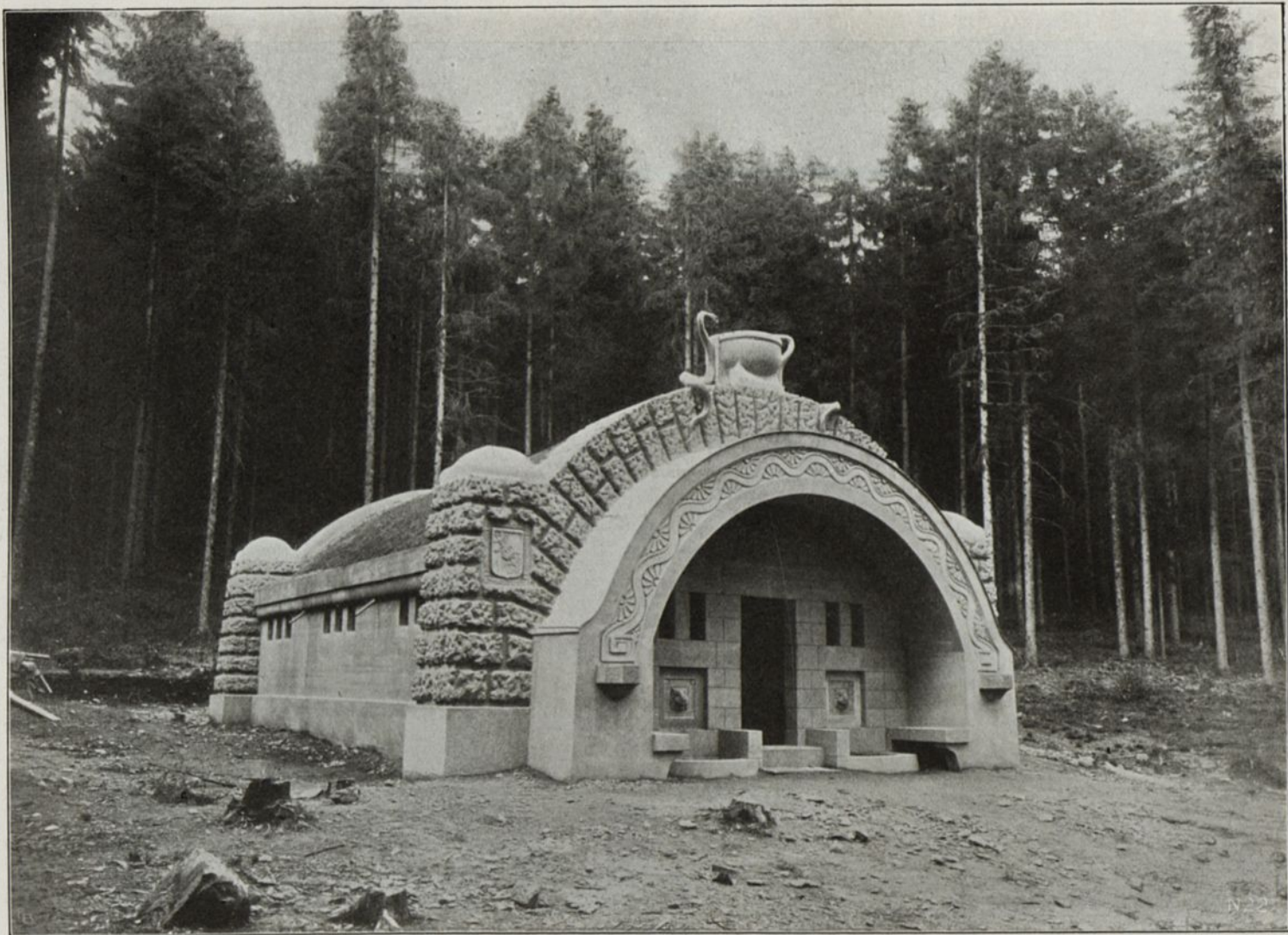
Abb. 274. Sammelschacht Warmenstein. Ausgeführt von der Firma Dyckerhoff & Widmann, A.-G., Nürnberg.
