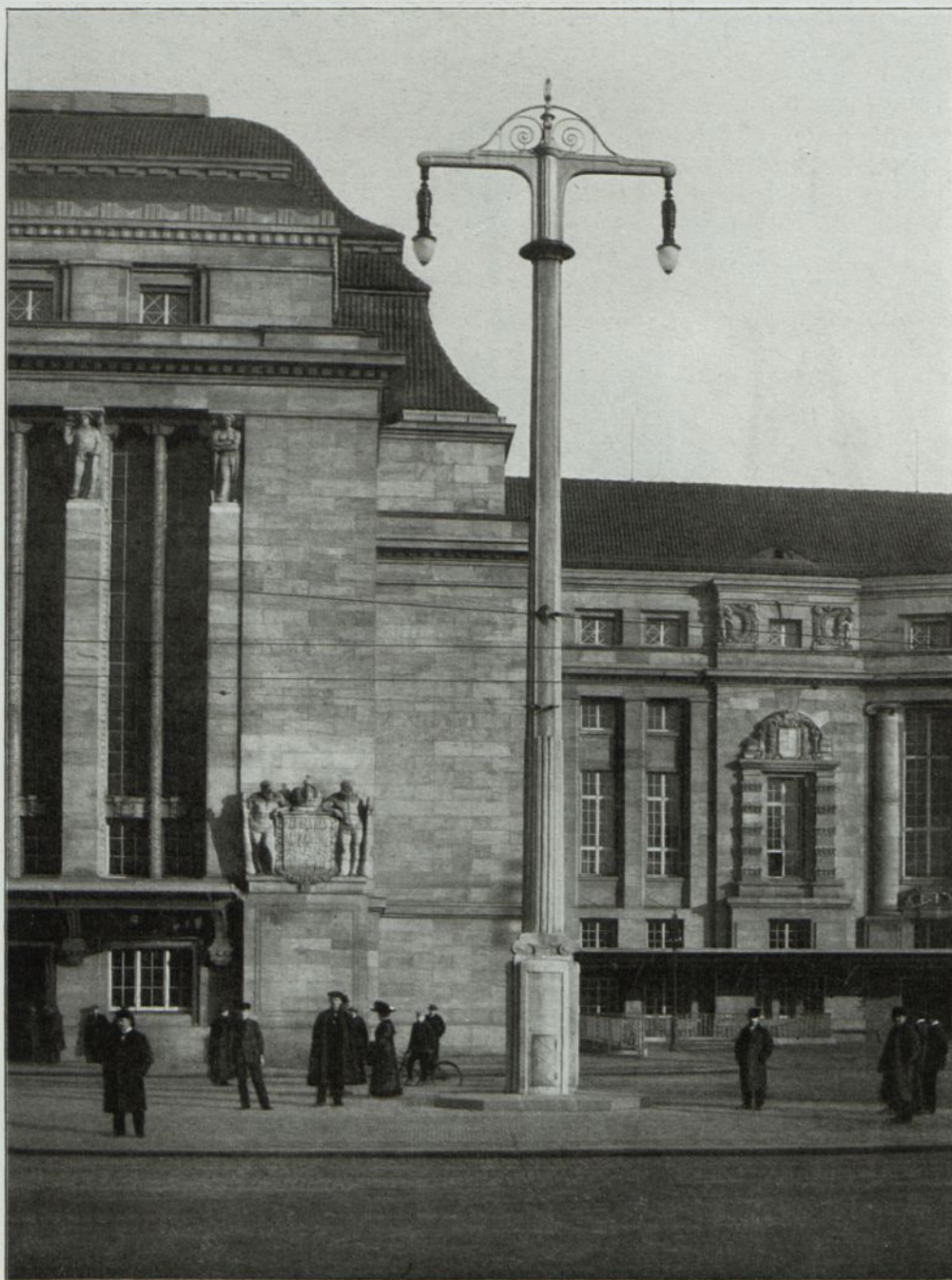
Abb. 200. Zweiarmiger Eisenbetonmast vor dem Hauptbahnhof in Leipzig. Ausgeführt von der Firma Rud. Wölle, Leipzig.
