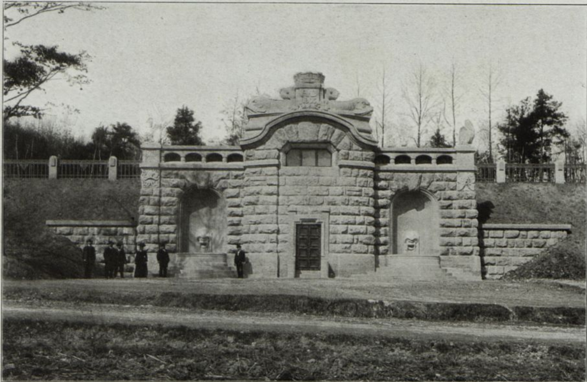
Abb. 273. Hochbehälter Fürth. Ausgeführt von der Firma Joh. Dörrio, Dresden.
