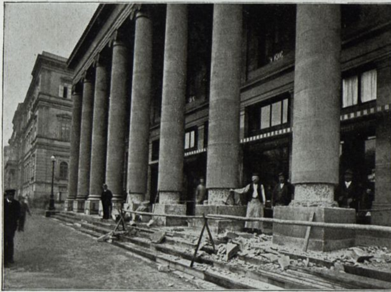
Abb. 166. Königsbau in Stuttgart, Ersatz der Säulenfüße durch Betonstein.
