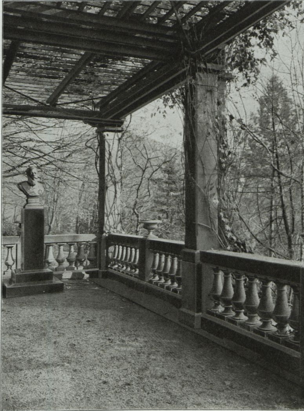
Abb. 17. Baluster am Großherzoglichen Schloß in Baden-Baden. Geliefert von der Firma Dyckerhoff & Widmann, Karlsruhe.
