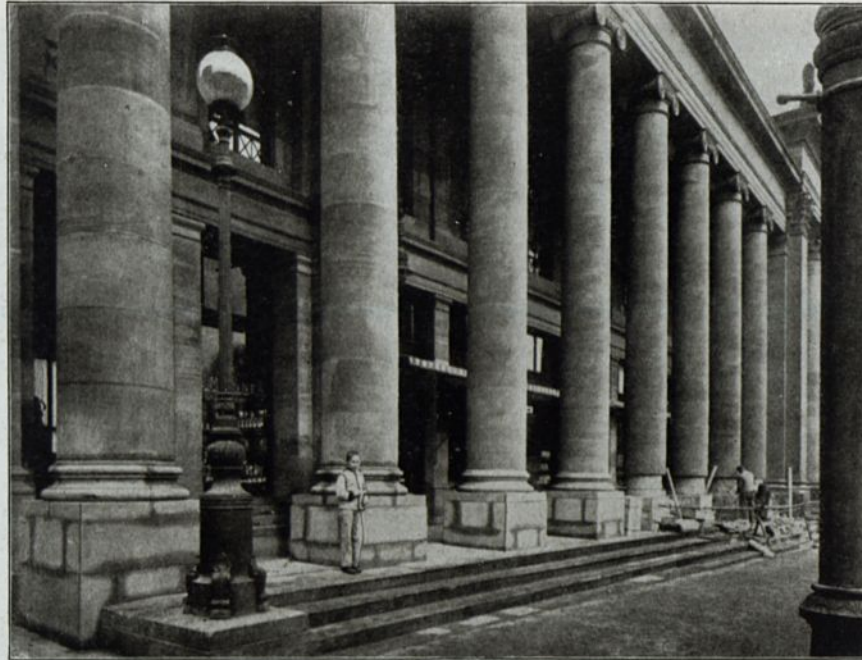
Abb. 168. Königsbau in Stuttgart, Ersatz der Säulenfüße durch Betonstein.
