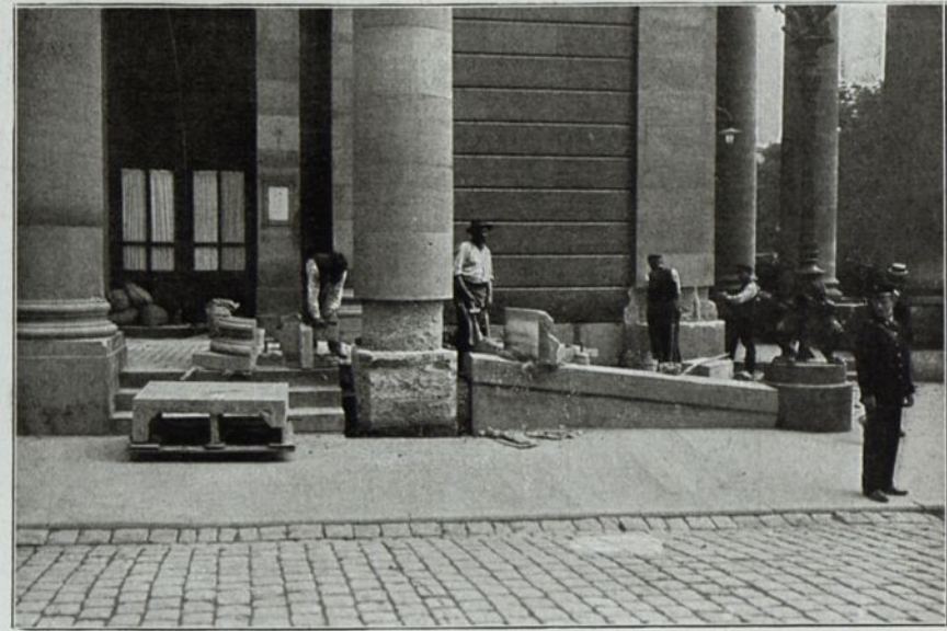
Abb. 167. Königsbau in Stuttgart, Ersatz der Säulenfüße durch Betonstein. Ausgeführt von der Firma E. Schwenk, Ulm a. D.
