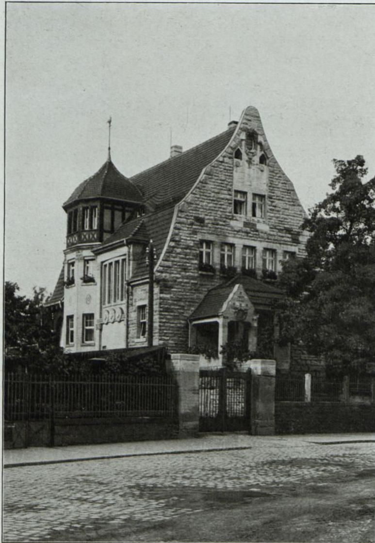
Abb. 51. Wohnhaus J. W. Roth, Zittau i. S.
