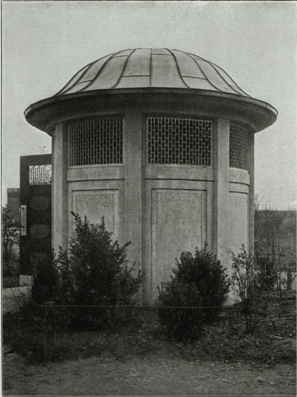
Abb. 98. Bedürfnishäuschen in Frankfurt a. M. Ausgeführt von der Firma E. Schwenk, Ulm a. D.
