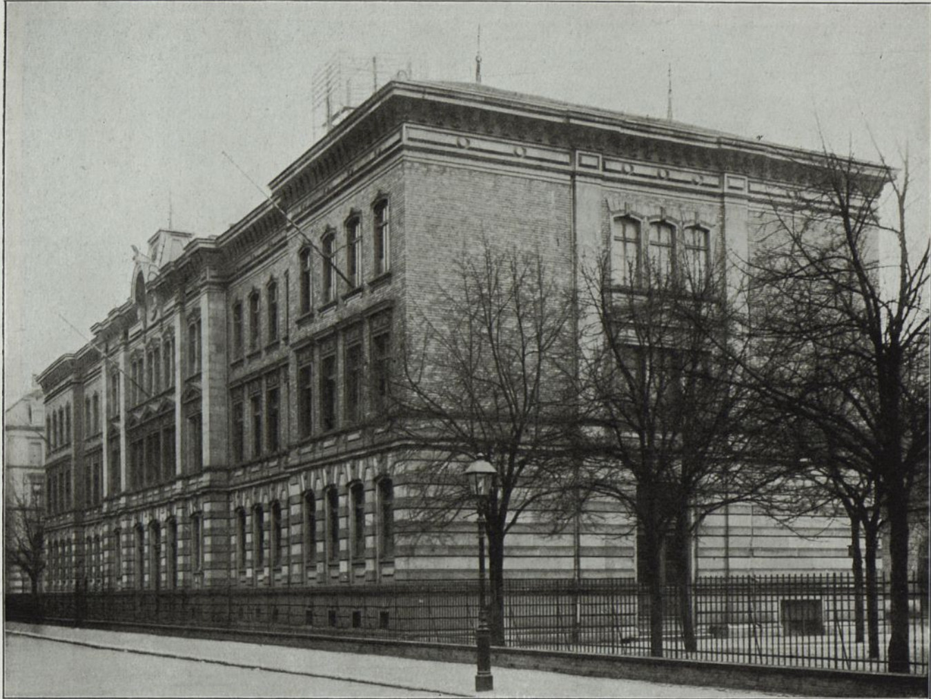
Abb. 24. Doppelschule in Sachsenhausen. Betonwerksteine der Firma Dyckerhoff & Widmann, Biebrich.
