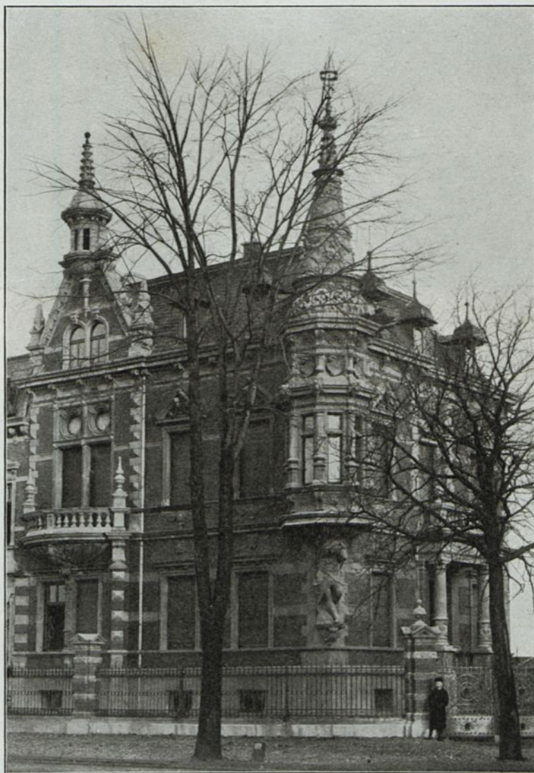
Abb. 39. Landhaus J. Schilbers bei Krefeld. Betonwerksteine der Firma Carstanjen & Co., Duisburg.
