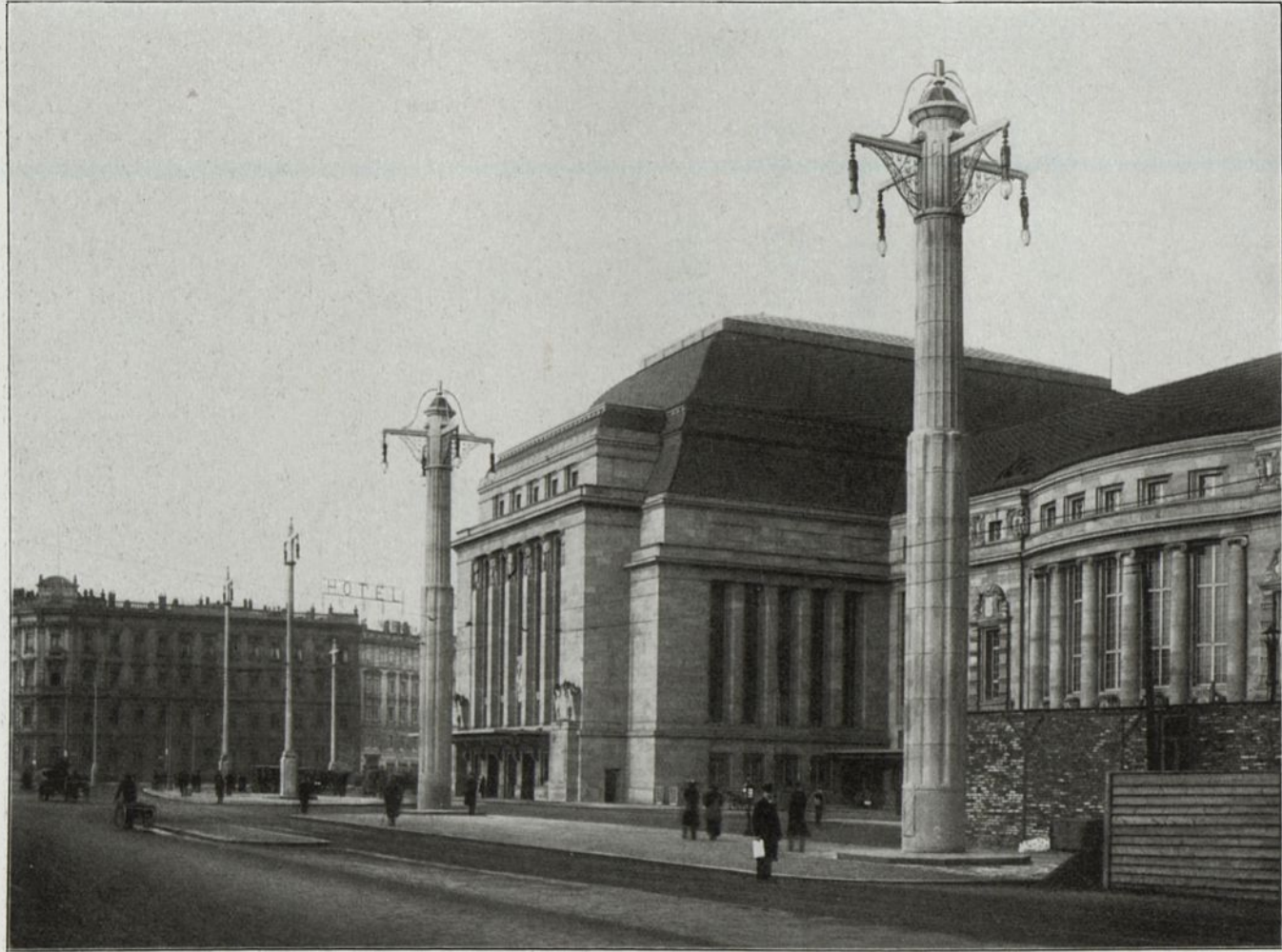
Abb. 201. Vierarmiger Eisenbetonmast vor dem Hauptbahnhof in Leipzig. Ausgeführt von der Firma Rud. Wölle, Leipzig.
