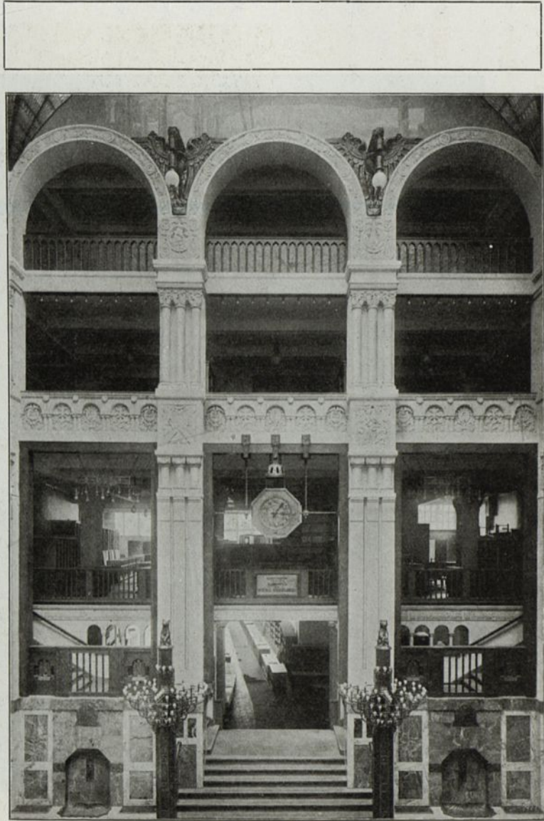
Abb. 65. Lichthof im Warenhaus Zandorf, Berlin. Betonsteinausführungen der Firma M. Czarnikow & Cie., Berlin.
