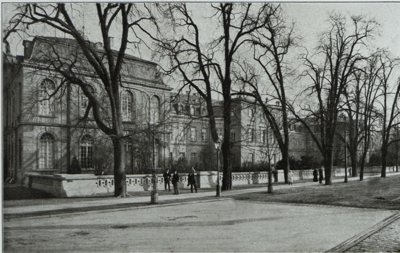
Abb. 106. Einfriedigung des Königl. Residenzschlosses in Stuttgart. Betonwerksteine der Firma Steinfabrik Ulm (heute D. Leube), Ulm a. D.
