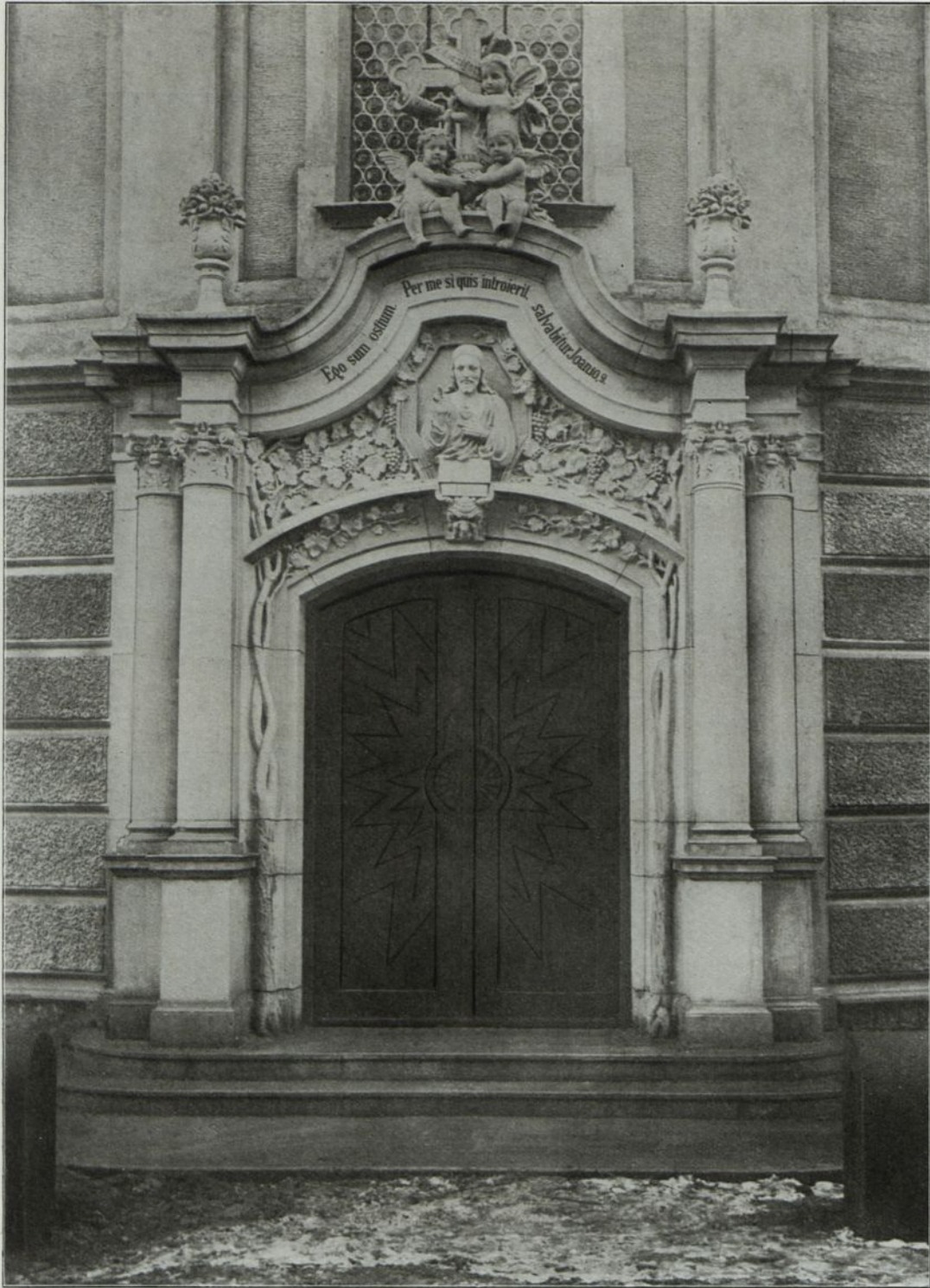
Abb. 109. Katholische Pfarrkirche in Nesselwang. Betonwerksteine der Firma E. Schwenk, Ulm a. D.
