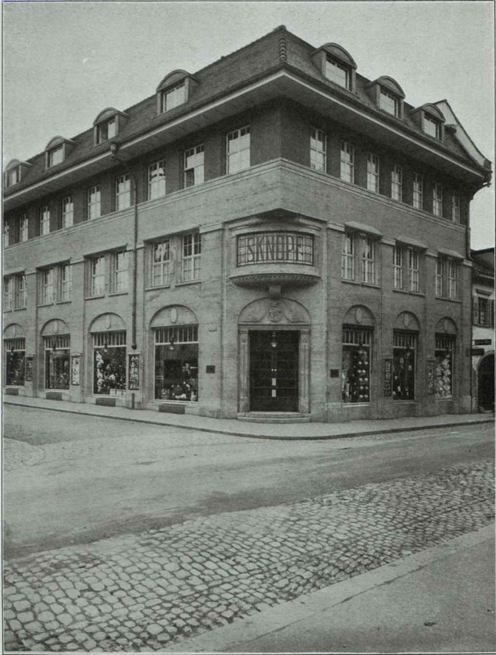
Abb. 66. Warenhaus Knopf, Lörrach i. B. Ausgeführt von der Firma Brenzinger & Cie., Freiburg i. B.
