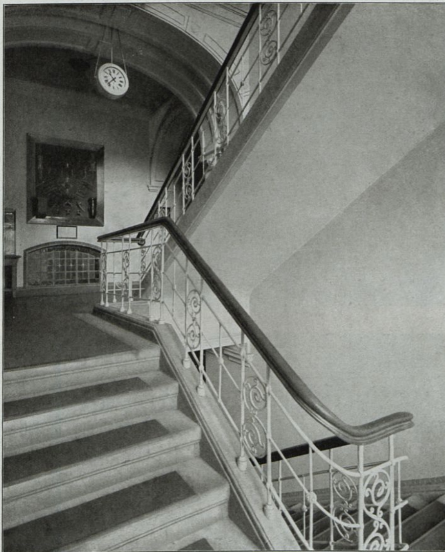
Abb. 131. Treppe in der Techn. Hochschule zu Breslau.
