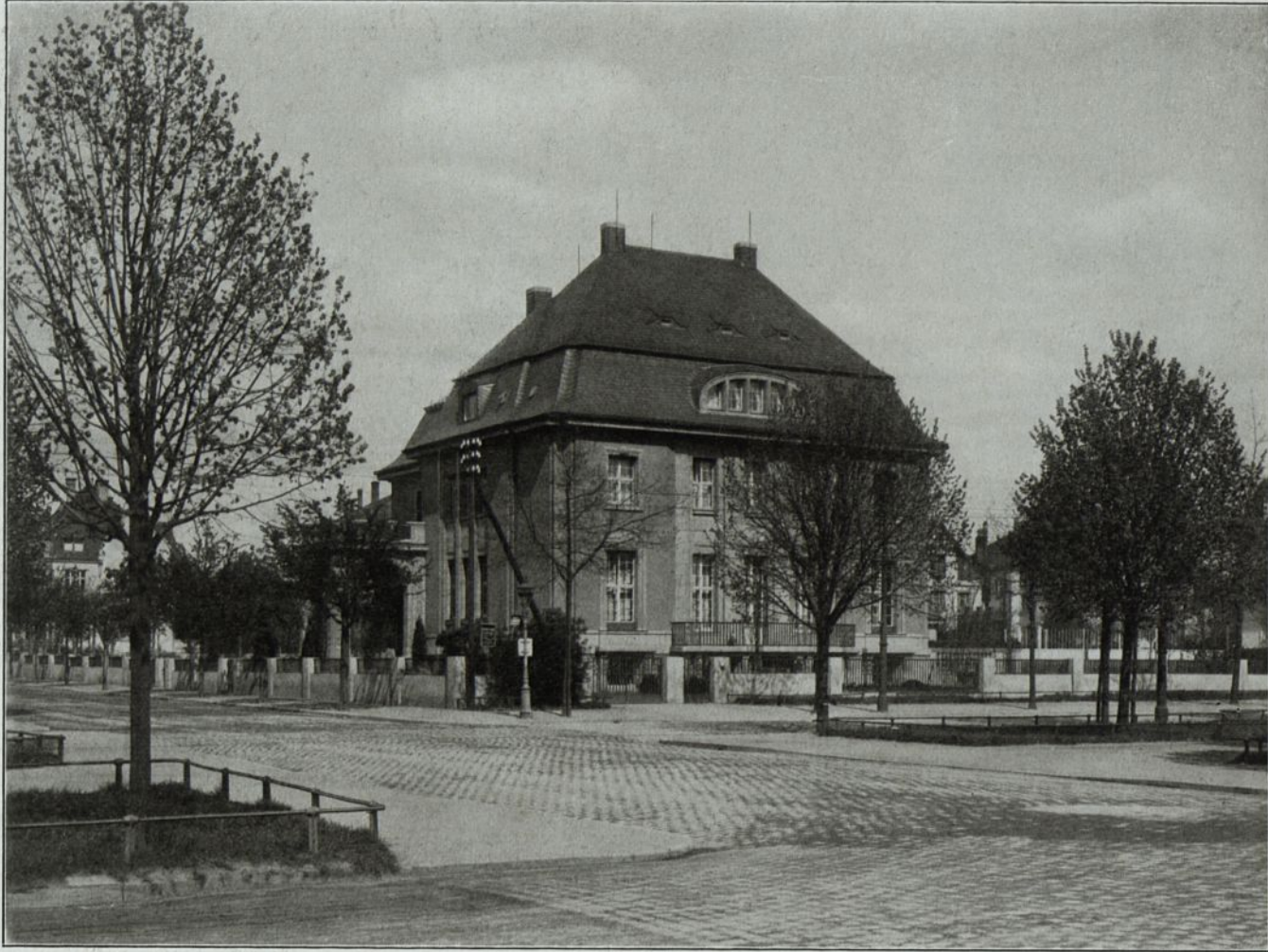
Abb. 57. Wohnhaus Langelott, Dresden. Betonwerksteine der Firma Windschild & Langelott, Dresden.
