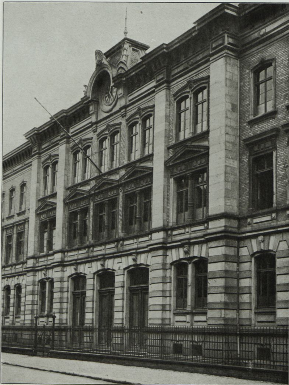
Abb. 22. Adlerfluchtsschule in Frankfurt a.M. Betonwerksteine der Firma Dyckerhoff & Widmann, Viebrich.
