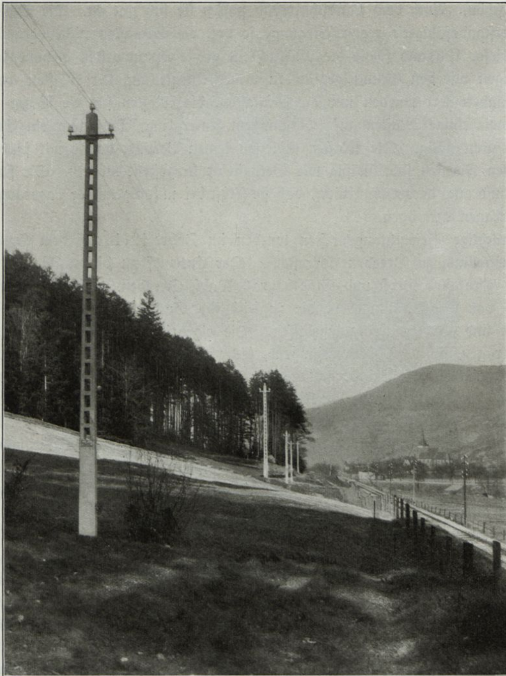
Abb. 198. Eisenbetonmasten bei Lautenbach. Geliefert von der Firma Brenzinger & Cie., Freiburg.
