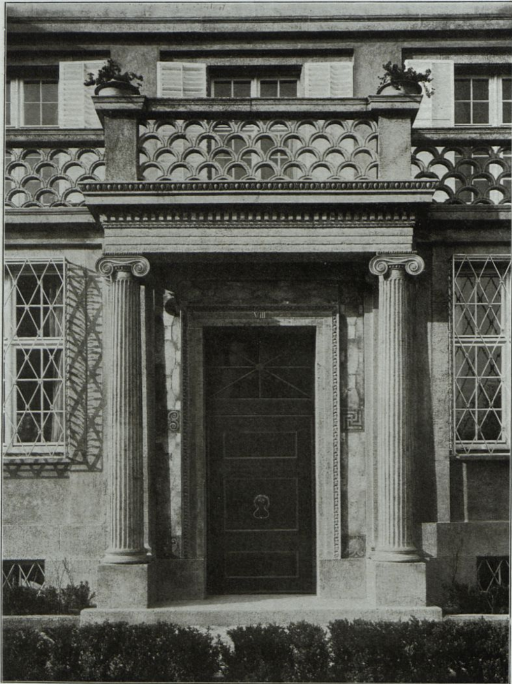
Abb. 111. Villa Adolf Dietler in Freiburg i. B. Betonwerksteine der Firma Brenzinger & Cie., Freiburg i. B.
