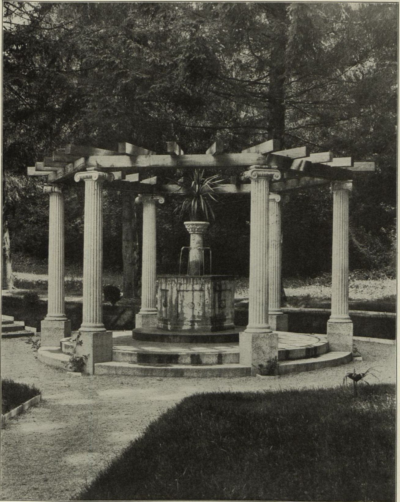
Abb. 170. Thermalquelle in Sulzburg. Betonwerksteine der Firma Brenzinger & Cie., Freiburg i. B.
