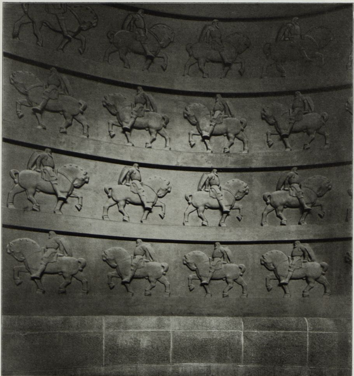
Abb. 206. Völkerschlachtdenkmal bei Leipzig, Kuppelunterficht. Betonarbeiten der Firma Rud. Wolle, Leipzig.
