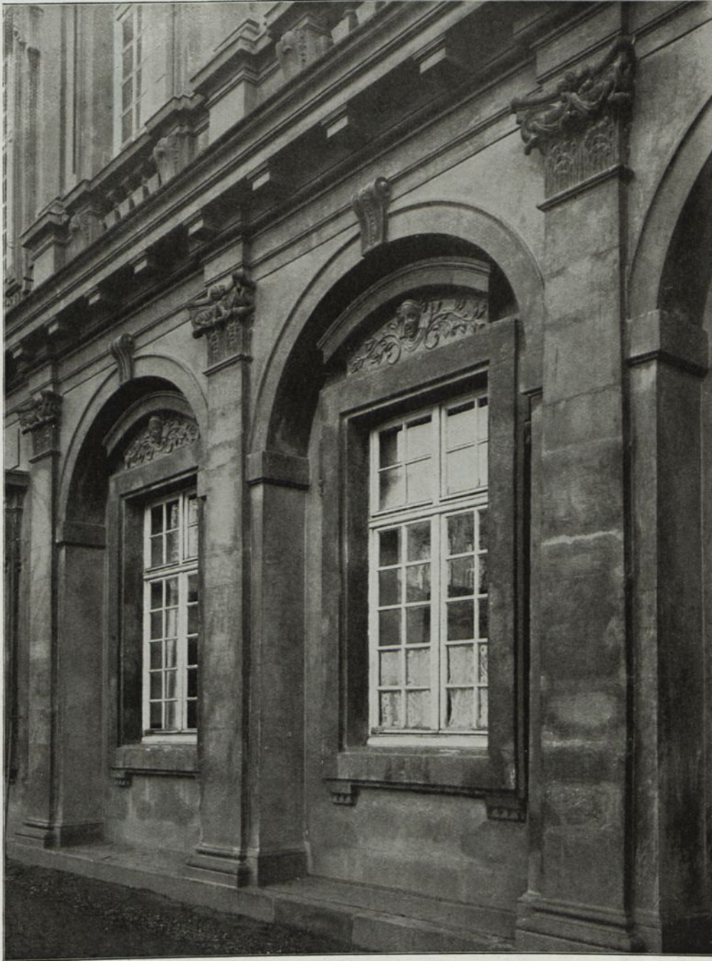
Abb. 19. Kapitäle am Großherzoglichen Schloß in Rastatt. Geliefert von der Firma Dyckerhoff & Widmann, Karlsruhe.
