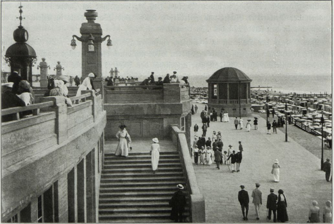
Abb. 226. Wandelhalle in Borkum, Blick gegen die Freitreppe. Ausgeführt von der Firma Paul Koffel & Cie., Bremen.
