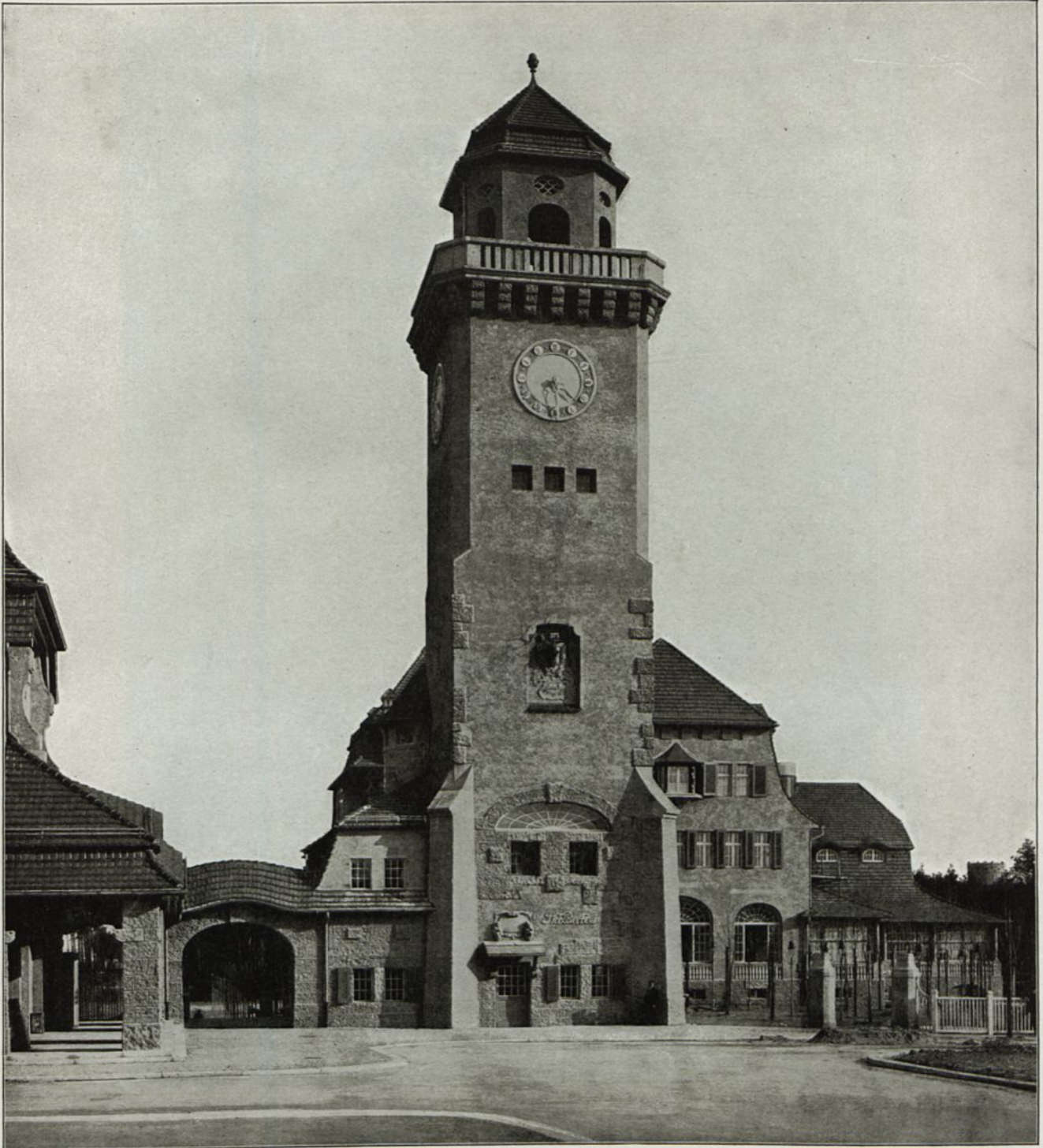
Abb. 89. Wasserturm und Kasinogebäude in der Gartenstadt Frohnau. Betonsteinarbeiten der Firma Windschild & Langelott, Charlottenburg.
