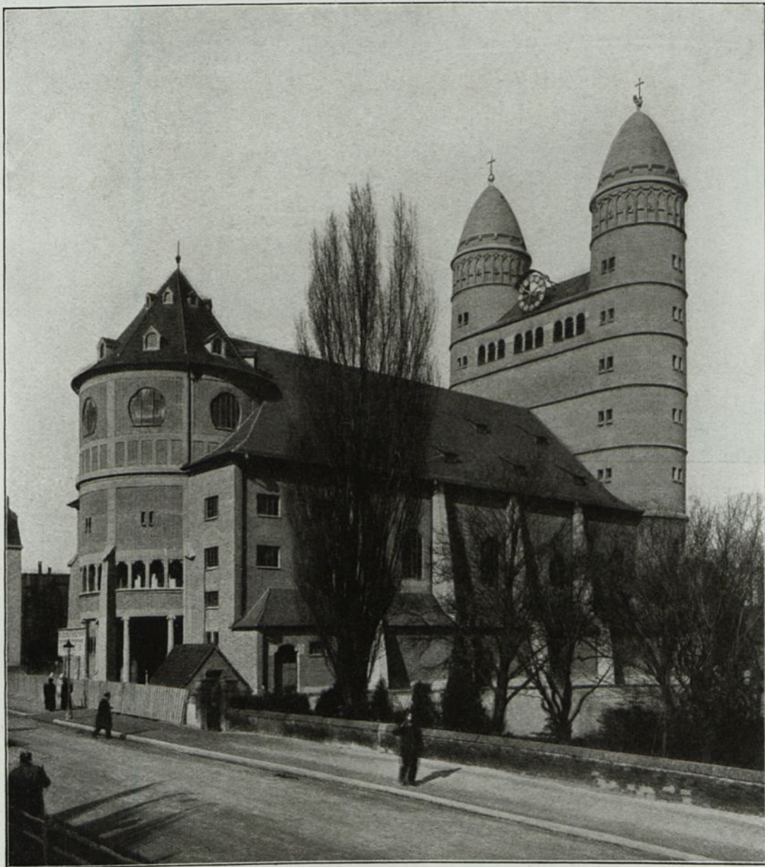
Abb. 210. Garnisonkirche zu Ulm a. D. Ausgeführt von der Firma Dyckerhoff & Widmann, A.-G., Karlsruhe.
