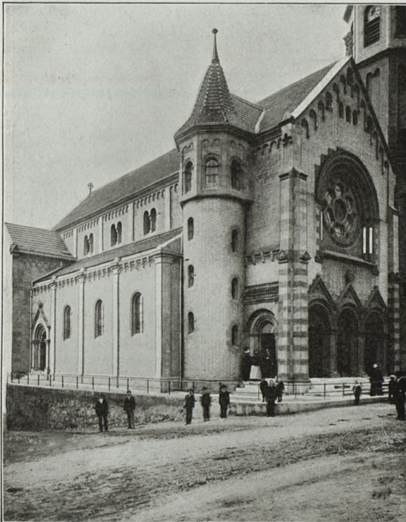
Abb. 42. Kirche in Unterkochem. Betonwerksteine der Firma Schobinger & Rehfuß (heute D. Leube), Ulm a. D.
