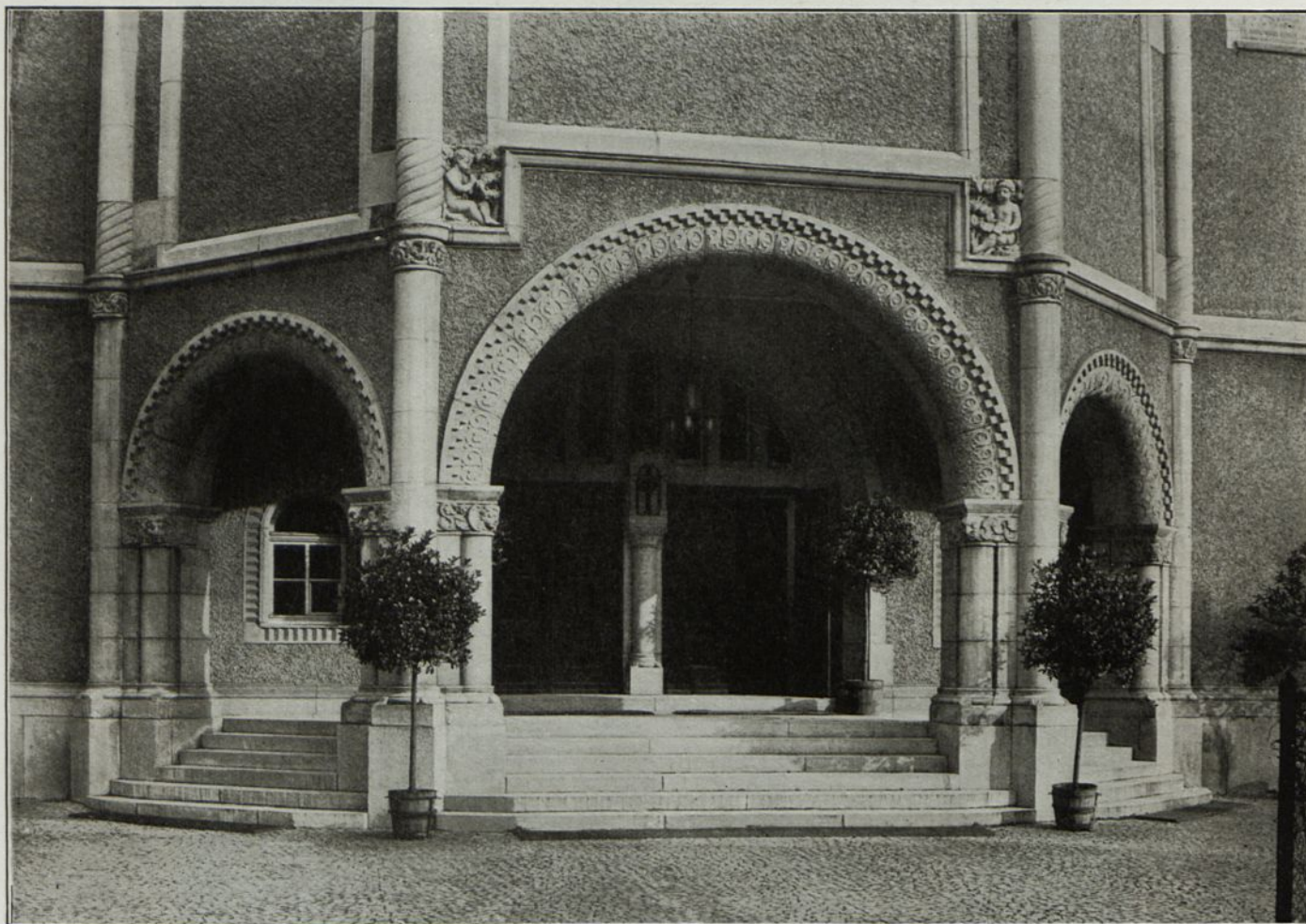
Abb. 100. Evangelisches Gemeindehaus in Freiburg i. B. Betonwerksteine der Firma Brenzinger & Cie., Freiburg i. B.
