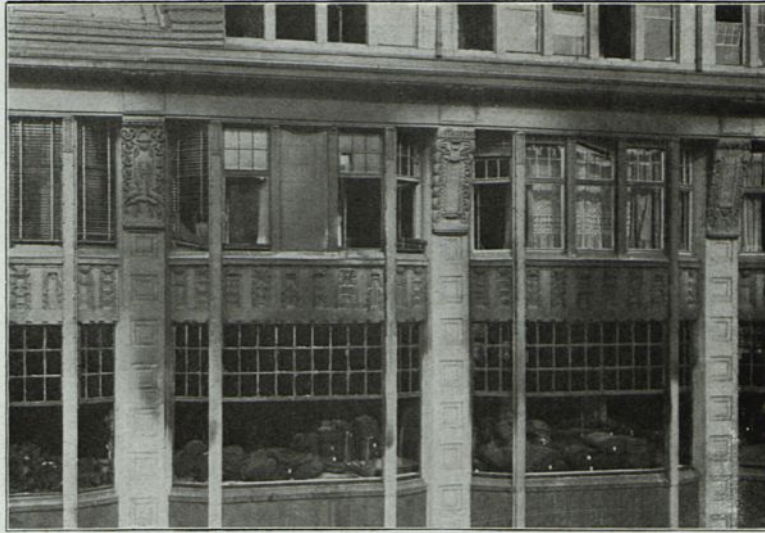
Abb. 240. Warenhaus Esders, Dresden, Betonfassade nach dem Brande. Ausführung der Betonarbeiten durch die Firma Kell & Löfer, Dresden-Leipzig.
