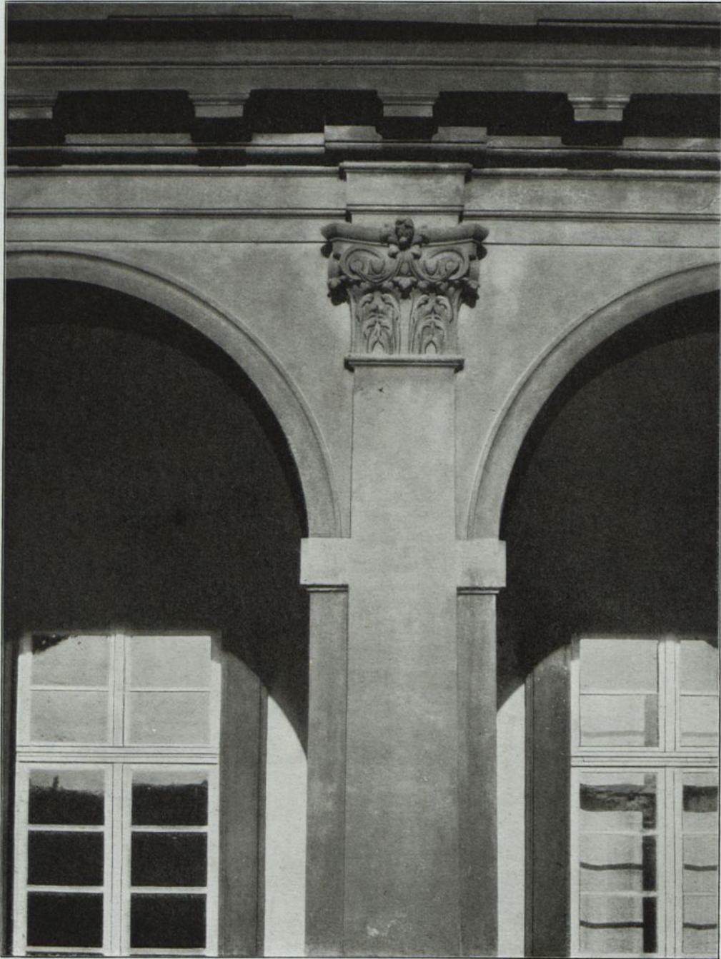
Abb. 20. Kapitäle am Großherzoglichen Schloß in Rastatt. Geliefert von der Firma Dyckerhoff & Widmann, Karlsruhe.
