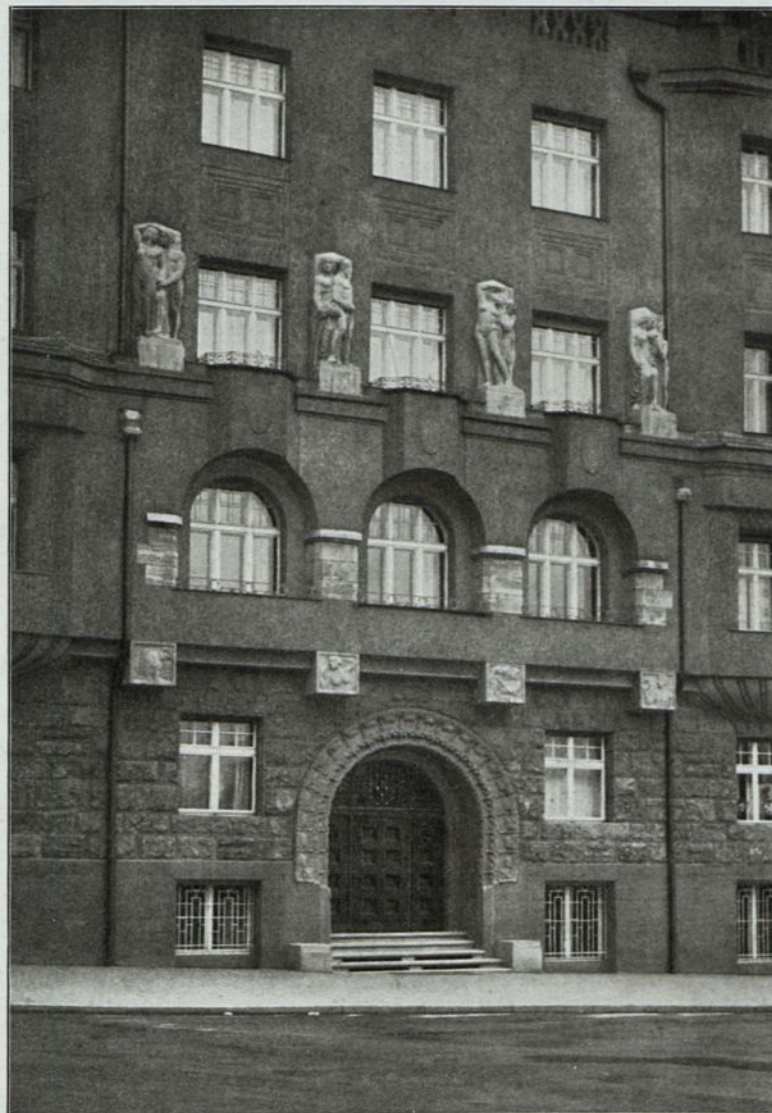
Abb. 52. Neubau Böckler, Nürnberg.
