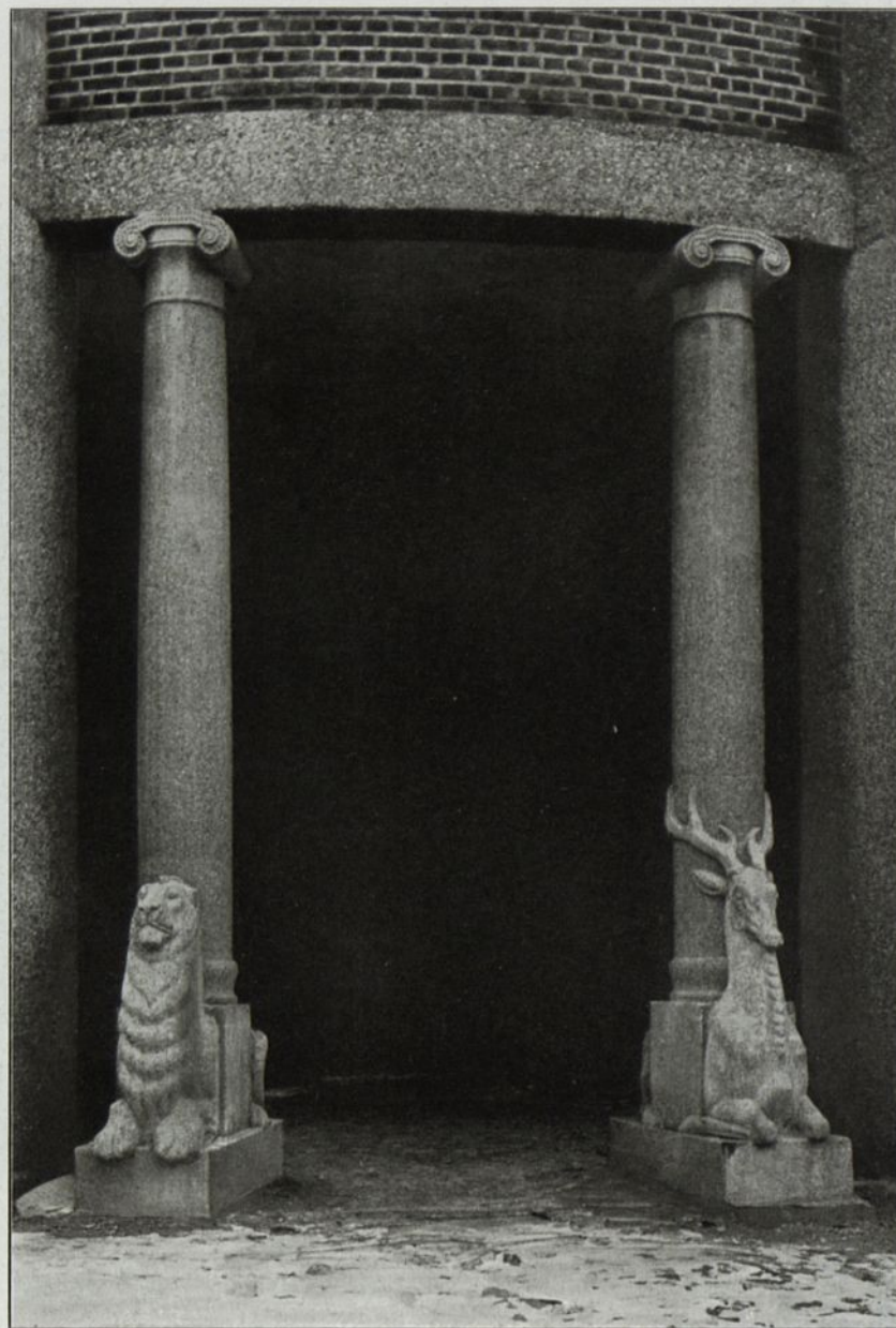
Abb. 212. Garnisonkirche zu Ulm a. D. Ausgeführt von der Firma Dyckerhoff & Widmann, A.-G., Karlsruhe.
