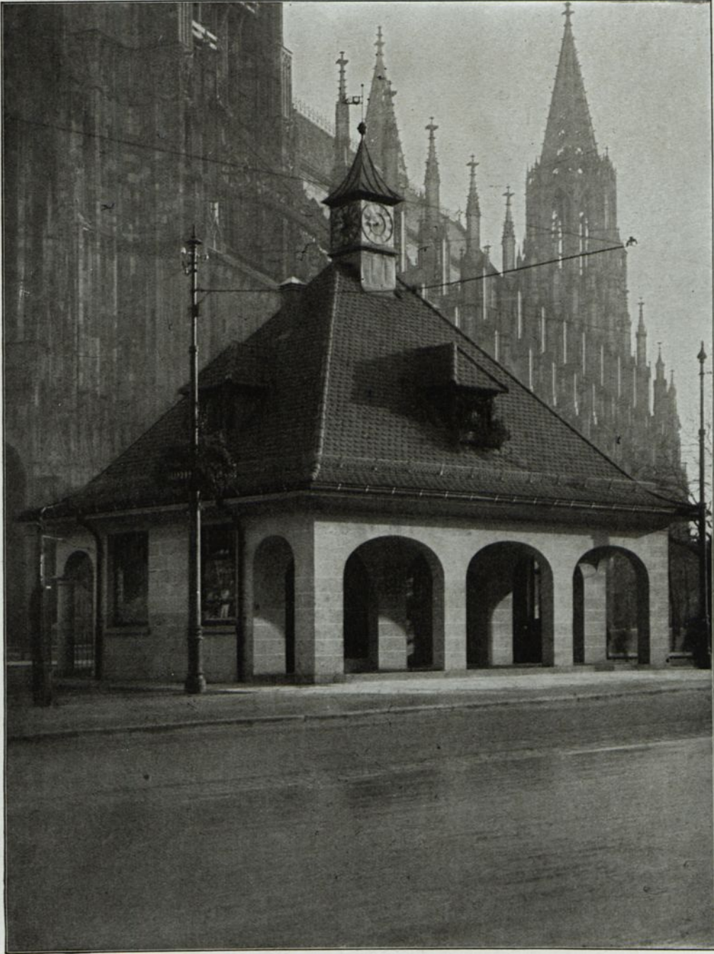
Abb. 91. Wartehaus am Münsterplatz in Ulm a. D. Betonsteine der Firma E. Schwenk, Ulm a. D.
