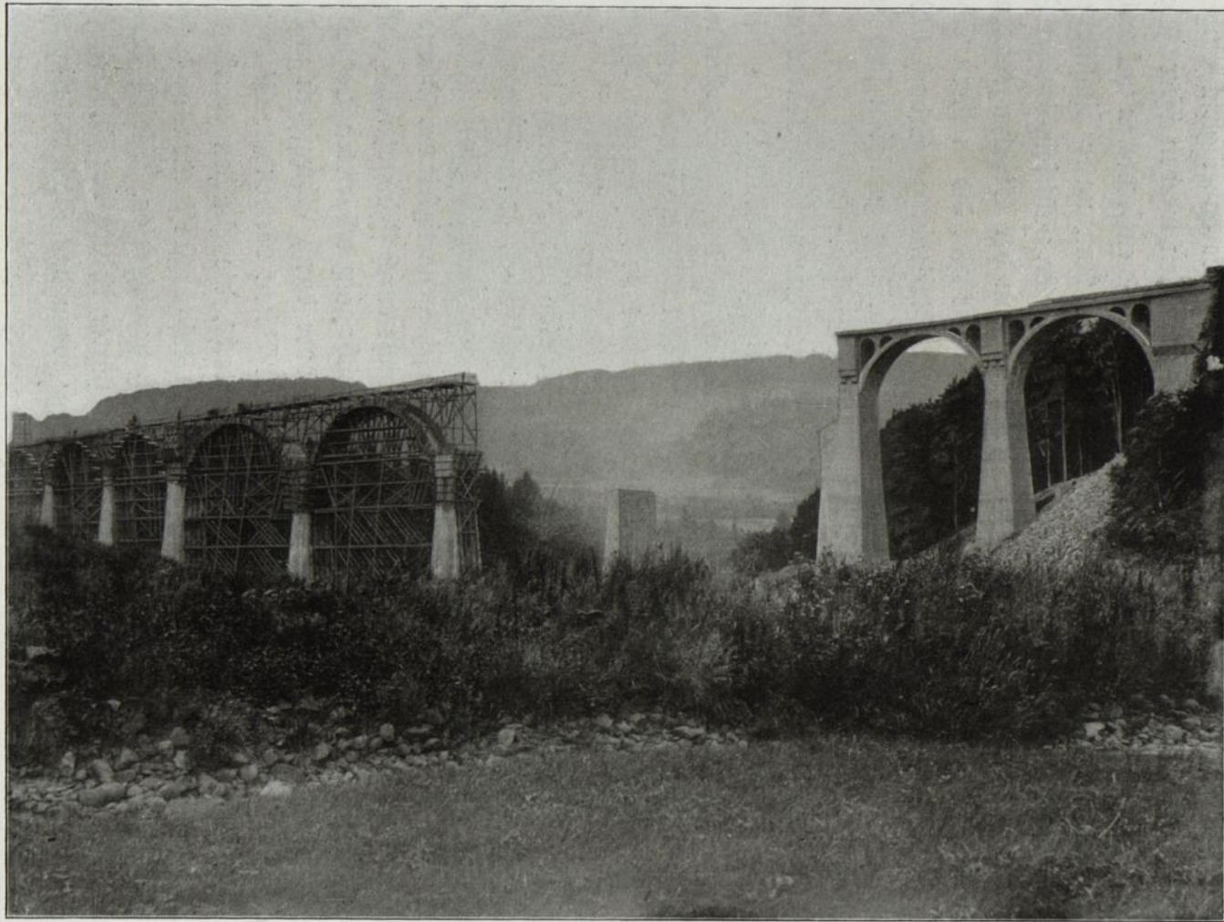
Abb. 204. Talbrücke bei Erbach (Westerwald). Ausgeführt von der Firma Hüfer & Cie., Oberkassel (Siegtreis).
