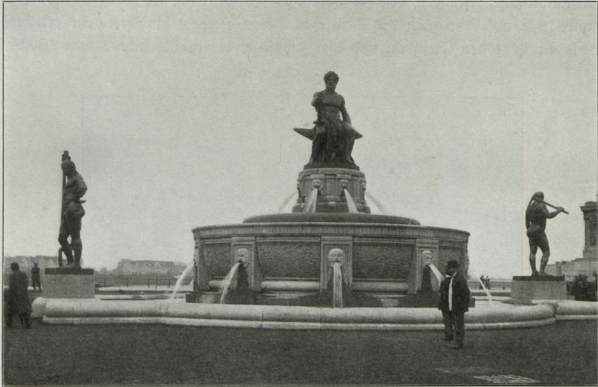
Abb. 141. Monumentalbrunnen Düsseldorf. Ausführung der Betonsteinarbeiten Firma E. Schwent, Ulm a. D.
