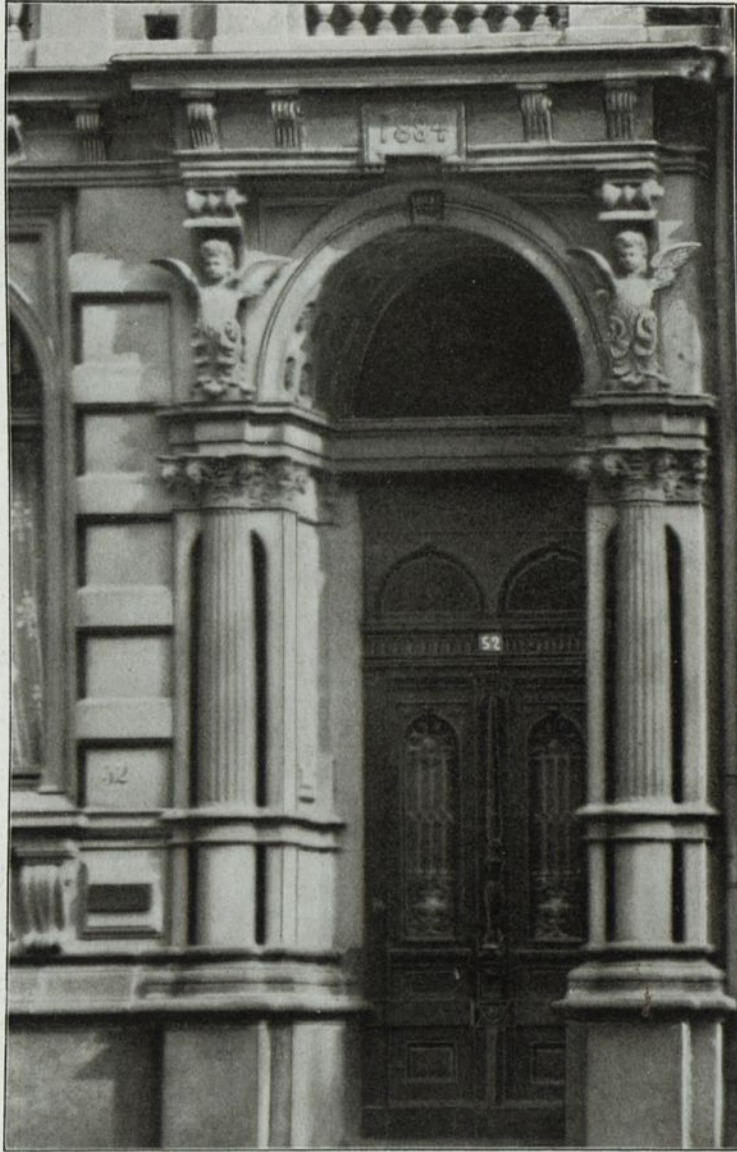
Abb. 30. Wohnhaus in Köln, Hohenzollernring 52, Hauseingang. Betonwerksteine der Firma Hüser & Cie., Oberkassel (Siegtkreis).
