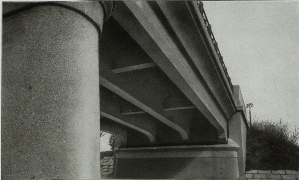
Abb. 272. Donaubrücke bei Mengen. Ausgeführt von der Firma S. Ref, Stuttgart.
