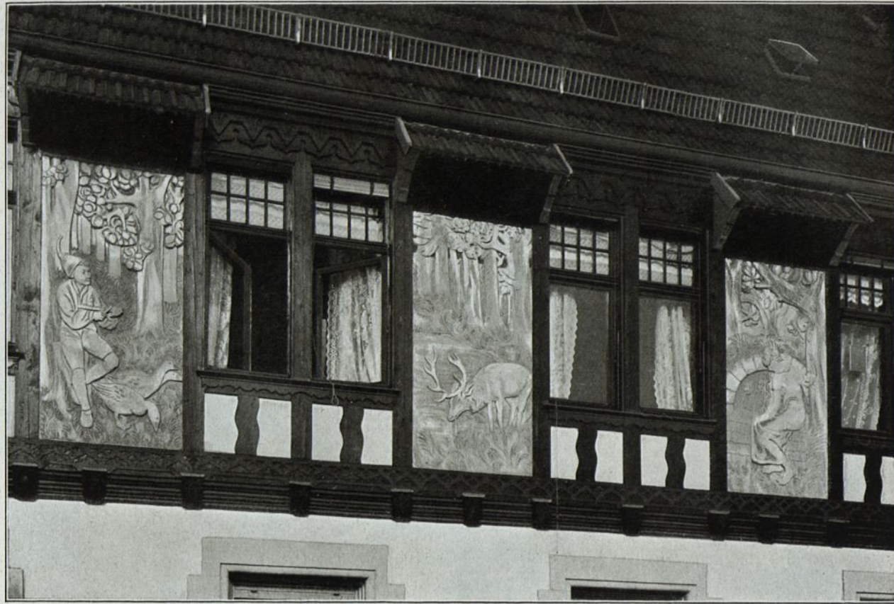
Abb. 174. Haus Lenze in Ehlingen. Betonwerksteine der Firma Steinfabrik Alm (heute D. Leube), Alm a. D.
