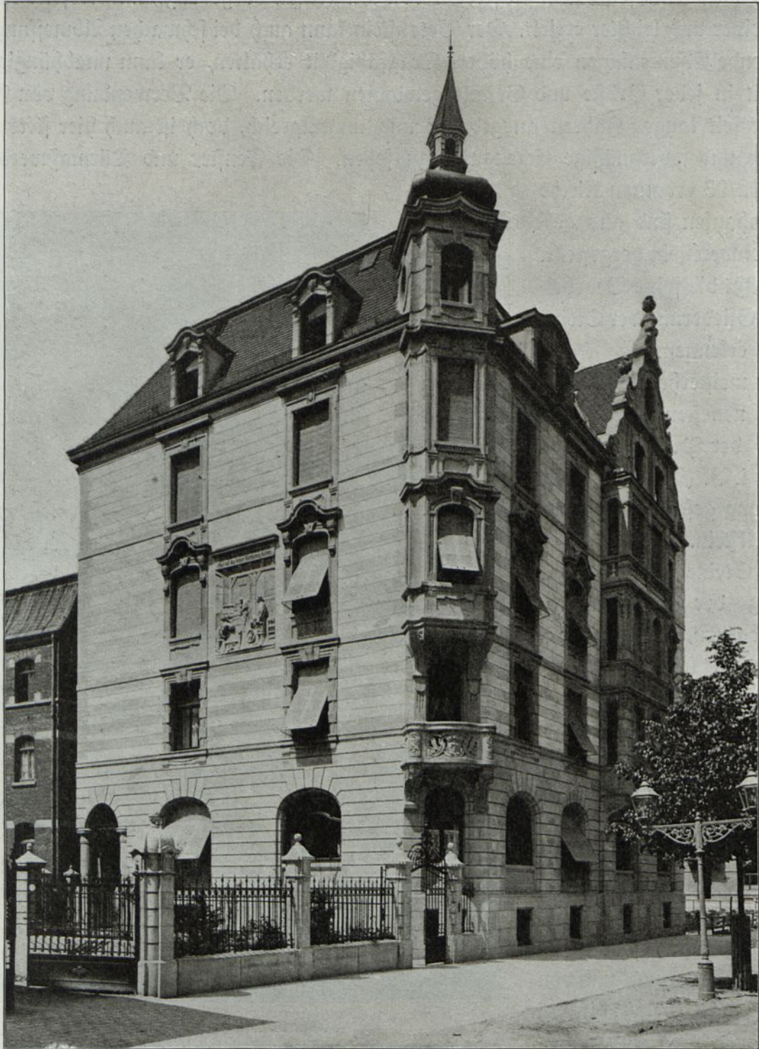
Abb. 49. Wohnhaus in Ulm a. D. Betonwerksteine der Firma E. Schwenk, Ulm a. D.
