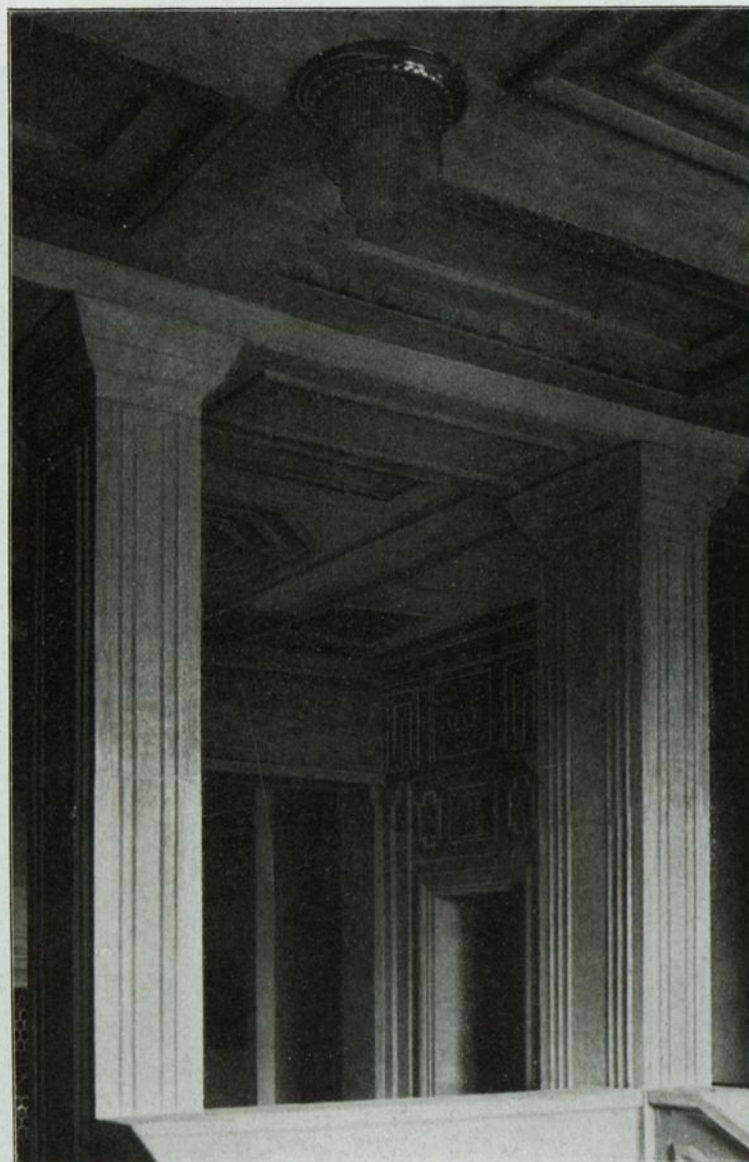
Abb. 79. Verwaltungsgebäude der Emschergenossenschaft, Essen a. R. Betonsteinarbeiten der A.-G. für Beton- und Monierbau, Berlin, Zweiggeschäft Essen.
