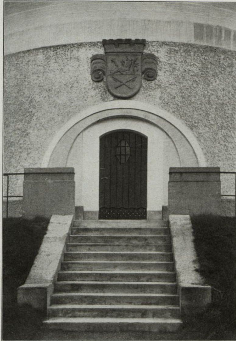
Abb. 257. Portal und Stadtwappen am Wasserturm Sockenheim.
