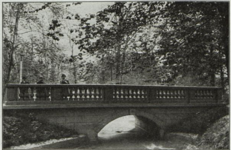
Abb. 37. Brücke im Englischen Garten zu München. Betonsteine der Firma E. Schwenk, Ulm a. D.
