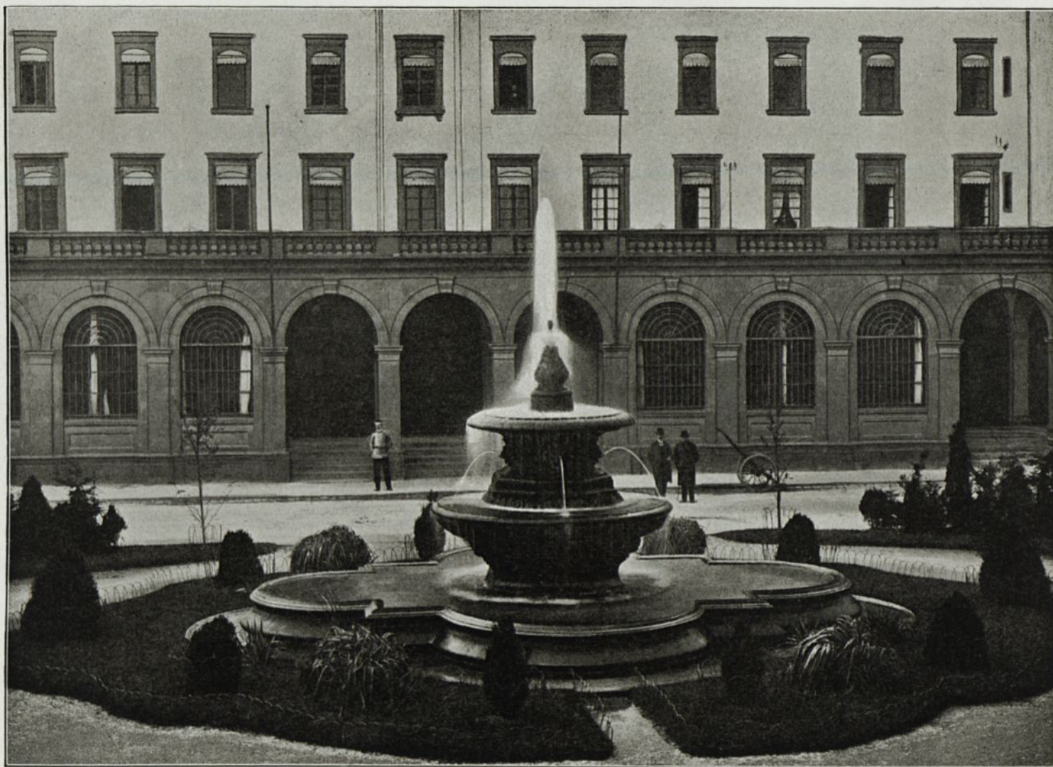
Abb. 46. Brunnen auf dem Bahnhofplatz in Ulm a. D. Ausgeführt von der Firma E. Schwent, Ulm a. D.
