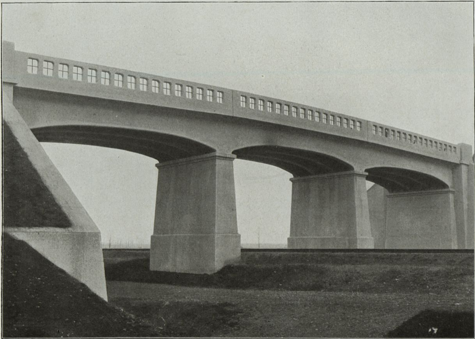
Abb. 269. Straßenüberführung bei Laupheim. Ausgeführt von der Firma H. Reß, Stuttgart.
