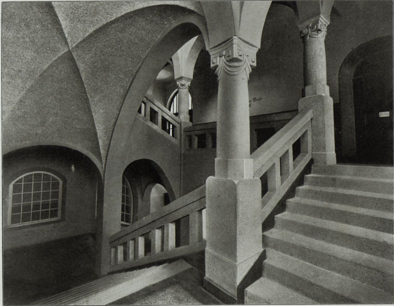
Abb. 221. Kreuzgewölbe in der Nordschule zu Jena. Ausgeführt von der Firma Dyckerhoff & Widmann, A.-G., Nürnberg.
