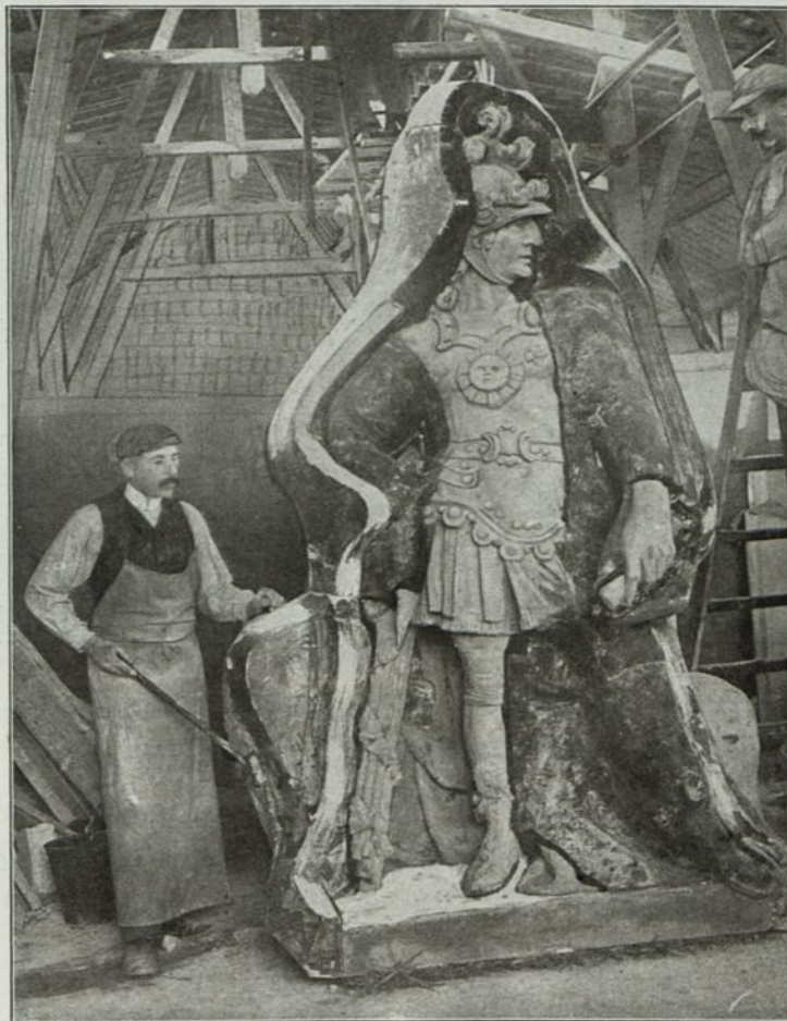
Abb. 193. Herstellung der Form für die Betonsteinfigur. Ausgeführt von der Firma E. Schwenk, Ulm a. D.
