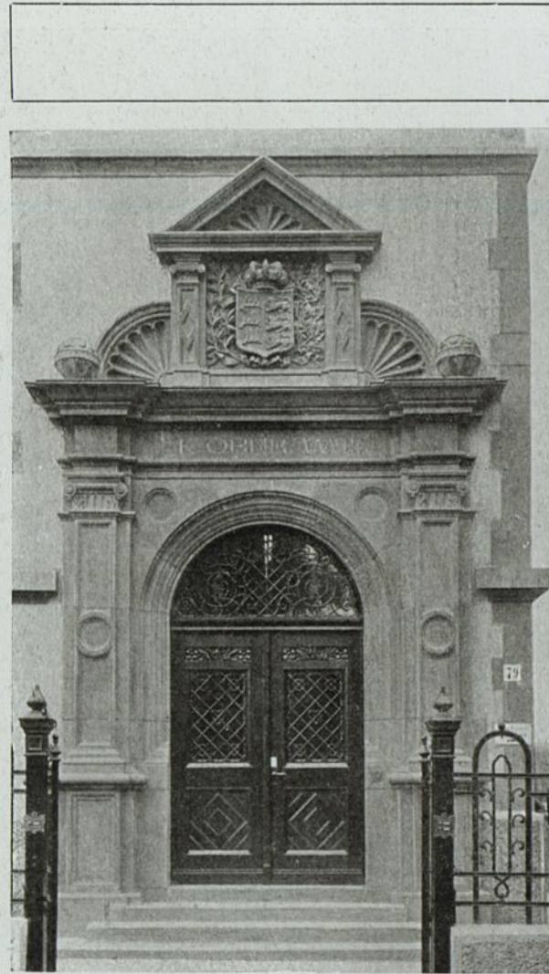
Abb. 108. Königl. Oberamteigebäude in Ulm a. D. Betonwerksteine der Firma E. Schwenk, Ulm a. D.
