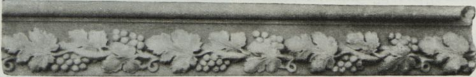
Abb. 4. Ältere Kunststeinerzeugnisse. Ausgeführt von der Firma Hüser & Cie., Oberkassel (Siegkreis).
