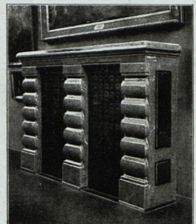
Abb. 182. Heizkörperverkleidung. Ausgeführt von der Firma Allmer Kunststein- und Betonwerk, Inhaber Otto Leube, Ulm a. D.
