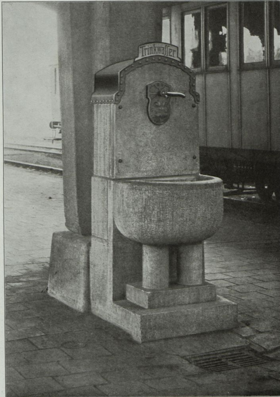
Abb. 145. Trinkbrunnen, Hauptbahnhof Nürnberg.
