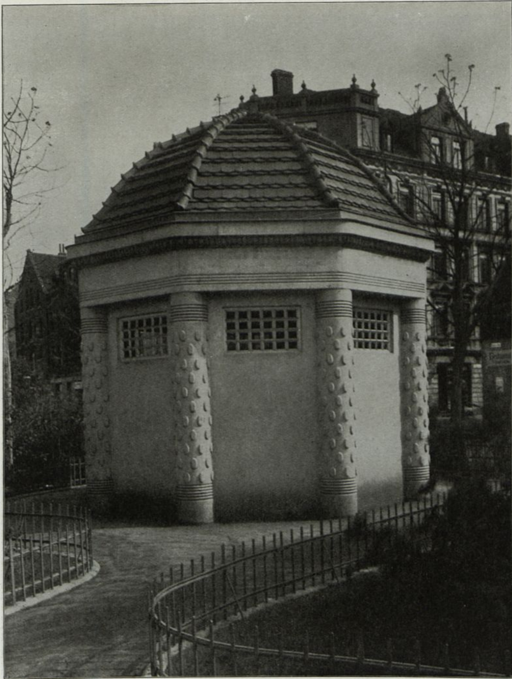
Abb. 93. Bedürfnisanstalt am Kontinentalplatz, Hannover. Ausgeführt von der Firma Otte & Fölsch, Hannover.
