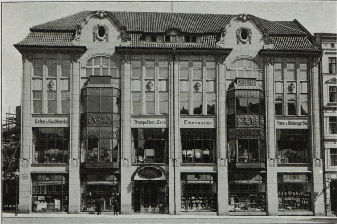
Abb. 63. Geschäftshaus „Trompetter & Geck“, Stettin. Ausgeführt von der Firma „Comet“, Stettin.
