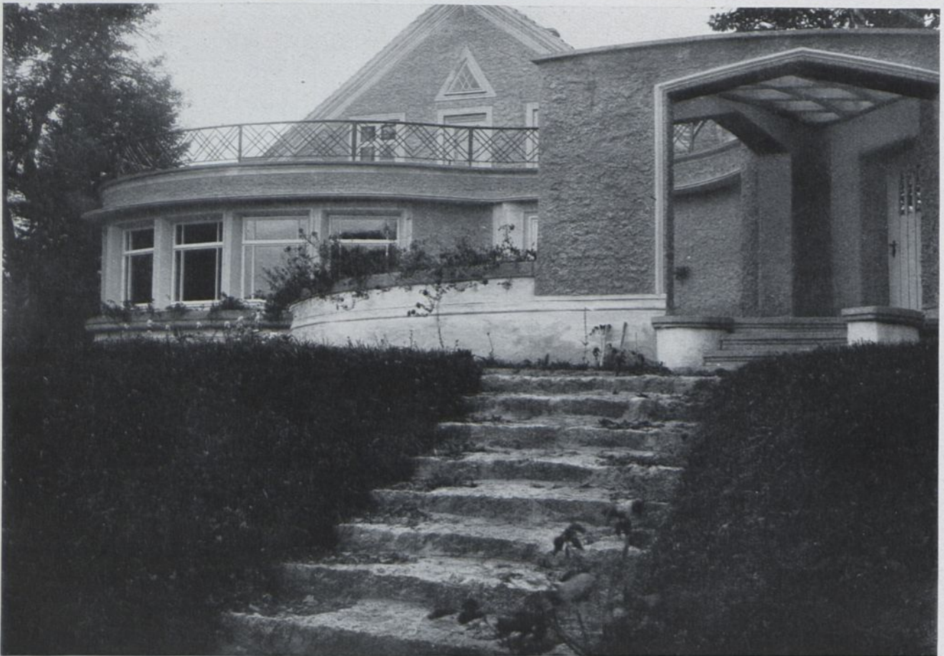
Anbau am Gutshause Albat, Sautilten (Ostpr.)
