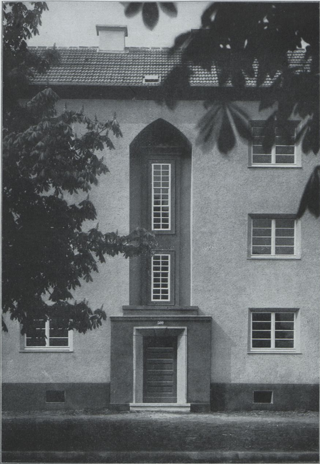
Siedlung Mauenheim. Fassadendetail Neußer Str.
