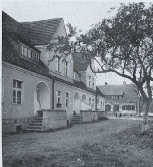
ARBEITERHAUSER in Mittelteilau
