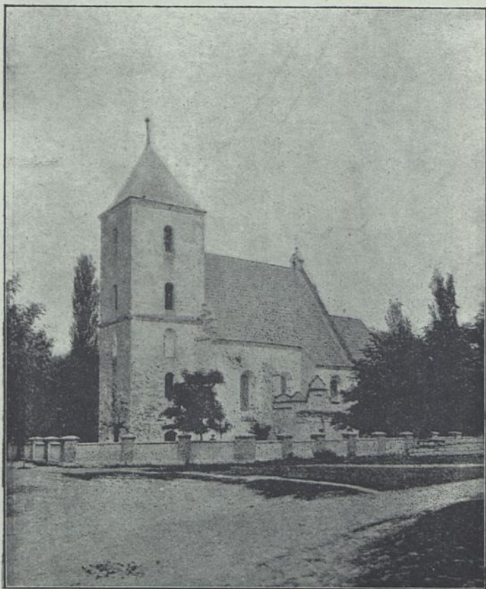
Fig. 7. Kościół paraf. w Chojnem przed przebudową wieży.
