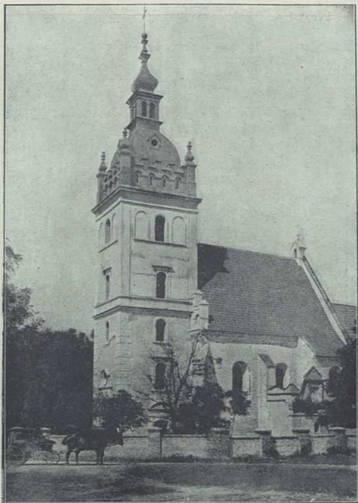
Fig. 8. Kościół paraf. w Chojnem, po przebudowie wieży. Przykład ujemny.
