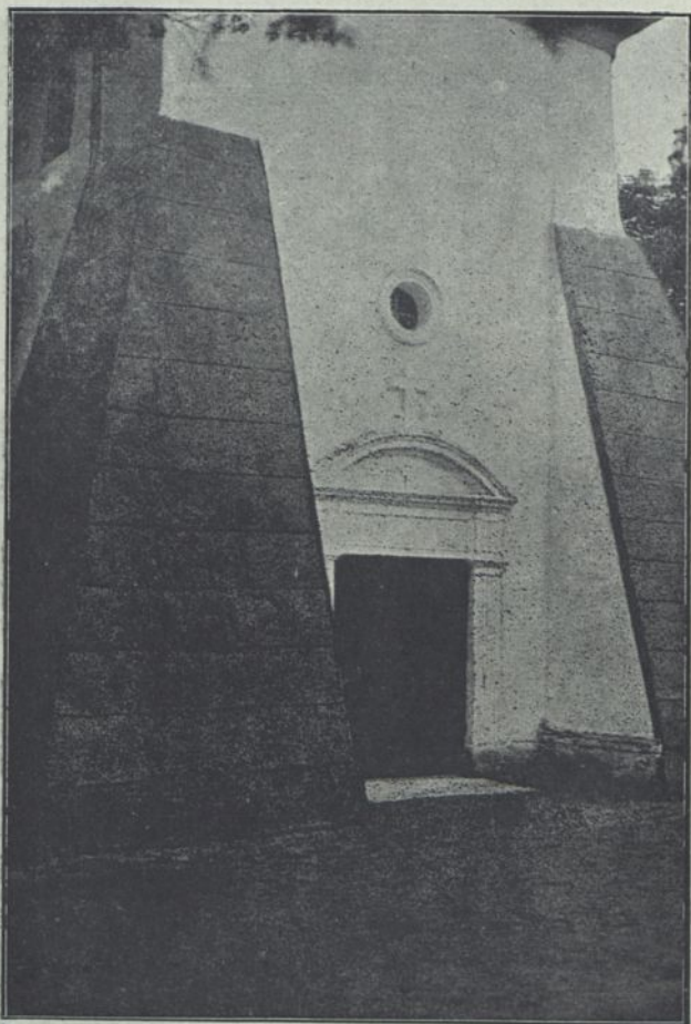
Fig. 17. Fragment kościoła parafjalnego w Skierbieszowie. Przykład ujemny zastosowania blachy do pokrycia skarp.
