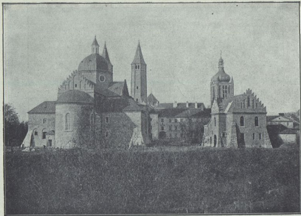
Fig. 6. Katedra Płocka po restauracji, dokonanej w latach 1901—1903. Przykład ujemny.
