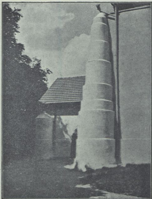
Fig. 20. Fragment kościoła parafjalnego w Piasecznie, współczesnego i pokrewnego kościołowi w Serocku. Przykład ujemny otynkowania murów.
