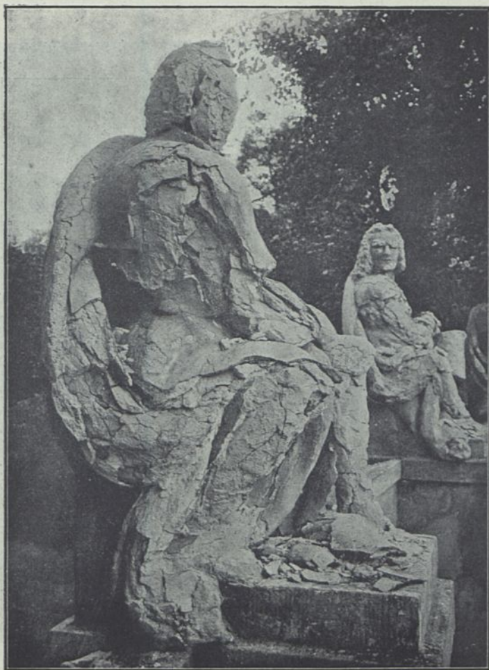
Fig. 24. Te same figury po dokonanej restauracji zaprawą cementową. Wygląd z r. 1917 po jednej zimie bez przykrycia.
