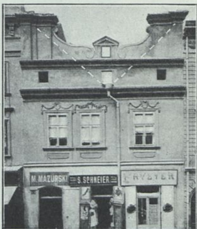
Rys. 89. Kraków. Dom przy ul. Sławkowskiej. (Attyka o linii, załamanej po środku, odpowiada spadkom dachu wkłęsłego oznaczonym na rysunku linią kropkowaną).
