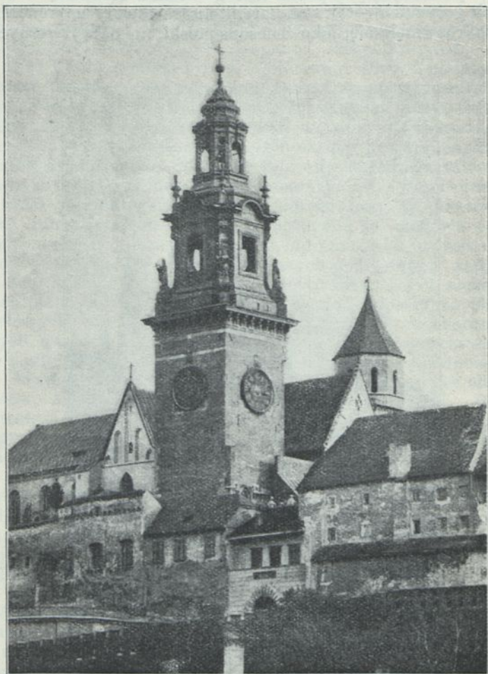
Rys. 74. Kraków. Wieża zegarowa katedry na Wawelu.
