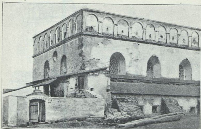
Rys. 139. Bóznica w Satanowie nad Zbruczem na Podolu. Dach wklęsły, osłonięty attyką ze strzelnicami.
