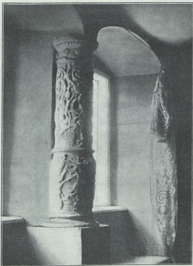
Rys. 199. Okno bliźnie w kamienicy pod Ś. Krzysztofem w Kazimierzu Dolnym.
