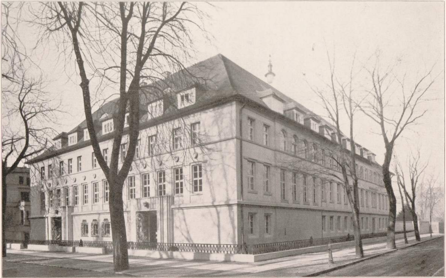
Verwaltungsgebäude der Industrie- und Handelskammer für die Provinz Oberschlesien
