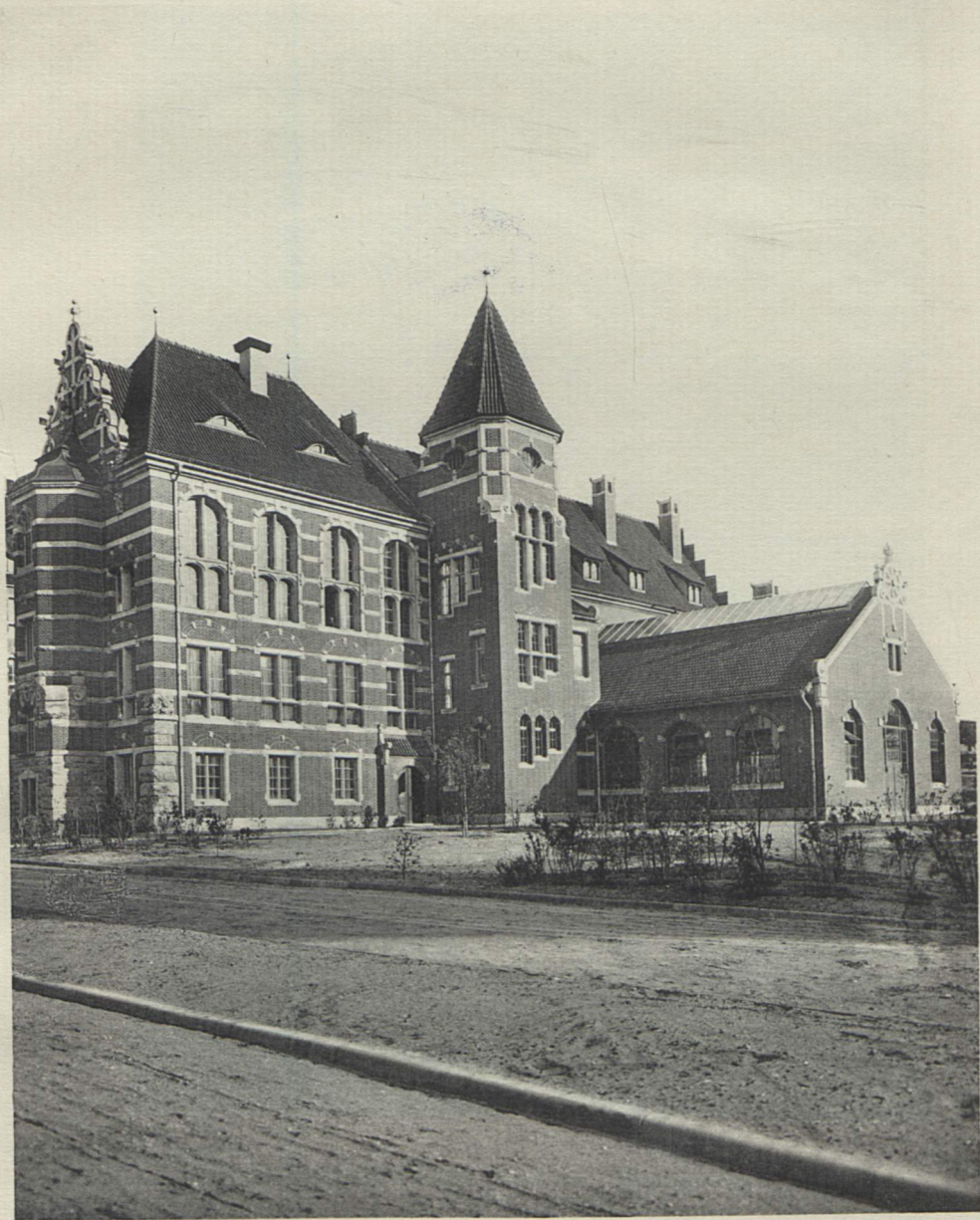
Elektrotechnisches Institut. Blick auf die Westseite.
