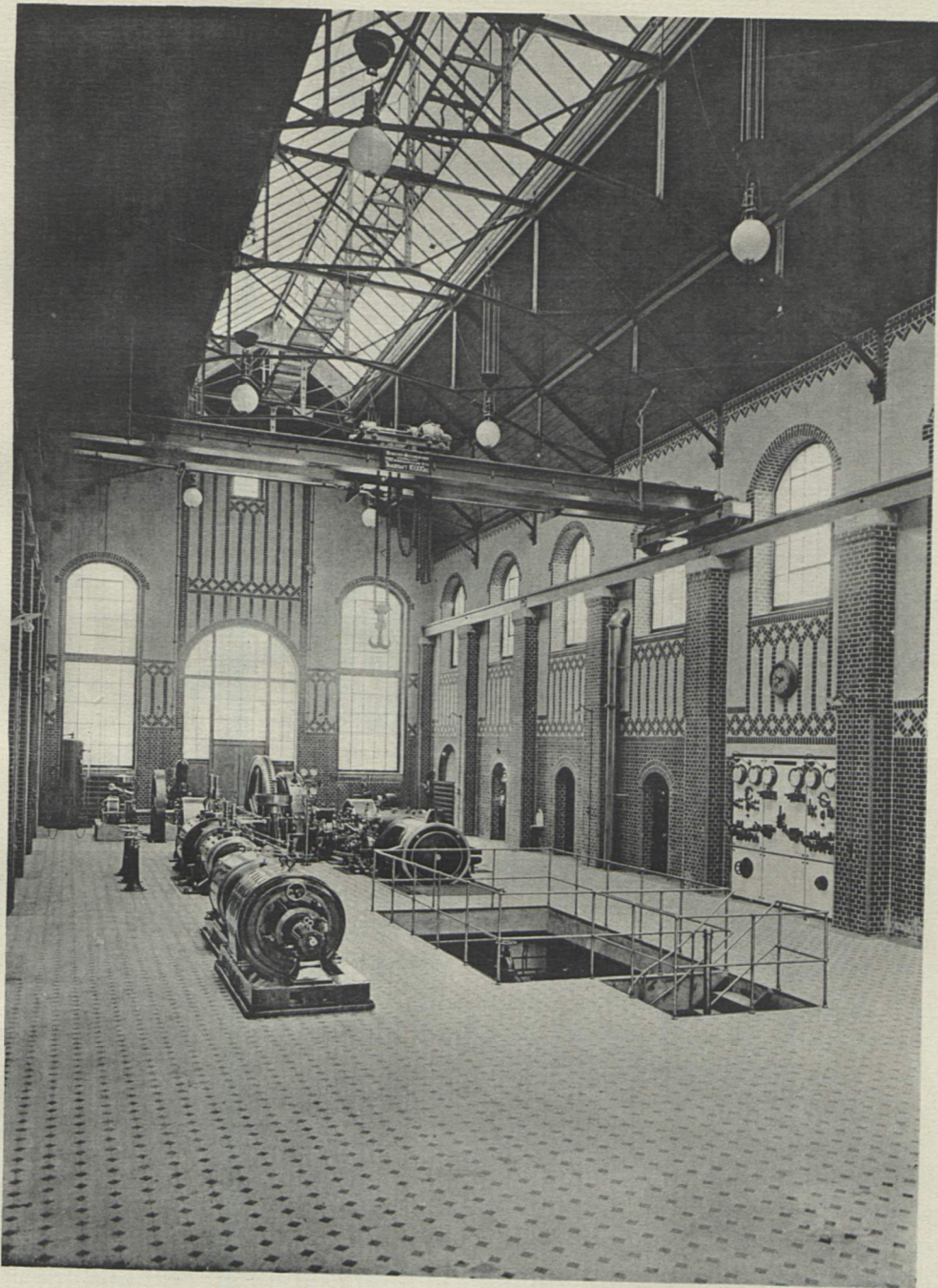
Inneres der Maschinenhalle.
