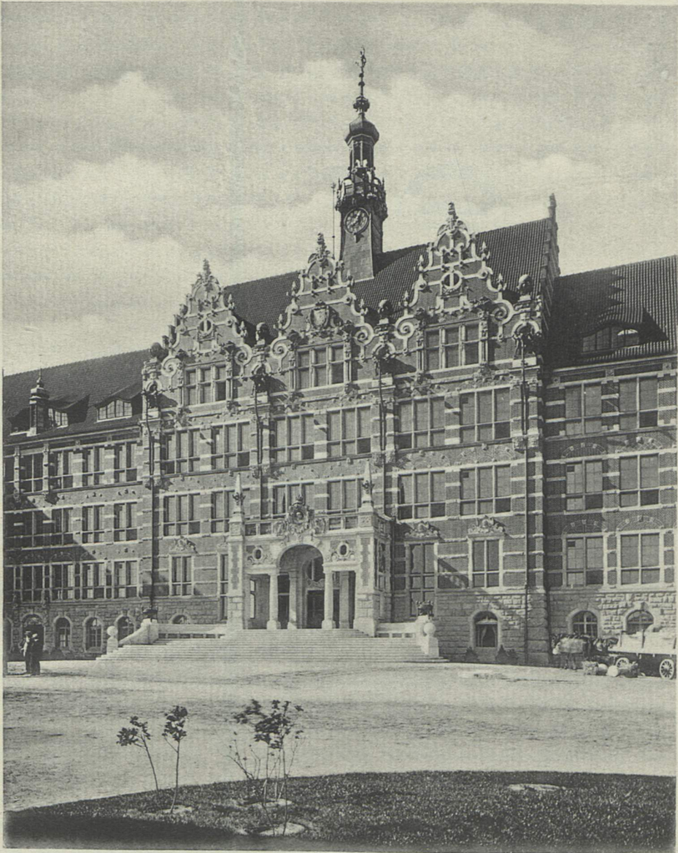
Hauptgebäude. Mittelbau und Haupteingang.
