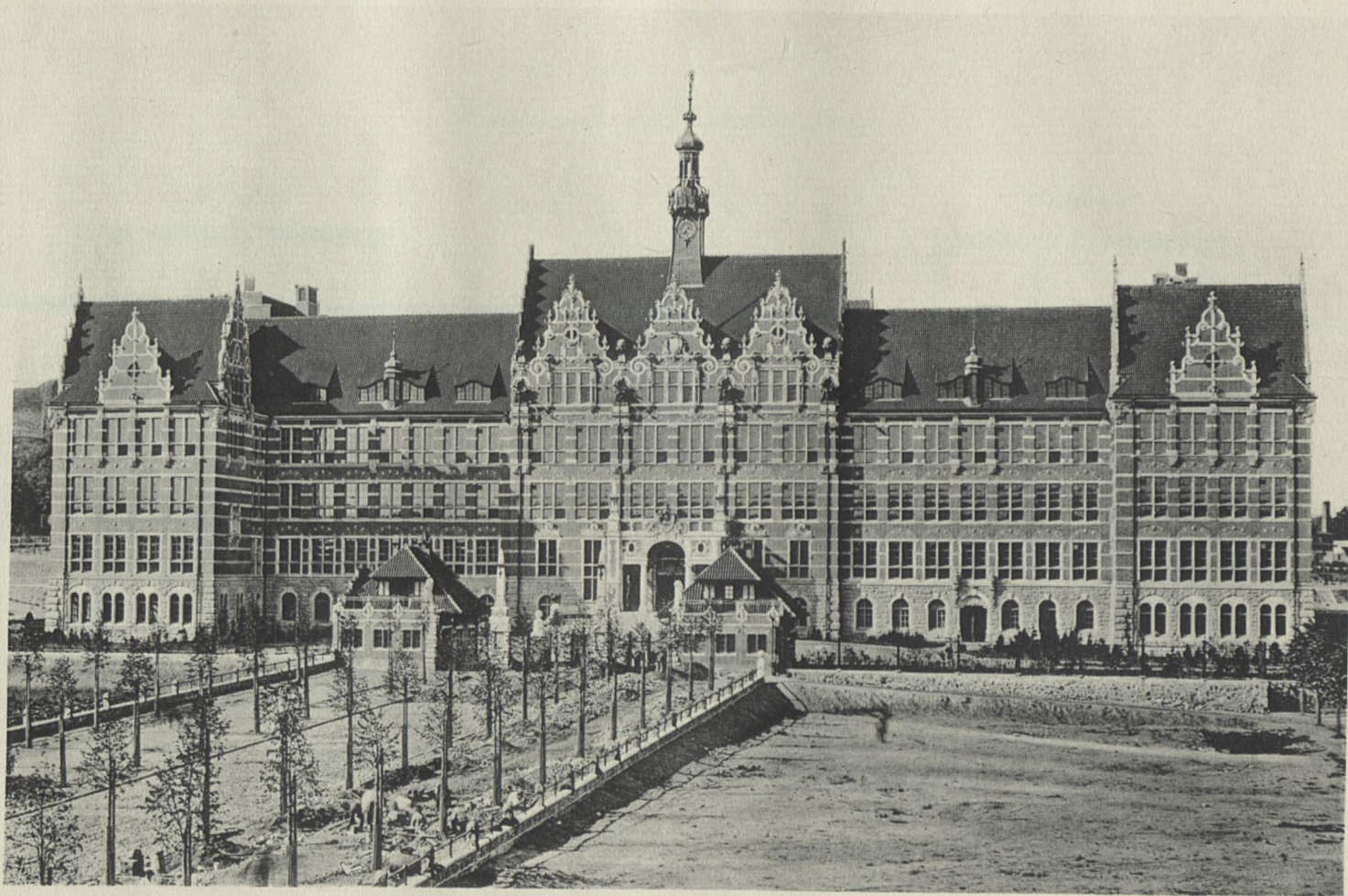
Hauptgebäude. Blick auf die Nordseite.
