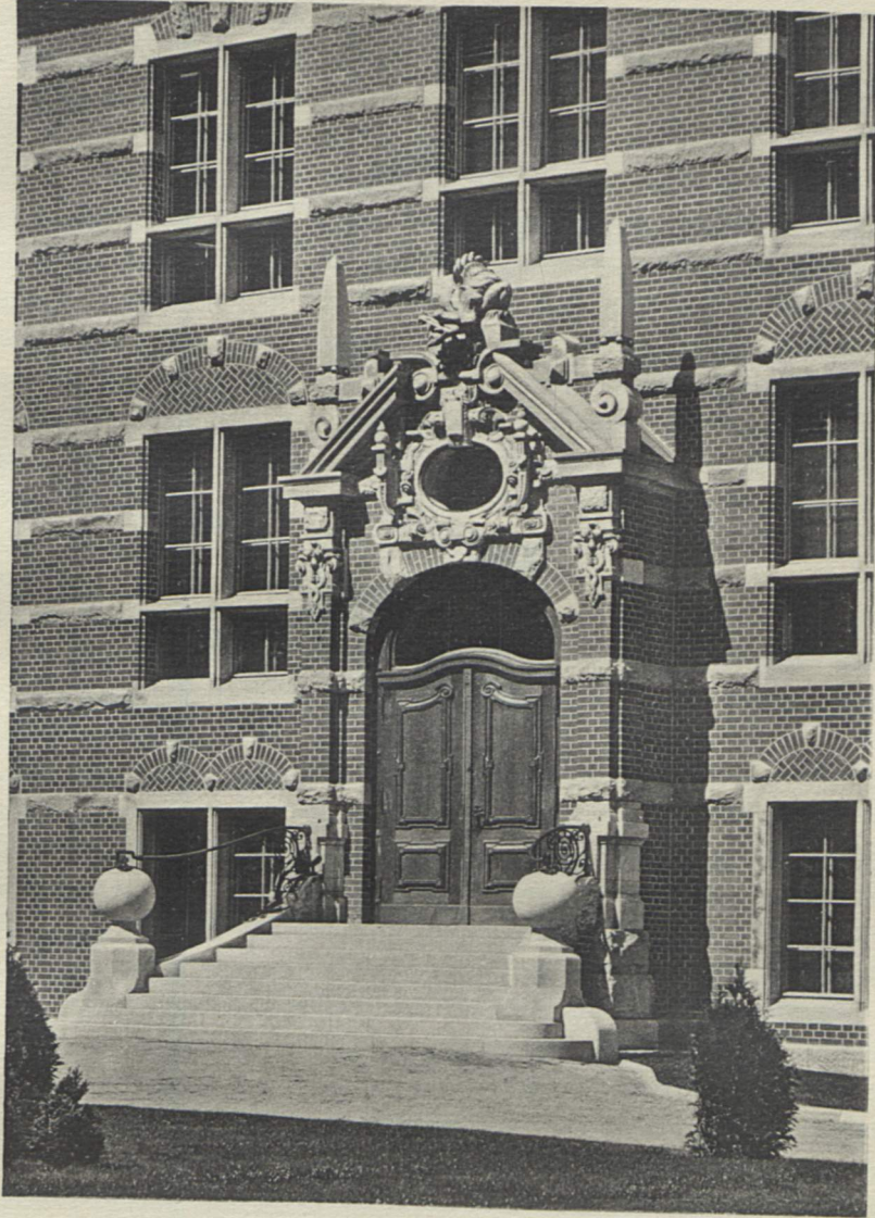
Elektrotechnisches Institut. Haupteingang.
