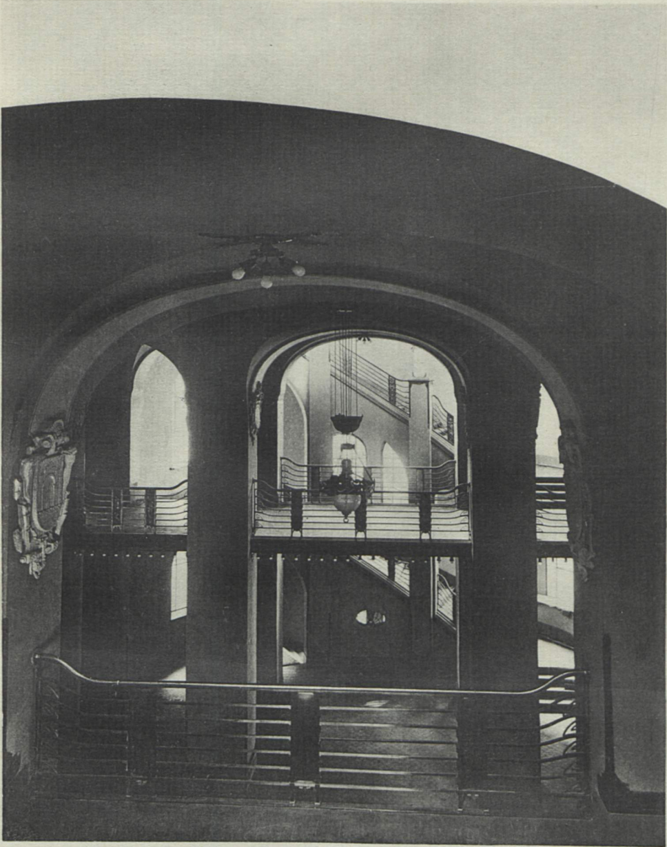
Hauptgebäude. Untere Wandelhalle.
