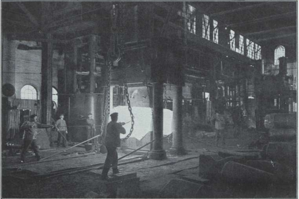
Schmiedepresse von 2000 t Druck in Gleiwitz.
