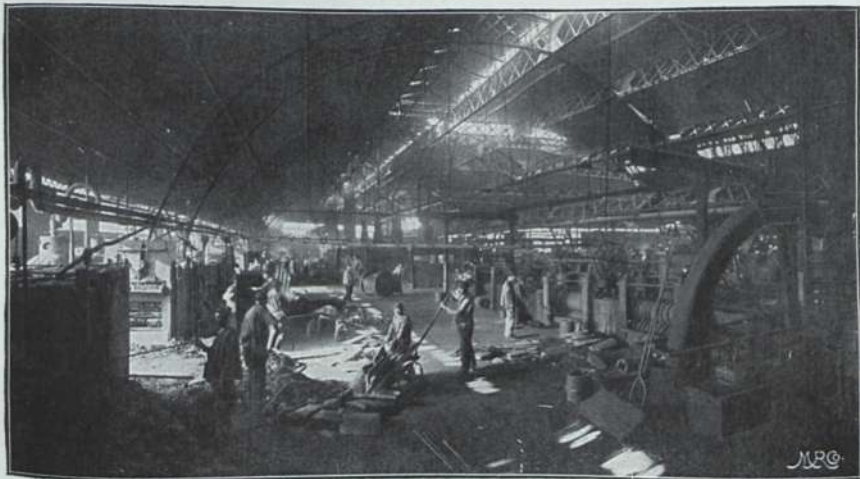
Puddelwerk mit Luppenwalze des Vorfigwerkes.
