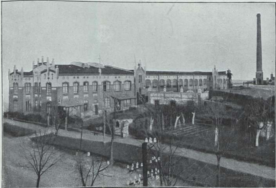
Gesamtansicht der H. Aron-Elektrizitätszählerfabrik in Schweidnitz.
