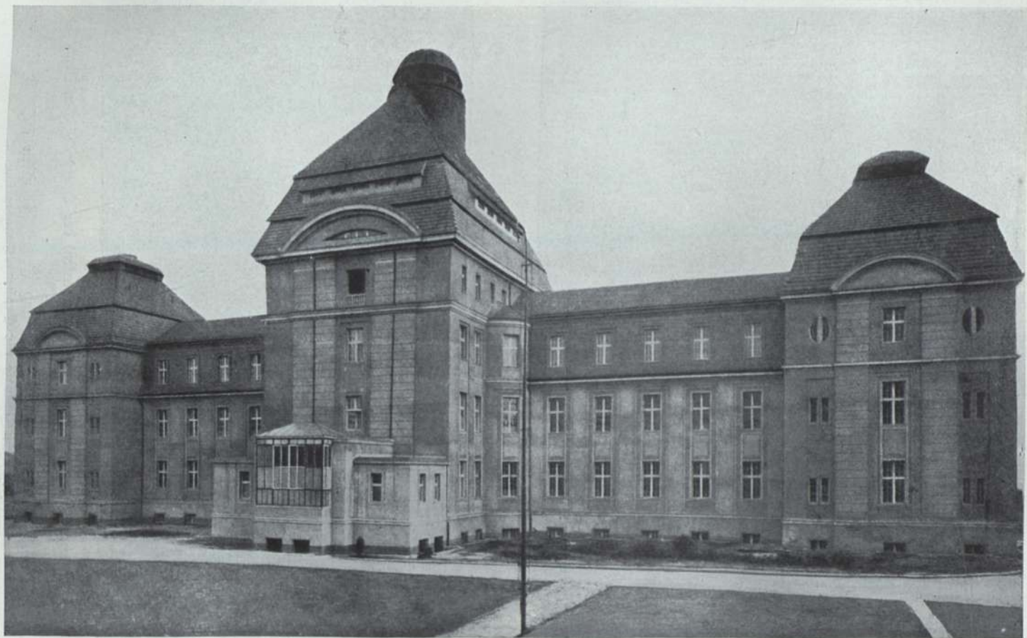
Krankengebäude (für 300 Betten) des Oberschlesischen Knappschaftsvereins zu Rudahammer.
