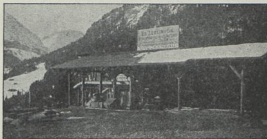
Fig. 28. Obere Bremsbergstation (Annahme auf der Poststraße).
