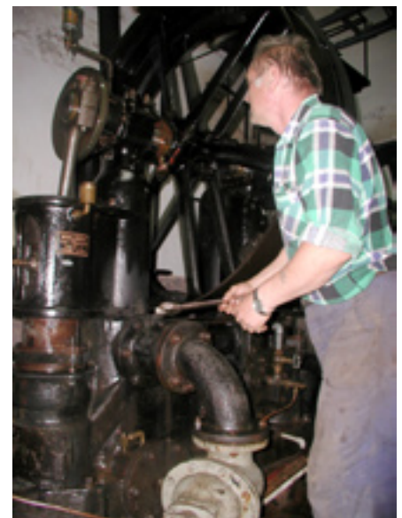
Unikalne stojące pompy typu Weise-Monski z 1909 r. pracując dotąd w „Bielawie”.
