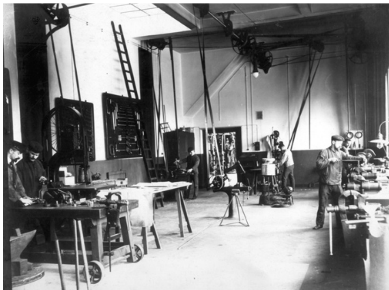
Warsztat mechaniczny, stara kotłownia, 1912.
