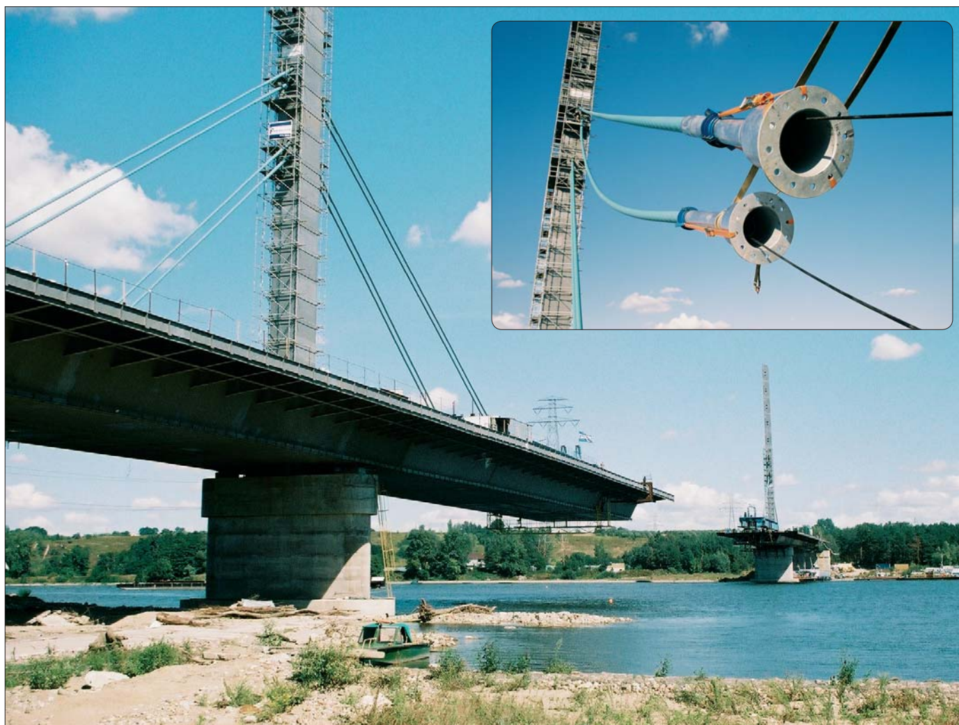
Budowa mostu w Płocku, lato 2004 r.
