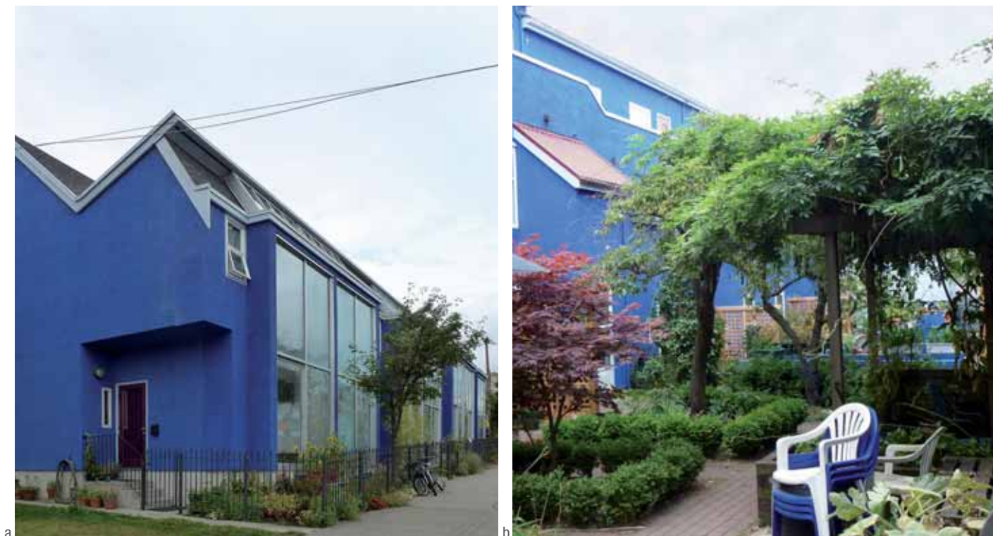
9. Kitsun Co-op – jedna z pierwszych zielonych jednostek sąsiedzkich w Vancouver z 1979 roku: a) elewacja południowa ze ścianą Trombe'a, b) dziedziniec wewnętrzny
