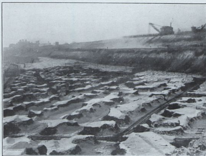
Abb. 59. Freilegung einer alten Tiefbau-Anlage zur Gewinnung der ehemaligen Stützpfiler im Tagbaubetrieb. Beleg für die hohen Abbauverluste im Tiefbau! Grube Schade bei Meuselwitz.
