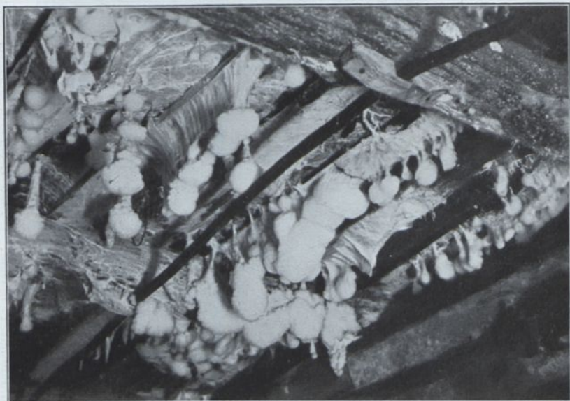
Abb. 60. Pilzbehang an der Dachzimmerung eines Braunkohlenbergwerks-Stollens ( Polyporus vaporarius ). Grube Faulbach b. Gr.-Almerode. Aufn. K. A. JURASKY.
