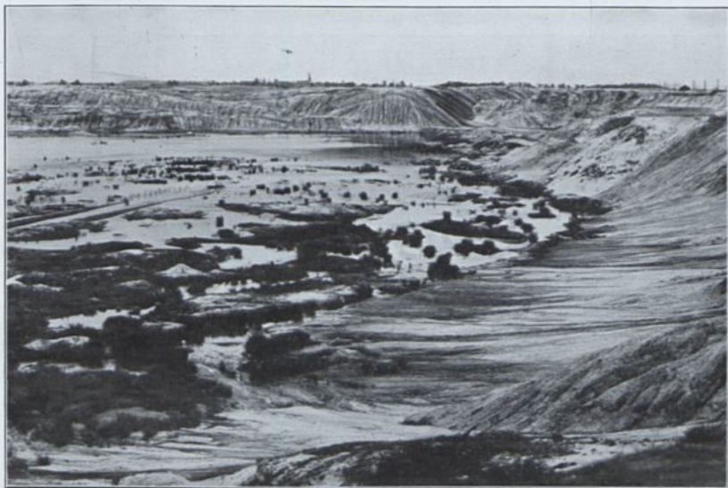
Abb. 65. Durch Grundwasseraufgang versumpftes Einsturzgebiet eines verlassenen Braunkohlen-Tiefbaus: Grube Werminghoff (Ob.-Laus.). Aufn. RUD. ZIMMERMANN, 1934.
