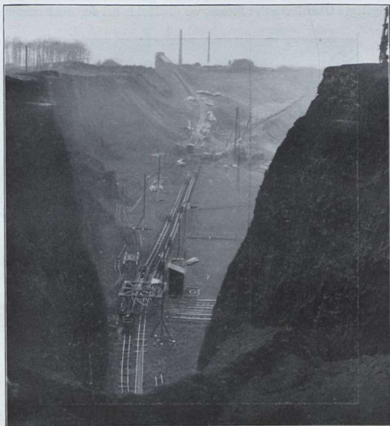
Abb. 63. Blick zwischen hochragenden Kohlenwänden in den Tagbau Türnich b. Köln. Kettenbahn mit Auffahrt zur Brikettfabrik (im Hintergrund). Aufn. Rhein. Braunkohlen-Syndikat.
