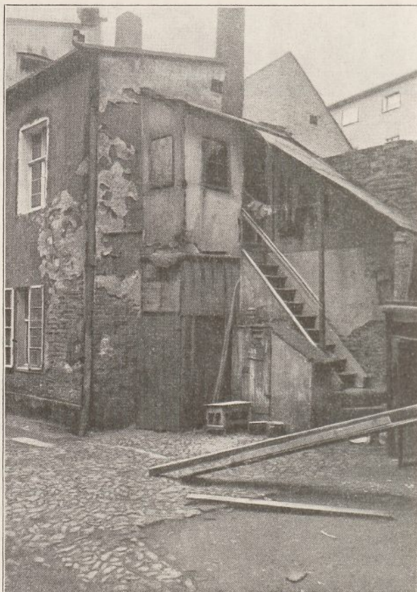
Neiße, Peterstraße 5. Total verwehrloste Behausung.
