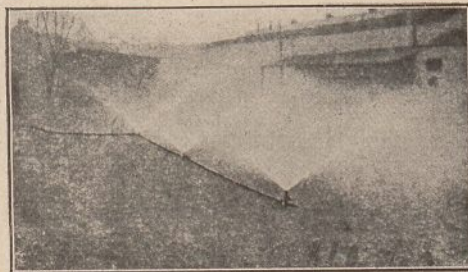
3 fahrbare Phoenix-Regnerdüsen zusammengesetzt in Tätigkeit.
