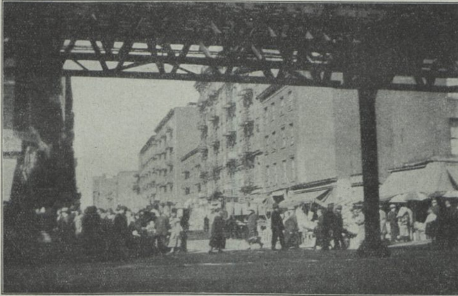
Abb. 12. Wohnviertel der Italiener. Südländischer Straßenhandel. Ältere vernachlässigte Gebäude, verunstaltet durch äußere FeuerTreppen. Im Vordergrunde das Eisengestänge der Hochbahn.
