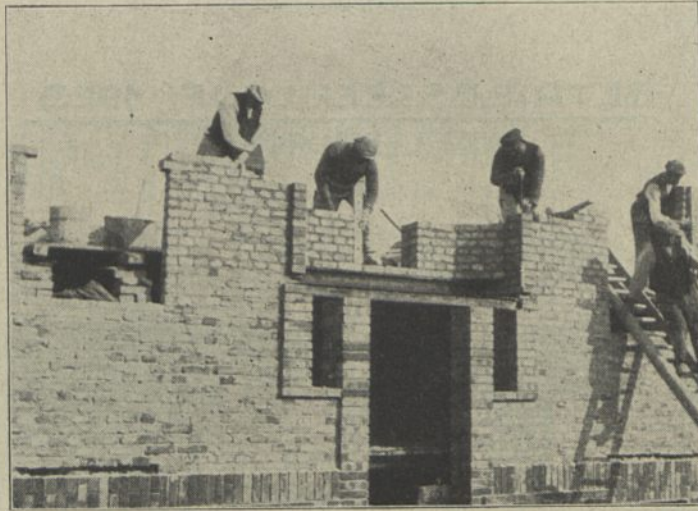
Abb. 13. Mühsames übereinanderschichten von 25000 Ziegelsteinen für eine Wohnung, Ausloten kleiner Ecken usw. Diese Vielarbeit fällt beim Plattenbau fort.
