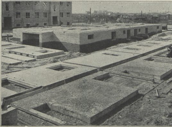
Abb. 19. Gegossene Wandplatten, fertig zum Aufrichten, mit eingegossenen Fenster- und Türrahmen.
