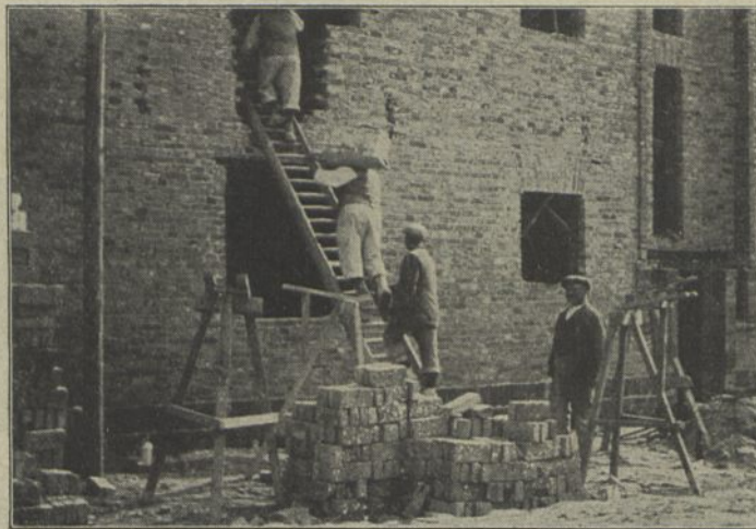
Abb. 14. Mühsames Herauffchaffen der 25000 Ziegelsteine für eine Wohnung auf das Arbeitsgerüst des Maurers.
