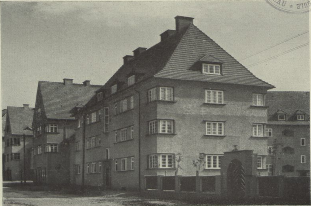
Abb. 10. Mietwohnungen Oppeln (Ecke Zimmer-Königstraße).
