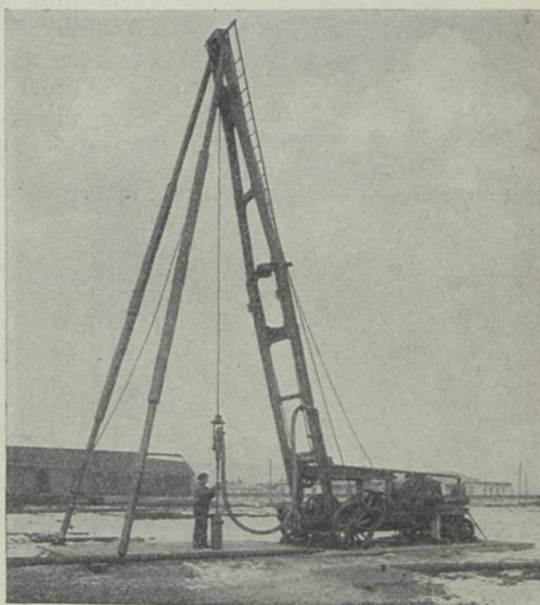
Abb. 7. Fahrbarer, motorischer Spülbohrapparat für 400 m Tiefe, beim Schlagbohren. (A.-G. Trauzlwerk, Wien.)
