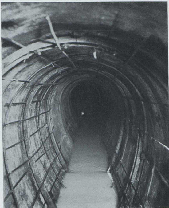
Abb. 7. Eisenbewehrung zur Wiederherstellung des Kanals 1,05/0,70 m der Kanalisation Erlangen.
