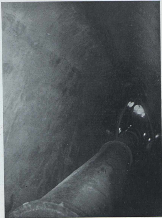
Abb. 2 Abdichtung des Parthestollens der städtischen Wasserwerke Leipzig. Nach der Abdichtung.
