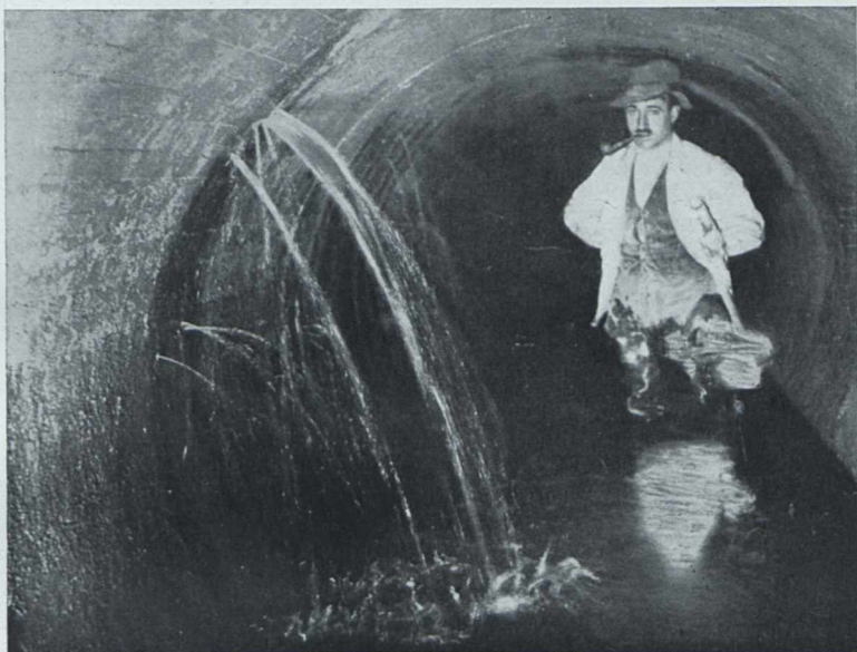
Abb. 9. Abwasserkanal Heilbronn mit schnellbindender Sika gedichtet. Vor der Abdichtung.
