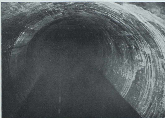
Abb. 10. Abwasserkanal Heilbronn mit schnellbindender Sika gedichtet. Nach der Abdichtung.
