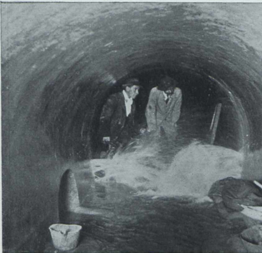
Abb. 4. Sulgenbachkanal bei Bern. Profil 1,80 m lichte Höhe, erbaut 1922, erfolgreich gedichtet mit Sika 1924.
