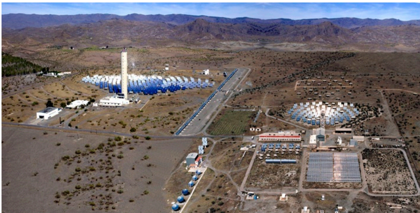
Plataforma Solar de Almería
