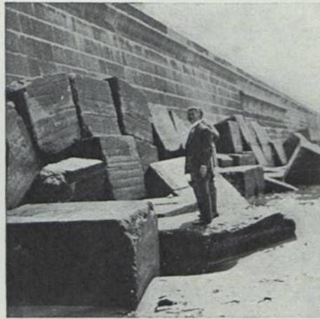
BILD 29. Wellenbrecherblöcke auf Helgoland aus Hochofenzement. Ohne Zerstörung. Im Vordergrund der Erbauer des jetzt wieder gesprengten Hafens in Helgoland, Baudirektor Eckhardt
