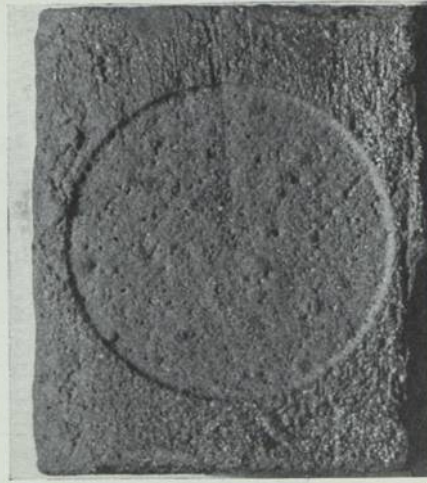
ABB. 3. Sandstrahlprobe auf Pflasterklinker
