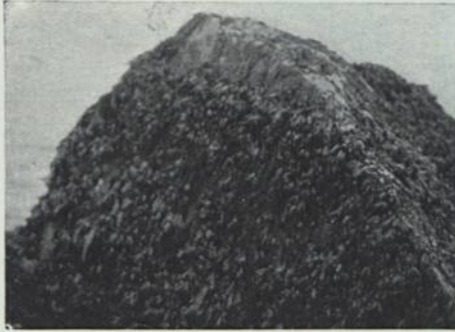
BILD 28. Wellenbrecherblock auf Helgoland, zerstört trotz Tang- und Muschelbewachung
