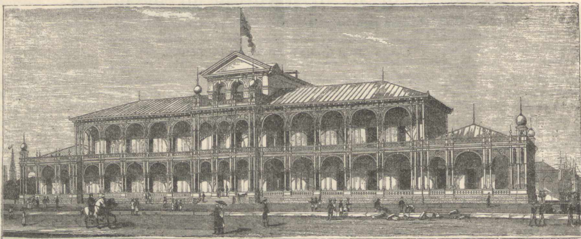
Fig. 113. Seemannshaus in Bombay (Architekt J. M. Anderson).
