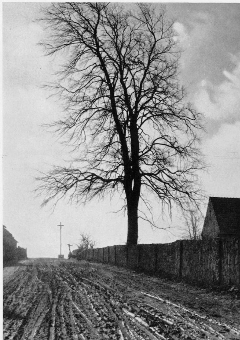
Abb. 67. Kalksteinmauer mit Pfeilervorlagen in Grasfen (Kreis Dypeln)
