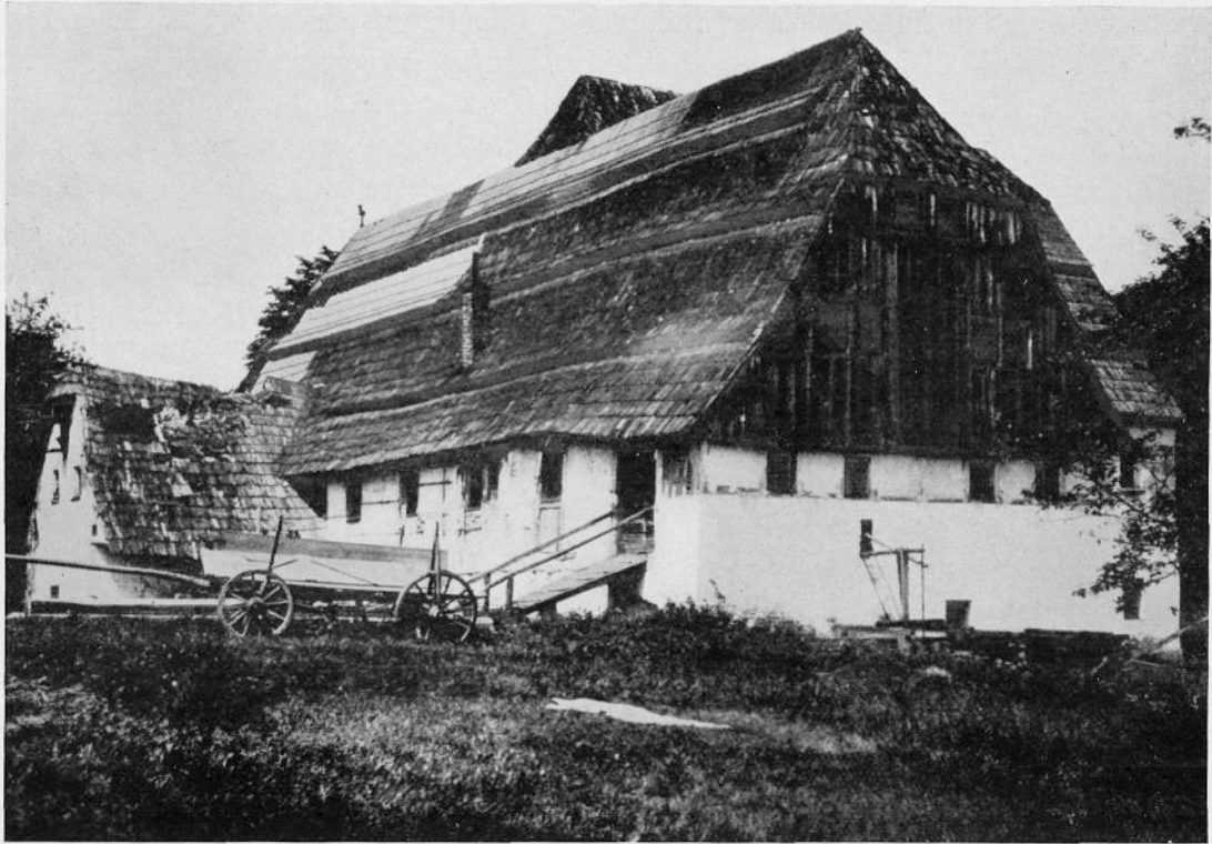
Abb. 291. Papiermühle in Arnoldsdorf (Kreis Neiße) Der Regelschopf des kleinen Seitenflügels dient als Wetterschutz für die Aufzugswinde
