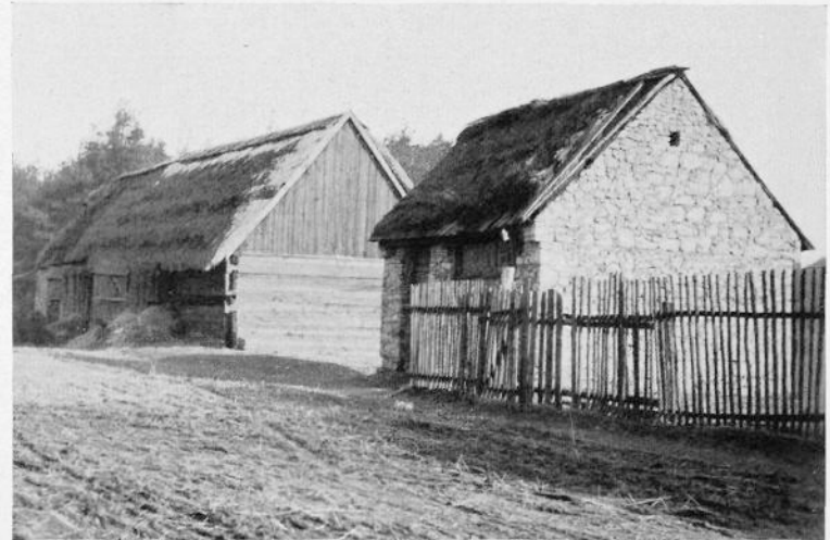
Abb. 5 u. 6. Umgebinderhäuser in Schnellewalde und Altwalde (Kreis Neisse): Wohnstube aus lehmverkleidetem Schrotholz mit vorgestellten Holzsäulen, die die Dachlast tragen; sonst Fachwerkwände mit Lehmstakenfüllung; 7. Pfeilerscheune in Harmerau (Kreis Oppeln), Pfeiler in Raseneisenstein; 8. Scheunen aus Schrotholz und Kalkstein in Grasfen (Kreis Oppeln)
