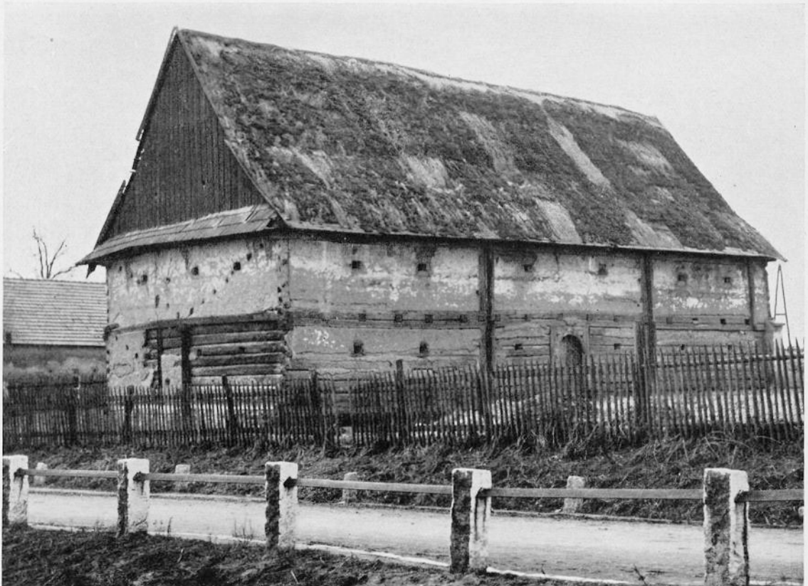
Abb. 103. Hölzerner Dominialspeicher mit Lehmverkleidung in Dirschelwitz (Kreis Neustadt)
