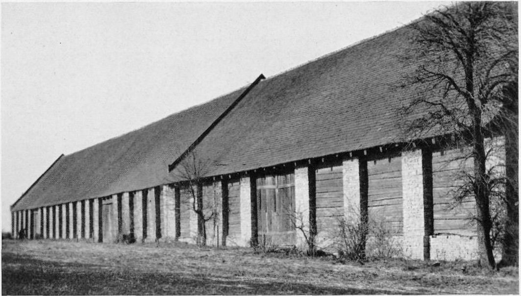
Abb. 129. Dominialscheune mit Kalksteinpfeilern in Niederkirch (Kreis Groß-Strehlitz). Mitte des 19. Jahrhunderts
