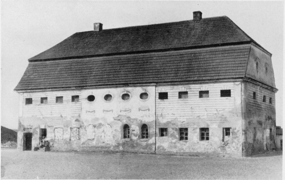
Abb. 109. Dominialspeicher auf dem Vorwerk Eichenhof (Kreis Ratibor), um 1790
