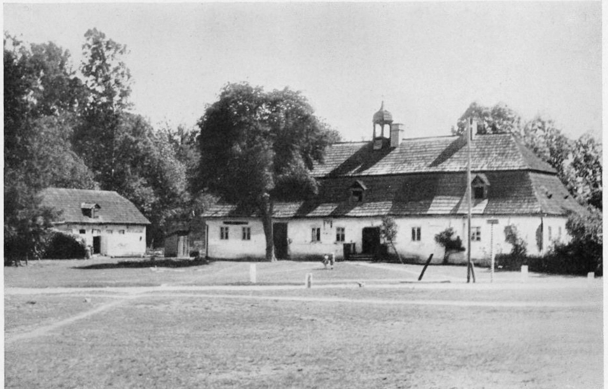
Abb. 303 u. 304. Das ehemalige Hüttenamt in Jakobswalde, ein lehmverkleideter Schrotholzbau aus dem 18. Jahrhundert
