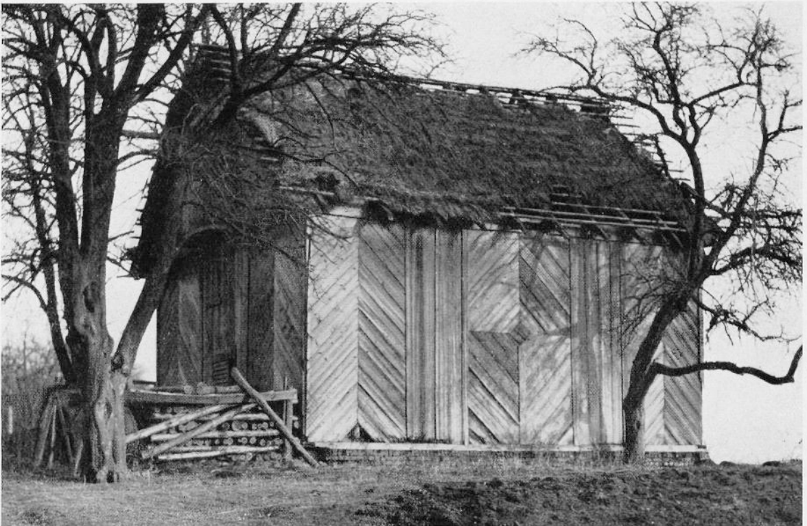
Abb. 106. Eishaus in Skalung (Kreis Kreuzburg). Abgerissen
