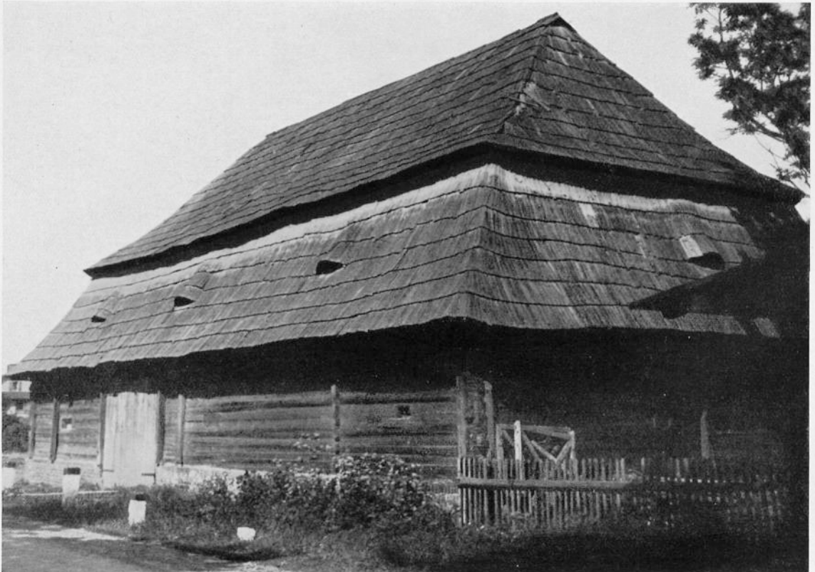
Abb. 101. Dominialscheune in Brückenort (Kreis Rosenberg)
