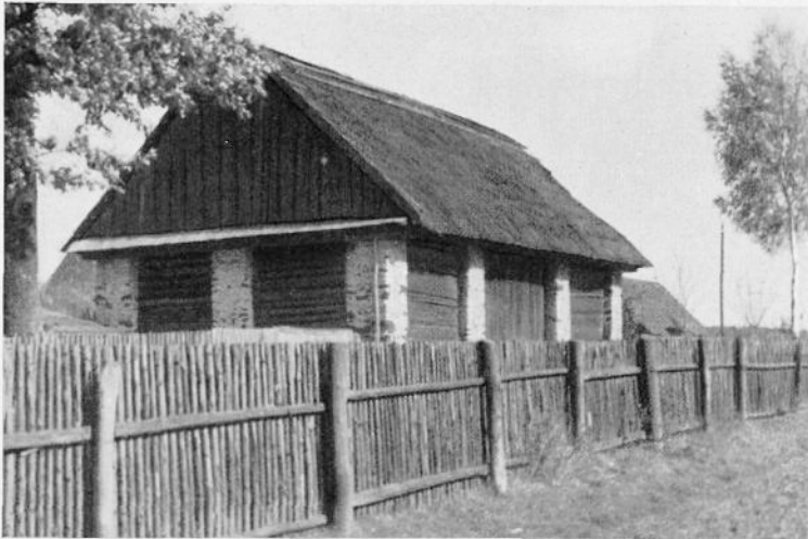
Abb. 5 u. 6. Umgebinderhäuser in Schnellewalde und Altwalde (Kreis Neisse): Wohnstube aus lehmverkleidetem Schrotholz mit vorgestellten Holzsäulen, die die Dachlast tragen; sonst Fachwerkwände mit Lehmstakenfüllung; 7. Pfeilerscheune in Harmerau (Kreis Oppeln), Pfeiler in Raseneisenstein; 8. Scheunen aus Schrotholz und Kalkstein in Grasfen (Kreis Oppeln)
