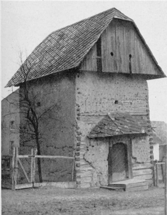
Abb. 25. Umgebinespeicher in Schnellewalde (Kreis Neustadt), Eichenholz. Das ehemals auf 4 Ecksäulen ruhende Dach ist ebenso wie die Dächer der anderen Leimes aus Gründen der Feuersicherheit unabhängig von dem lehmverkleideten Blockbau.
