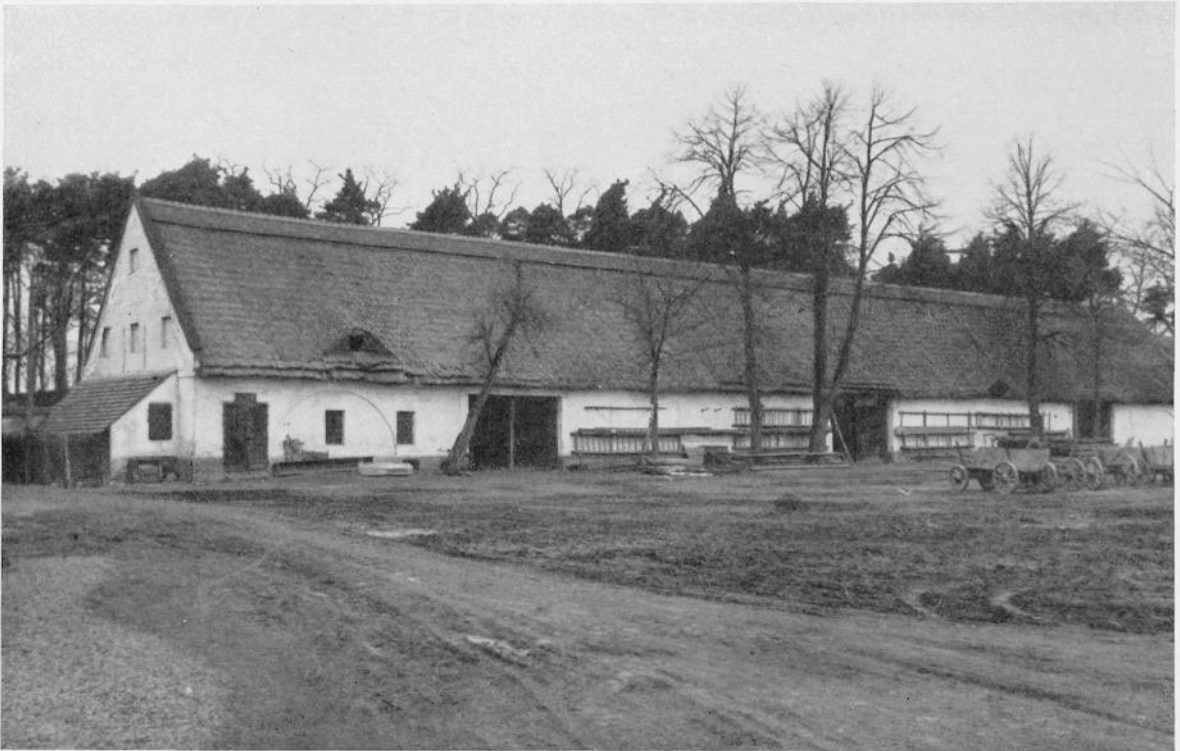
Abb. 85 u. 84. Die beiden noch unverändert gebliebenen Seiten des großen Sechsecks in Stefansfeld: Das Gutshaus mit seinen Stallflügeln und die nach links anschließende Scheune. Erstes Drittel des 19. Jahrhunderts
