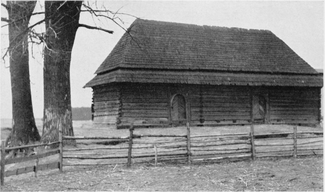
Abb. 102. Dominialspeicher in Mühlwiesen (Kreis Rosenberg). Abgerissen
