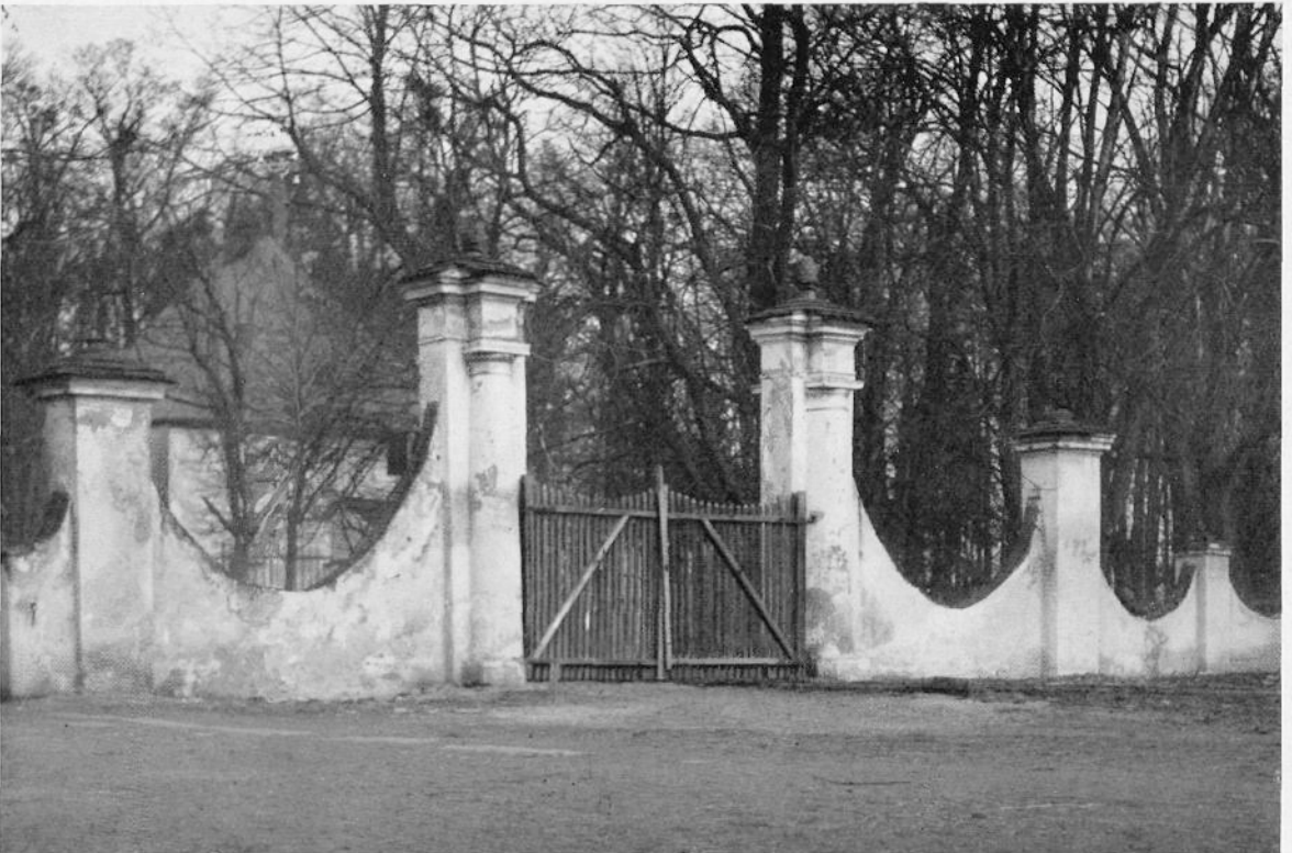
Abb. 137. Parkmauer in Muenrode (Kreis Grottkau), um 1790
