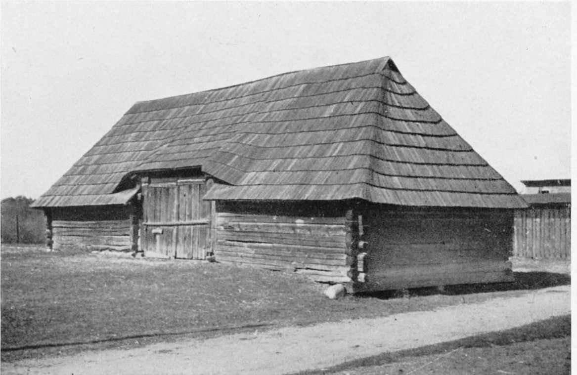
Abb. 17. Scheune in Schrotholz mit typischem Schindeldach
