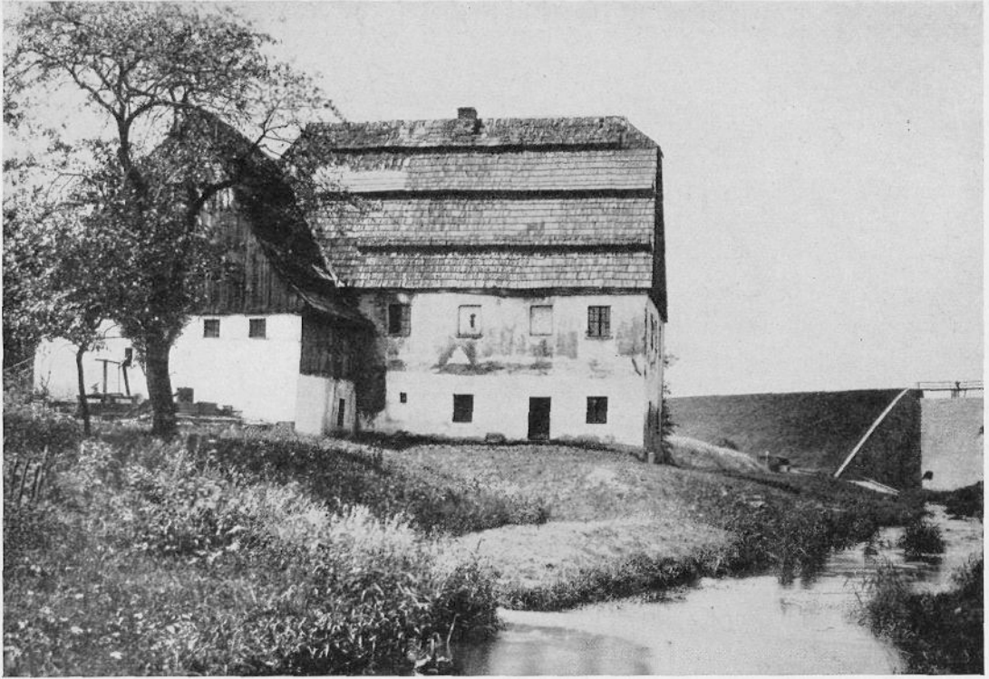
Abb. 290. Papiermühle in Arnoldsdorf (Kreis Meiße), abgerissen, nach alten Lichtbildern Die durchlaufenden Lüftungsbänder des steilen Hauptdaches zeigen drei übereinanderliegende Böden
