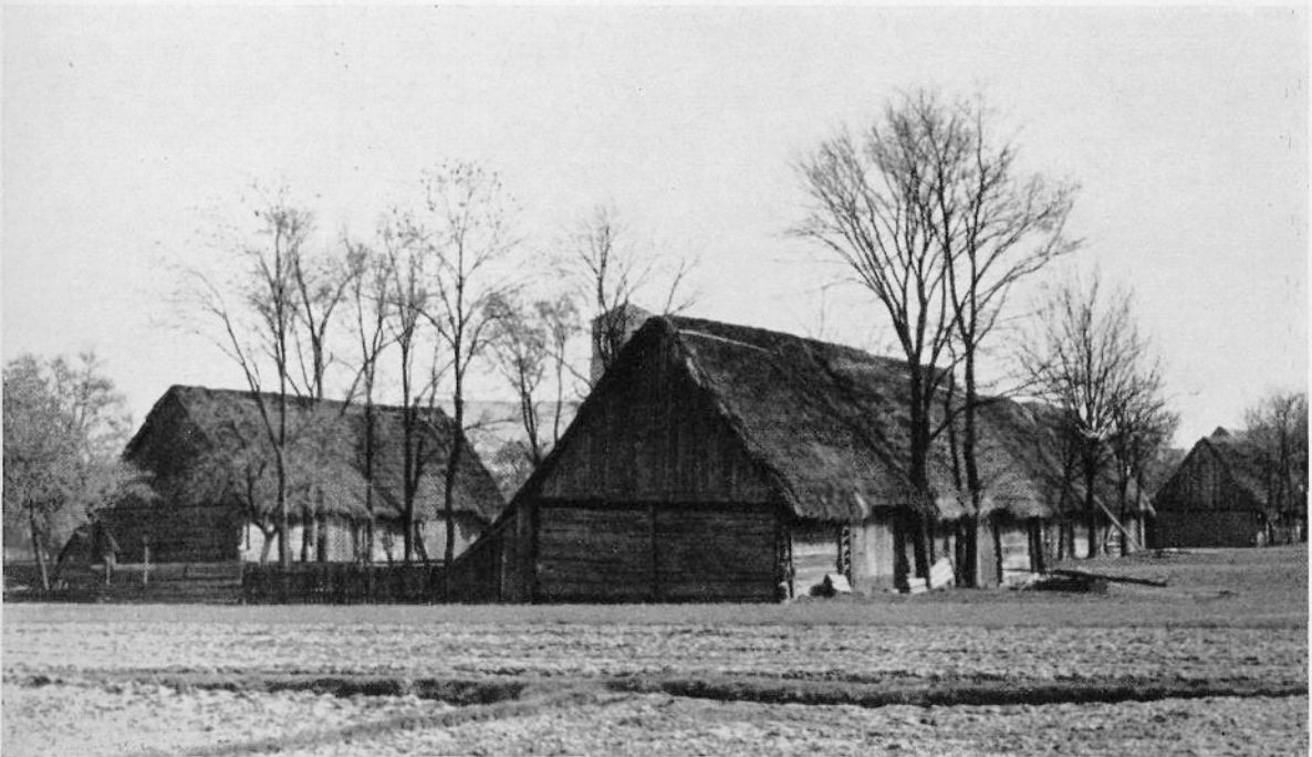
Abb. 23. Scheunen in Alt-Schalkendorf (Kreis Oppeln) sind aus Gründen der Feuerficherheit gegeneinander versetzt (vgl. auch Abb. 59)
