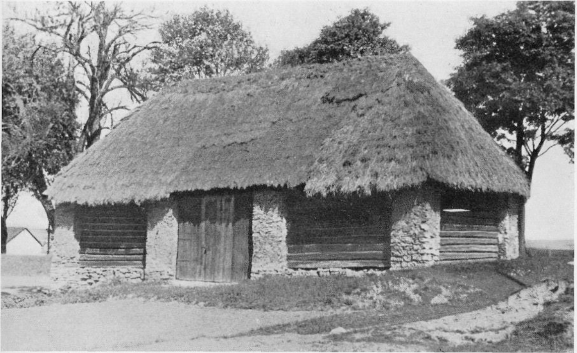
Abb. 22. Pfeilerscheune im Dramatal (Kreis Weuthen), Pfeiler in Kalkstein
