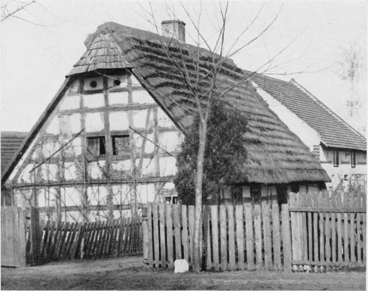
Abb. 4. Bauernhaus mit Kegelschopf aus Schindeln und Strohschaubendach in Stoberau (Kreis Brieg, Niederschlesien)
