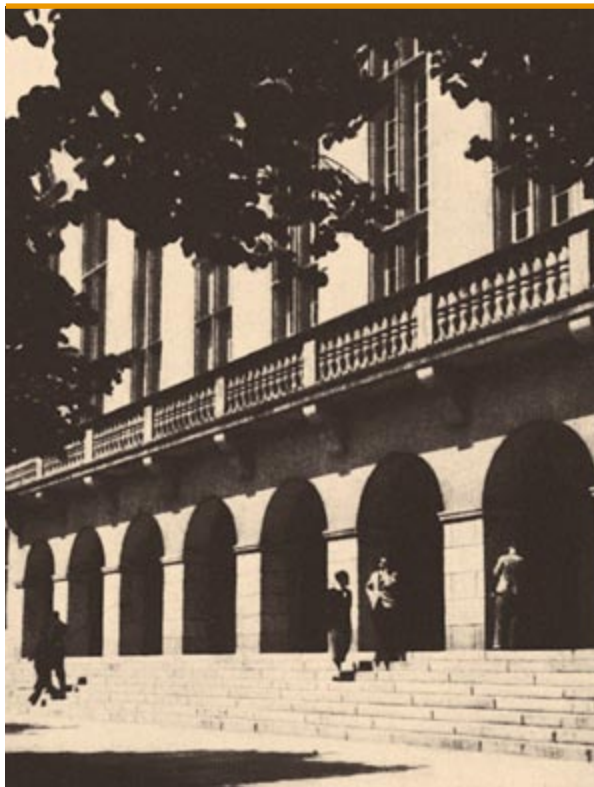
Arkady gmachu głównego wrocławskiej Wyższej Szkoły Technicznej; widok z końca lat 30. XX wieku
