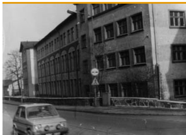
Tak wyglądała fasada budynku A wałbrzyskiej filii PWR na początku lat siedemdziesiątych XX wieku
