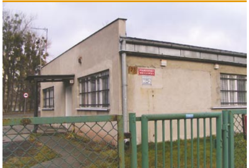
Tymczasowa siedziba AR LUZ – budynek H-2, luty 2004 r.
