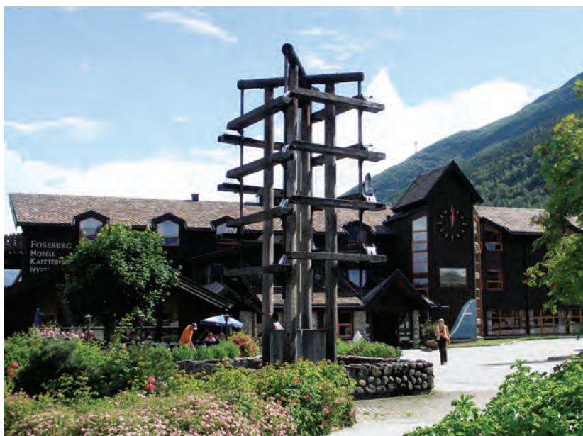
Il. 50. Dachy kryte łupkiem Fossberg Hotel w Lom (fot. E.C.)
