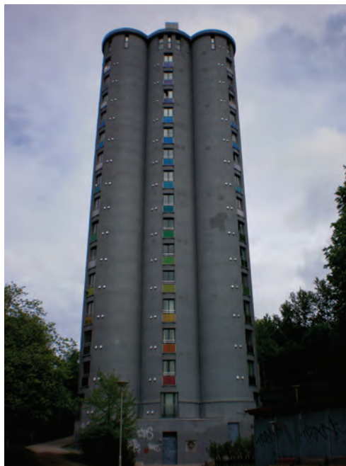
Il. 152. Adaptacja dawnego betonowego spichlerza na Dom Studencki Grünerløkke w Oslo (fot. E.C.)
