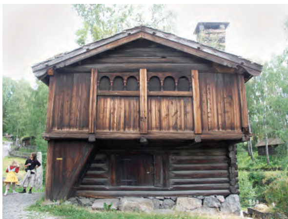
Il. 15. Drewniany spichlerz z początku XVIII w. usytuowany na kamiennej podmurówce; skansen Maihaugen k. Lillehammer (fot. E.C.)
