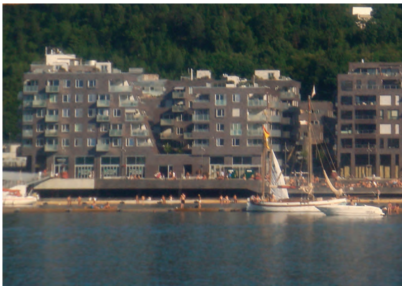
Il. 131. Kompleks mieszkaniowy Lohavn w zatoce Bjørnvika w Oslo (fot. E.C.)
