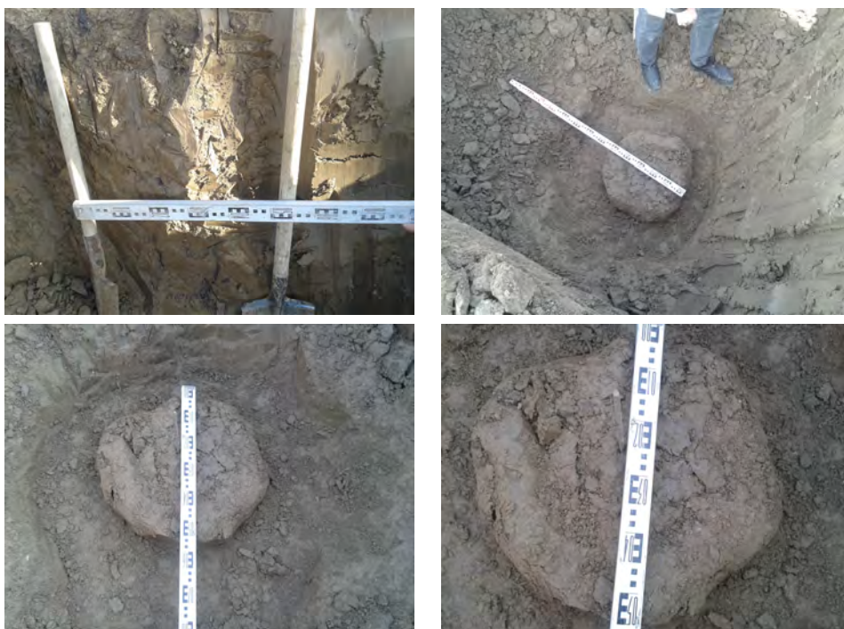
Rys. 3.7. Odkopana głowica WKG FR 2014 Stawropol, różne ujęcia
