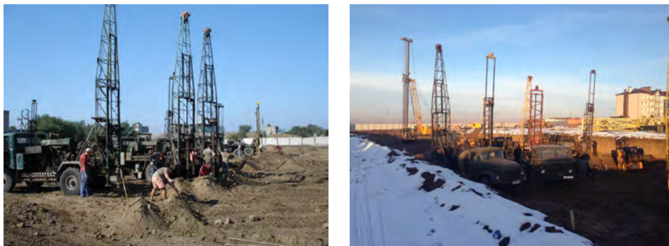
Rys. 3.6. Wiertnice na podwoziu półciężarówki w trakcie wykonywania WKG – FR obwodry Rostowski i Stawropolski w latach 2012–2014
