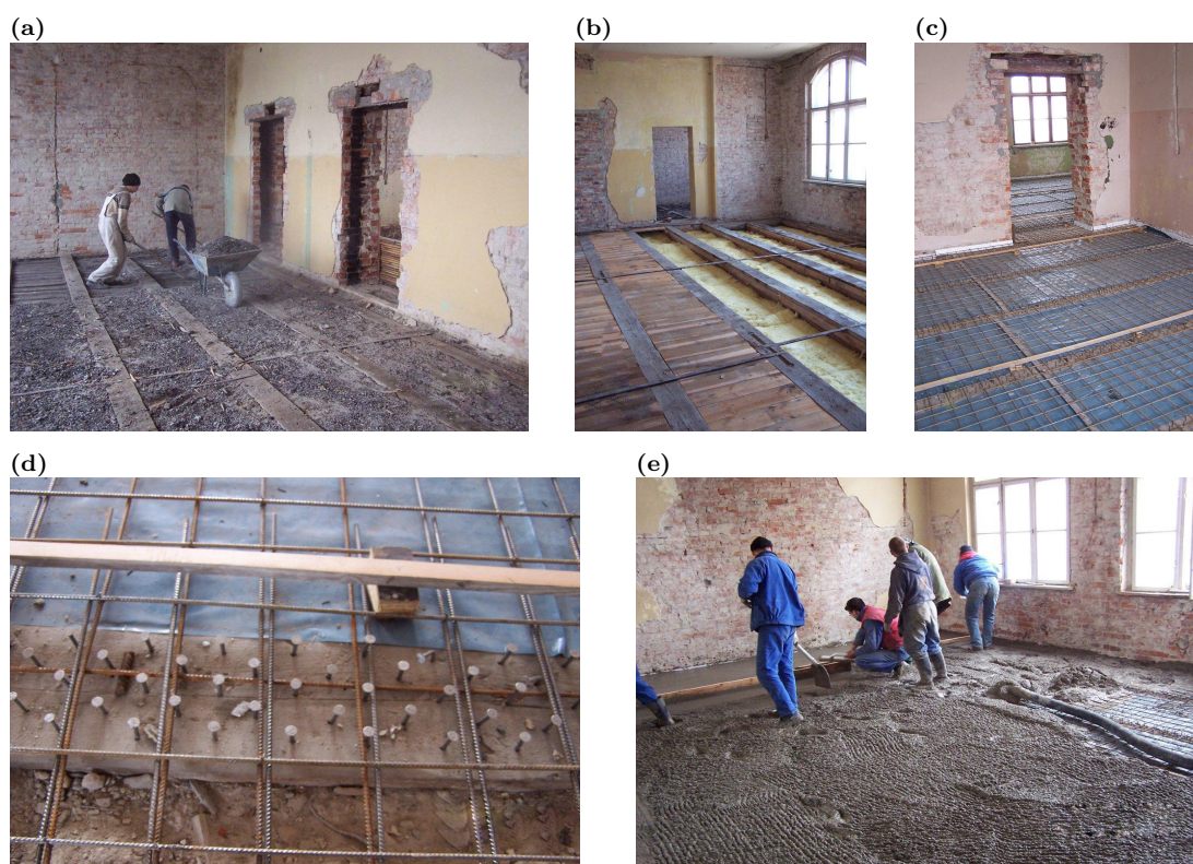
Rys. 1.1. Wykonanie stropu zespolonego drewniano-betonowego. (a) Usuwanie ciężkiej polepy z istniejącego stropu. (b) Oczyszczenie belek drewnianych, ułożenie lekkiej izolacji termicznej i dźwiękochłonnej oraz desek lub płyt OSB w poziomie górnego lica belek. (c) (d) Wprowadzenie stalowych łączników w górne lico belek, wykonanie izolacji przeciwwilgociowej oraz ułożenie zbrojenia. (e) Betonowanie płyty górnej stropu
