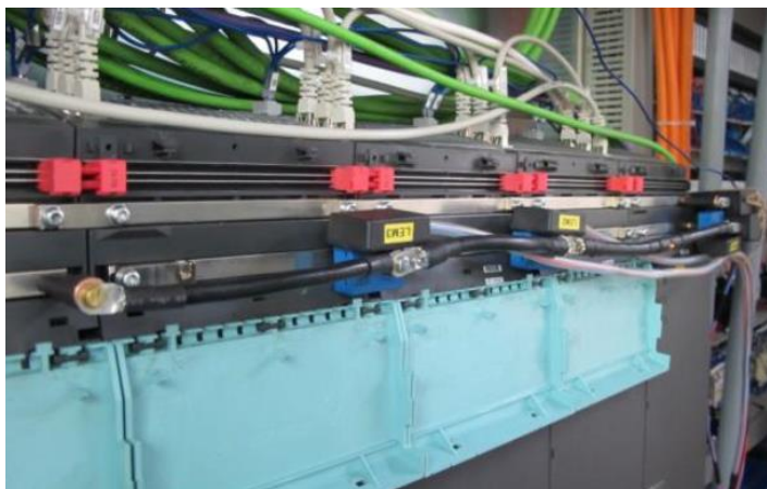
Rys. 2.17. Przetworniki prądowe podłączone w obrabiarce na linii prądu stałego [34]
