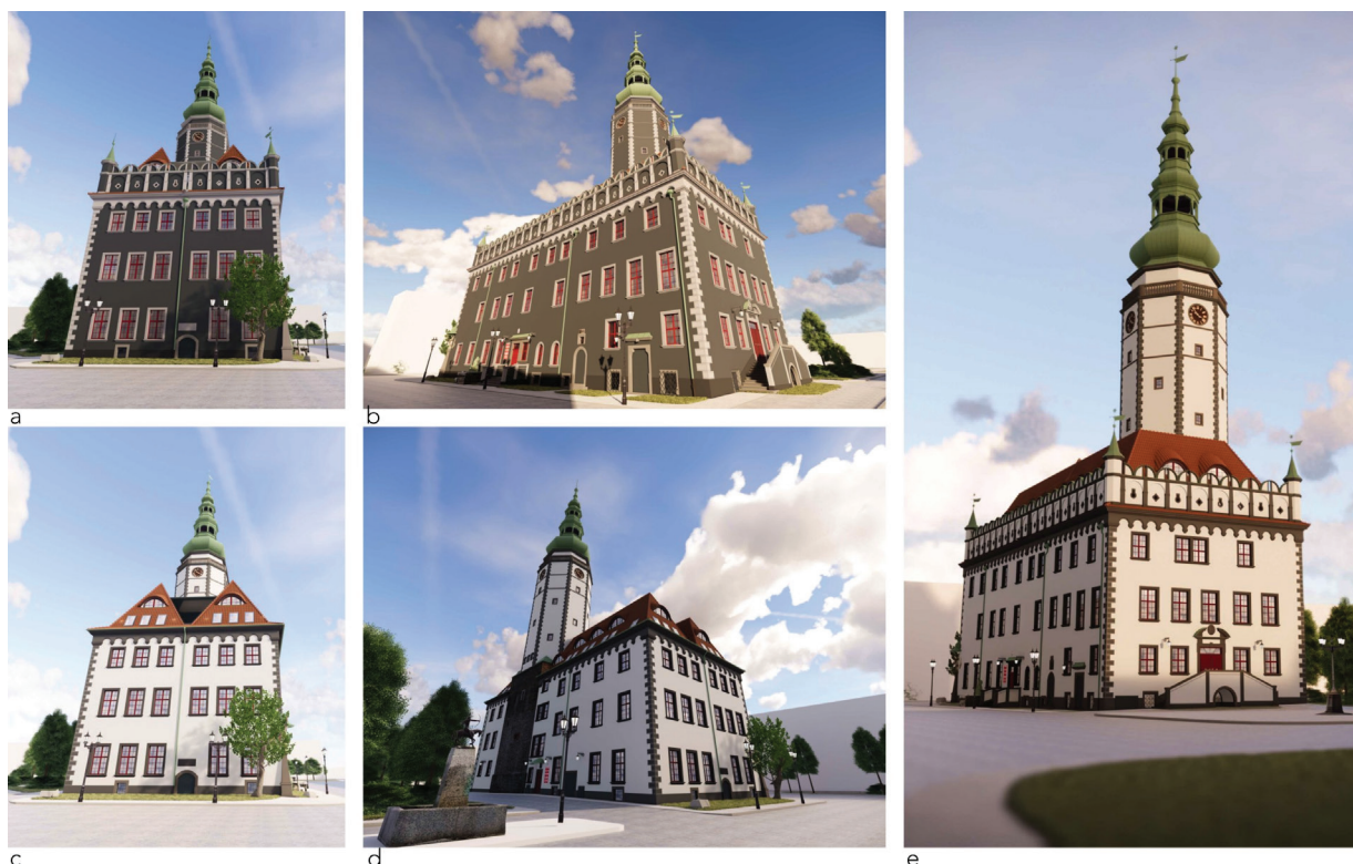
Il. 7. Strzelin, ratusz, wizualizacje przedstawiające poszukiwania optymalnego zwieńczenia i kolorystyki obiektu: a), b) ciemnoszare tło z bielonym detalem, c), d) próba odstąpienia od realizacji koronującej attyki, e) przyjęta realizacyjna kolorystyka ciemnego detalu na jasnym tle (koncepcja i wizualizacje R. Karnicki [20])
