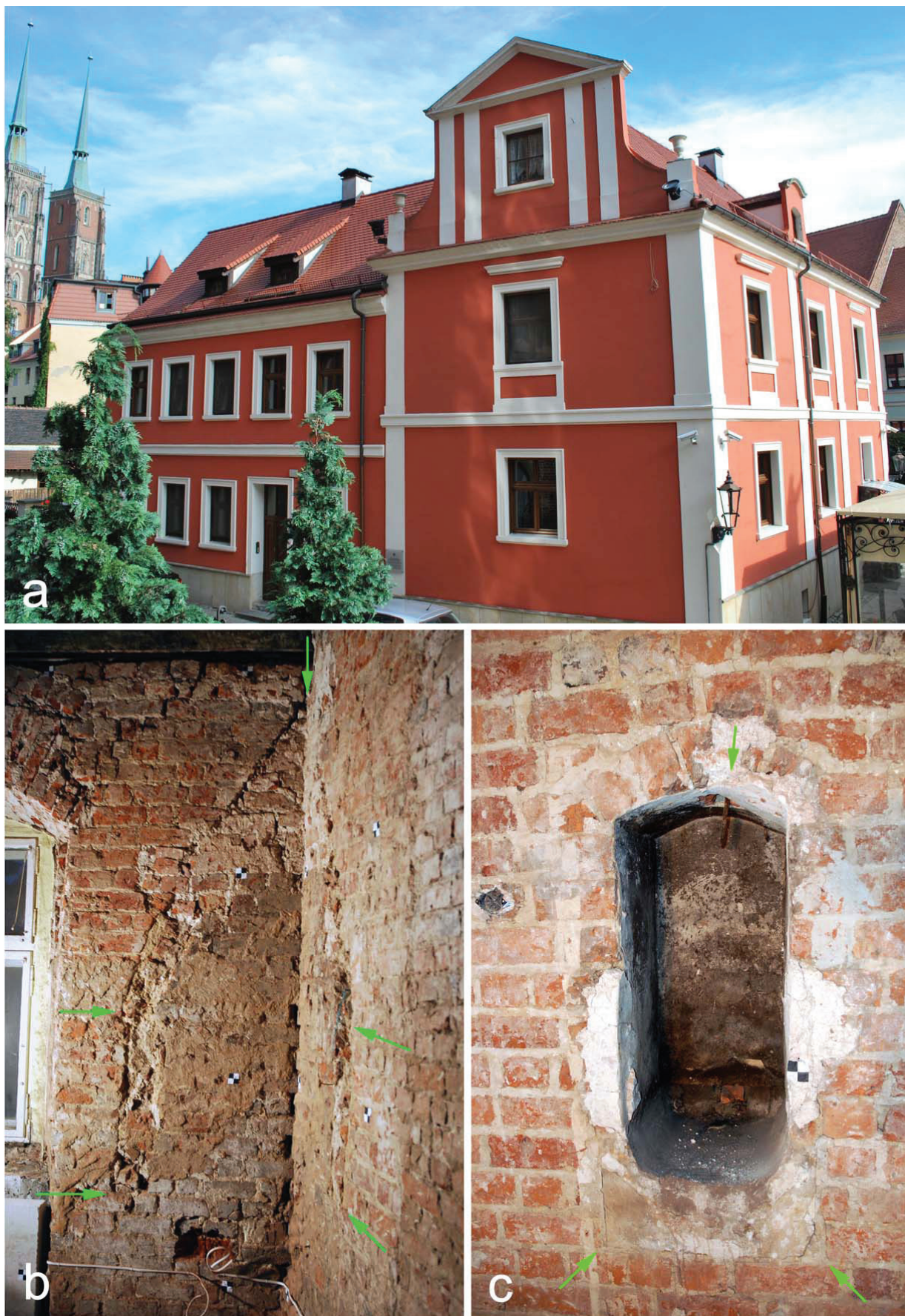
Il. 6. Wrocław, pl. Kościelny 1. Dawny dom kapituły świętokrzyskiej z relikdami średniowiecznej wieży mieszkalnej: a) widok ogólny od północnego zachodu; b), c) relikty kominka i lawabo odkryte wraz z górnym wejściem na piętrze (fot. R. Mruczek, 2006–2017)
