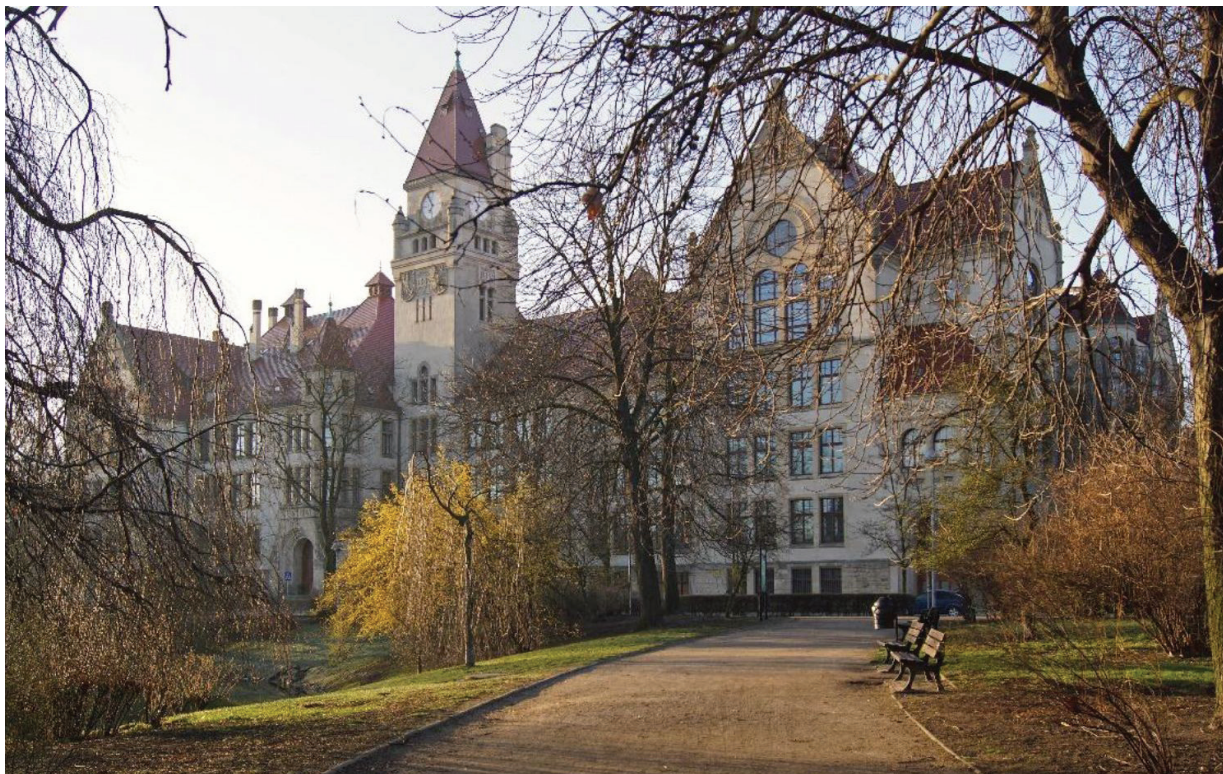
II. 4. Elewacja północna gmachu Wydziału Architektury Politechniki Wrocławskiej po pracach remontowych i konserwatorskich przeprowadzonych w latach 2011–2016 według projektów arch. J. Piskozuba i M. Jarczewskiej (fot. A. Krupa, 2019)
