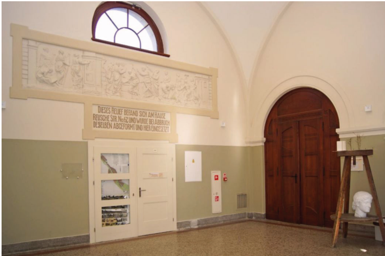
Il. 13. Gmach Wydziału Architektury Politechniki Wrocławskiej. Hol na trzecim piętrze po rewaloryzacji. Odrestaurowana sztukatorska płaskorzeźba i drewniane drzwi do auli. Na ścianach widoczne urządzenia instalacji przeciwpożarowej i elektrycznej. Okno ponad płaskorzeźbą jest jednocześnie klapę dymową. Kolorystyka ścian zgodnie z wynikami badań i analizami A. Gryglewskiej (fot. A. Krupa, 2019)
