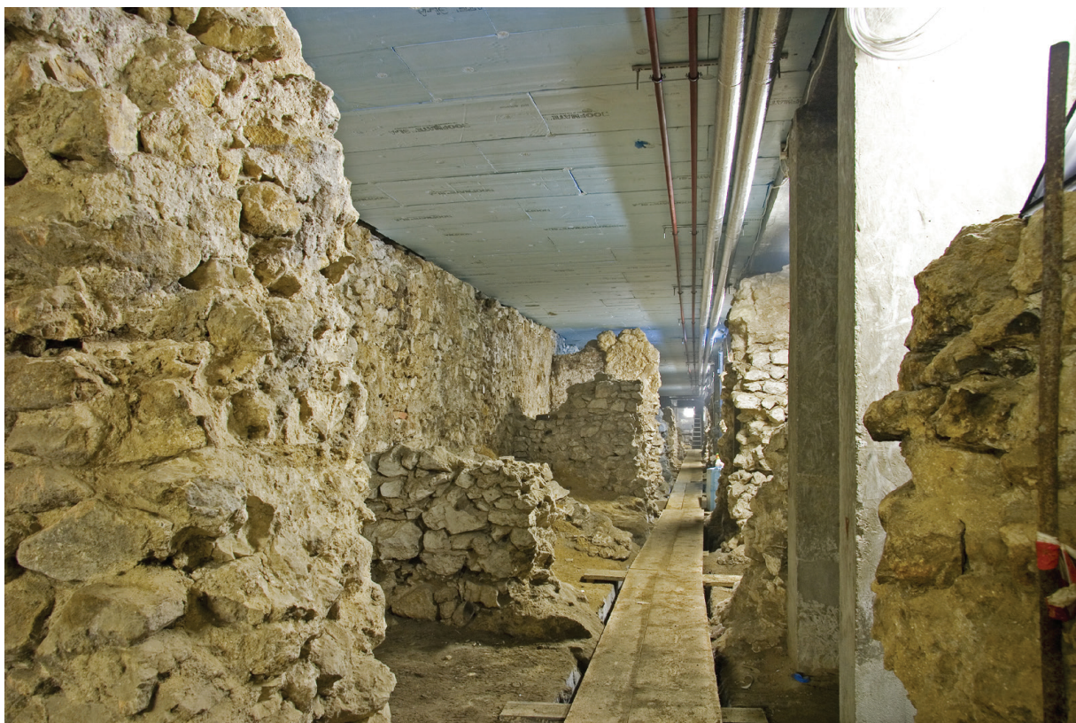
Il. 2. Muzeum Rynek Podziemny w Krakowie w trakcie realizacji, Studio Archecon: Andrzej Kadłuczka i Dominik Przygodzki, 2010 (fot. P. Kotucha, dzięki uprzejmości architektów)
