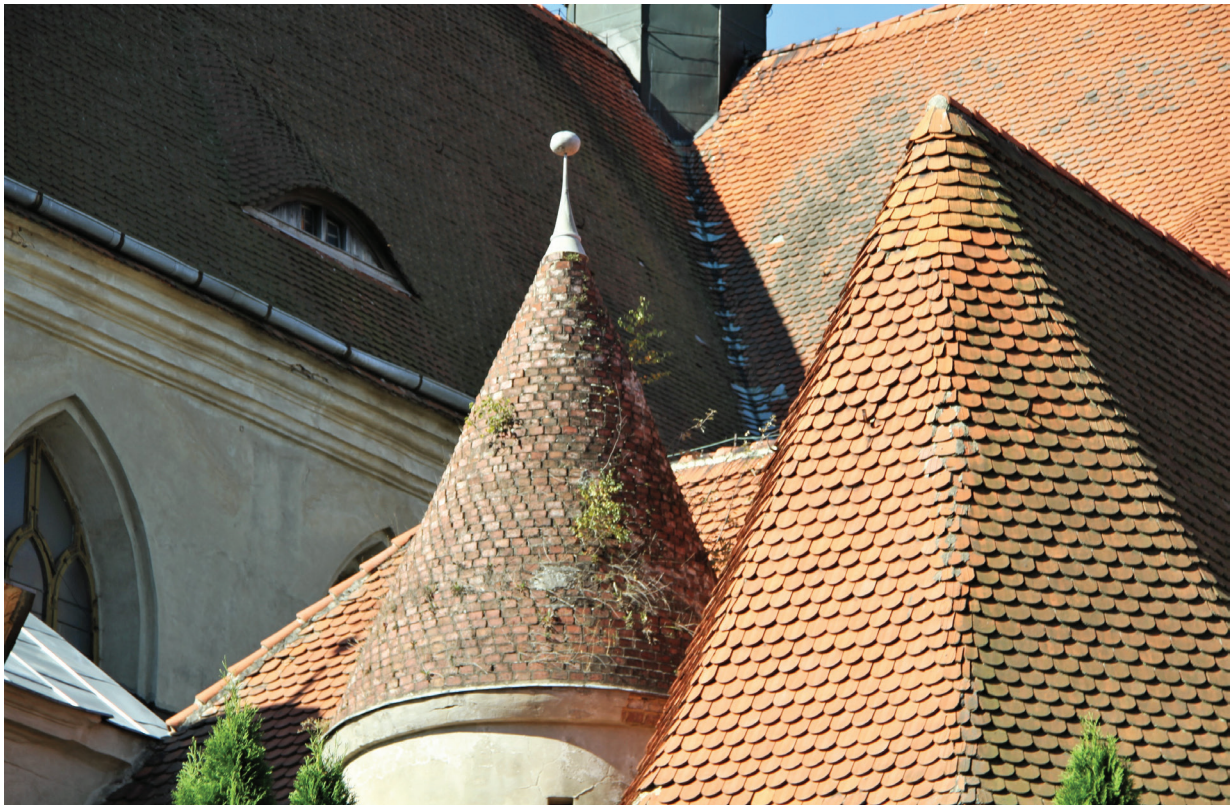
Il. 5. Henryków, dachy nad kaplicami wschodnimi (fot. M. Dąbkowska)
