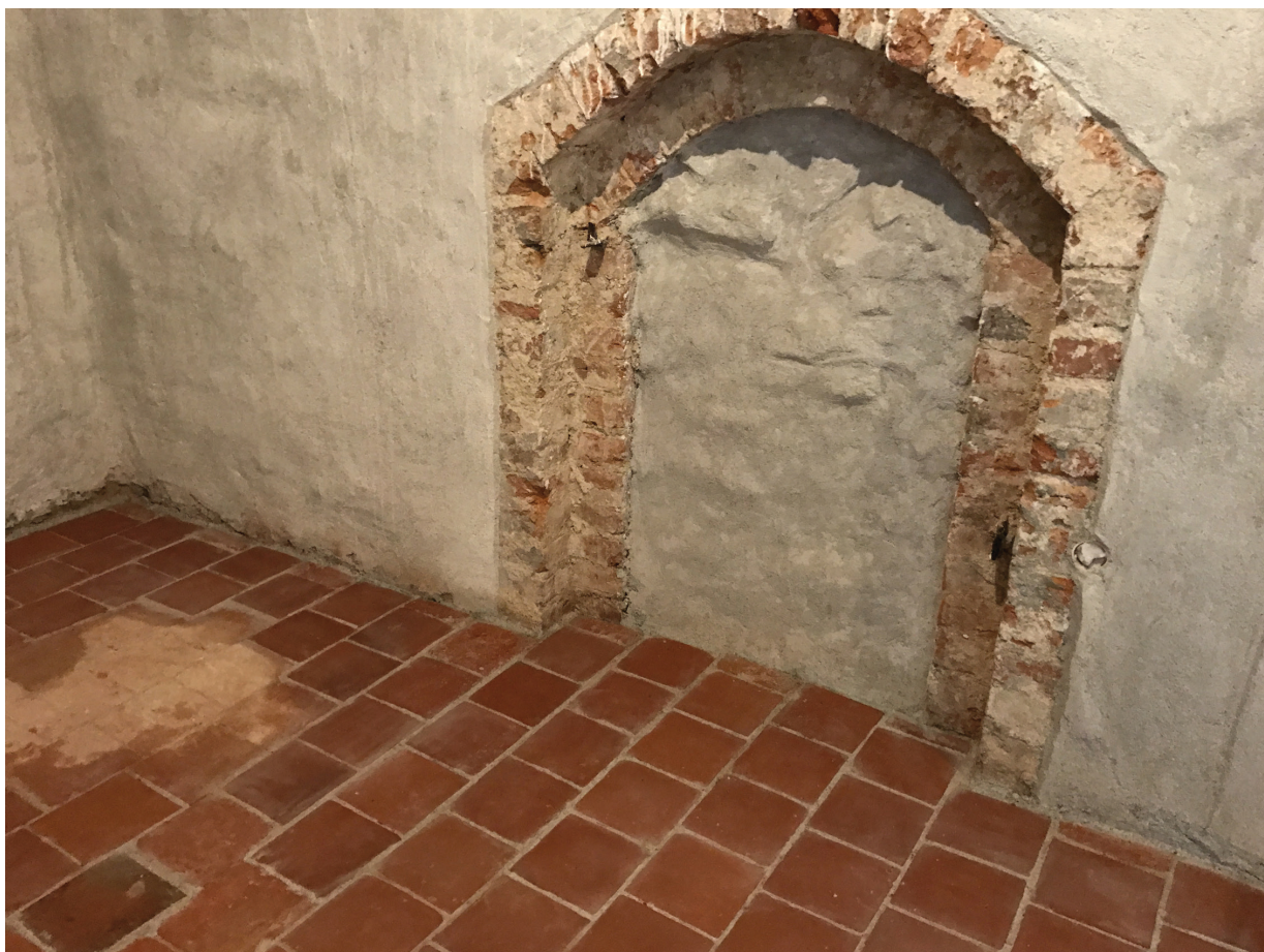
Il. 7. Chotków, kościół parafialny pw. Narodzenia NMP, zakrystia, posadzka i obramienie wejścia, stan po konserwacji (fot. M. Kozarzewski)
