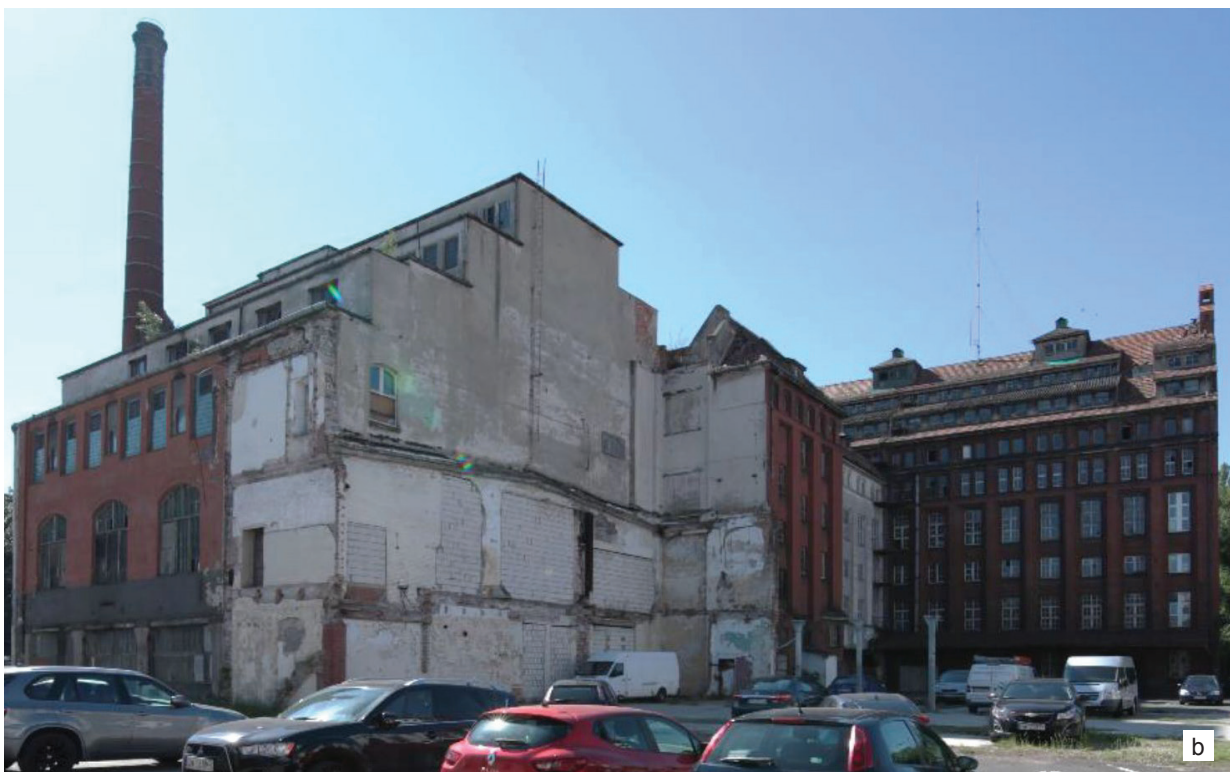
Il. 7. Budynki piekarni „Mamut” przy ul. Sienkiewicza 18–22 we Wrocławiu: a) elewacja wschodnia dawnego budynku produkcyjnego, w tle widoczna ściana szczytowa magazynu mąki, b) widok od strony północno-zachodniej na budynek produkcyjny z kominem oraz łącznik i północną elewację magazynu mąki (fot. P. Kirschke, M. Lamber, 2016)
