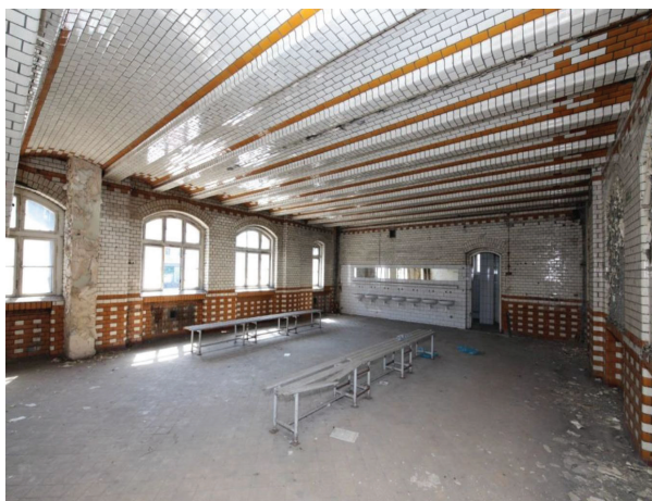
Il. 15. Szatnie personelu na 1. piętrze budynku produkcyjnego piekarni. Na ścianach i na stropach odcinkowych zachowane dwubarwne, ceramiczne lico. Zachowana posadzka ceramiczna oraz oryginalne ławki i okna drewniane (fot. M. Lamber, 2017)
