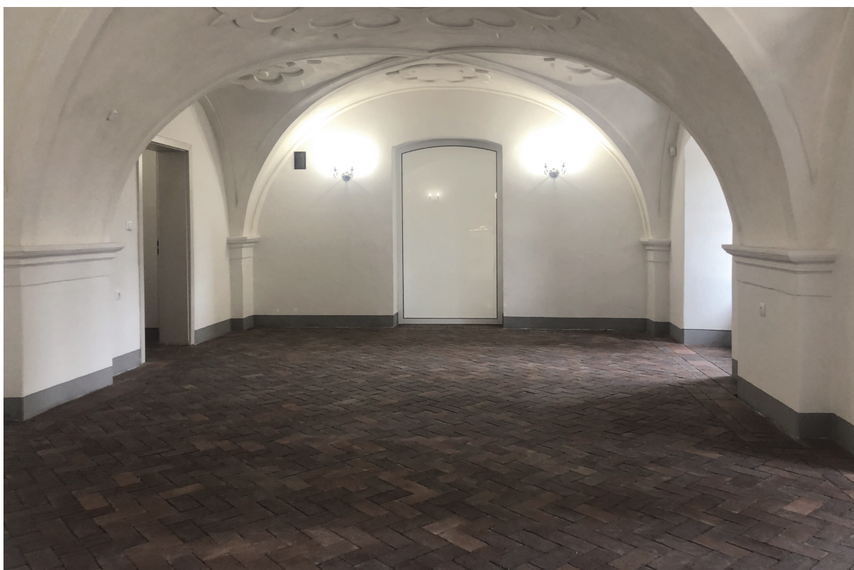
Il. 10. Szprotawa, dawny klasztor magdalenek, parter, sala pasma środkowego, widok wnętrza z posadzką z cegły w układzie w tzw. jodełkę, stan po pracach (fot. A. Legendziewicz)
