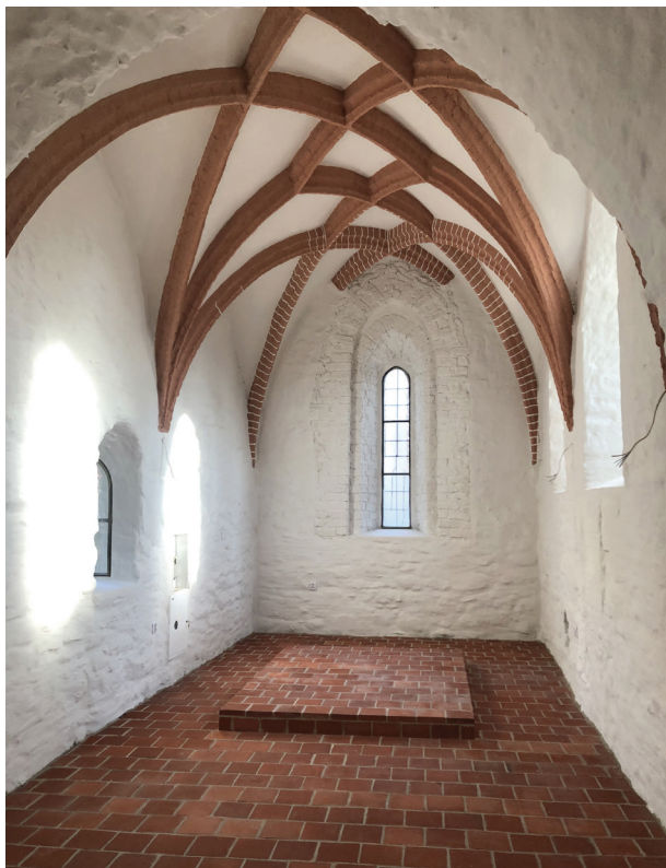
Il. 8. Żary, kościół filialny św. Piotra i św. Pawła, wnętrze prezbiterium i nawy, stan po pracach (fot. A. Legendziewicz)
