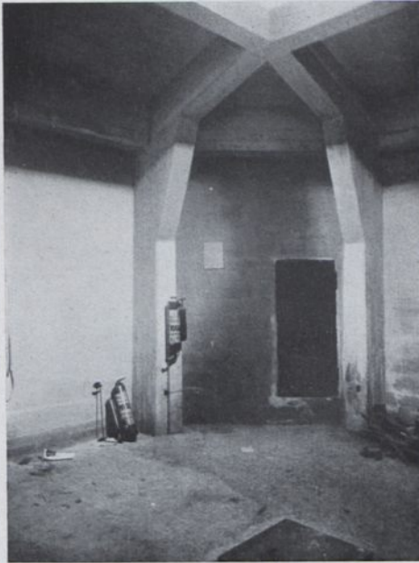
27. Grüssau. Turmhelm Kammer in Eisenbetonkonstruktion
