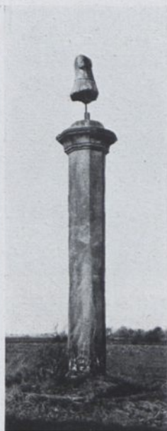
17. Trachenberg Staupsäule Vor der Instandsetzung
