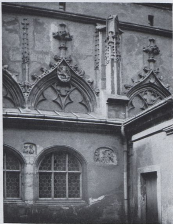
3. Glatz. Nordvorhalle vor der Instandsetzung
