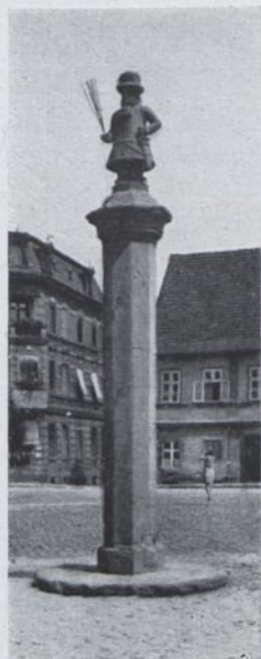
18. Trachenberg Staupsäule Nach der Instandsetzung
