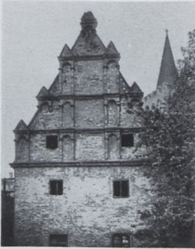
11. Münsterberg. Burgkapelle Vor der Instandsetzung
