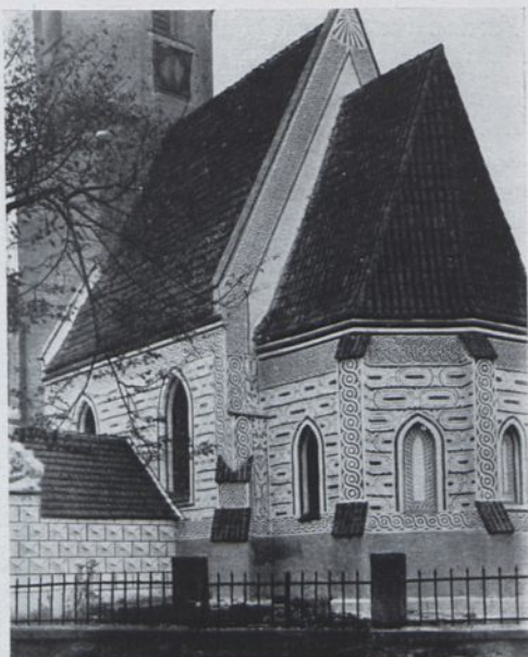
6. Groß-Gohlau. Kath. Kirche Nach der Instandsetzung
