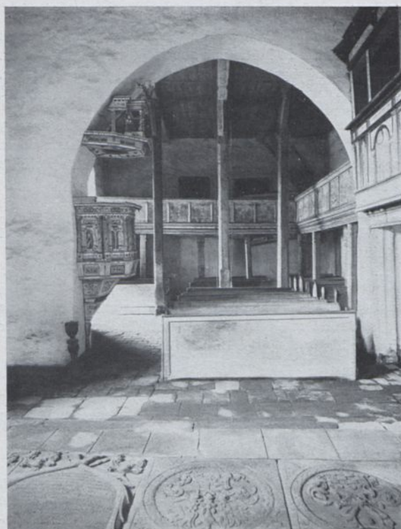
34. Welkersdorf Kath. Kirche Vor der Instandsetzung
