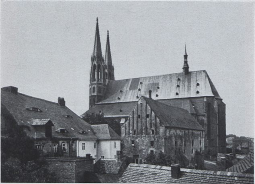
22. Görlitz. Waidhaus. Vor der Instandsetzung
