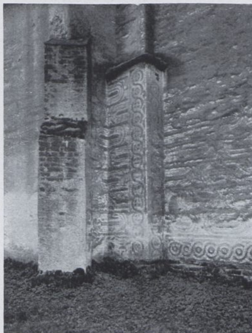
5. Groß-Gohlau. Kath. Kirche Vor der Instandsetzung
