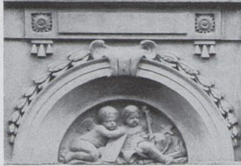
Abb. 21. Schulhaus Schulstraße 12, Glogau. Lünette des Obergeschosses
