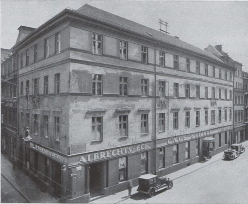
Abb. 6. Albrechtstraße 12, Breslau. Nach der Aufstockung
