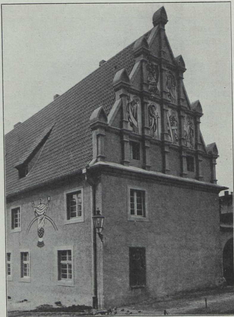
Abb. 3. Ehemalige St. Georgsschule in Münsterberg.
