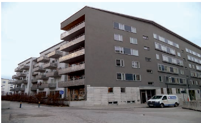
Il. 61. Sjöfarten, widok budynku z zewnątrz (fot. K. Urbanowicz)
