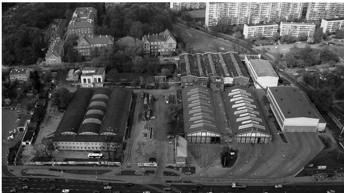
Il. 98. Widok na zajezdnię tramwajową Popowice i budynki do niej przylegające oraz fragment osiedla Popowice ( http://dolny-slask.org.pl/852453,foto.html?idEntity=508925 [dostęp: 20.03.15])
