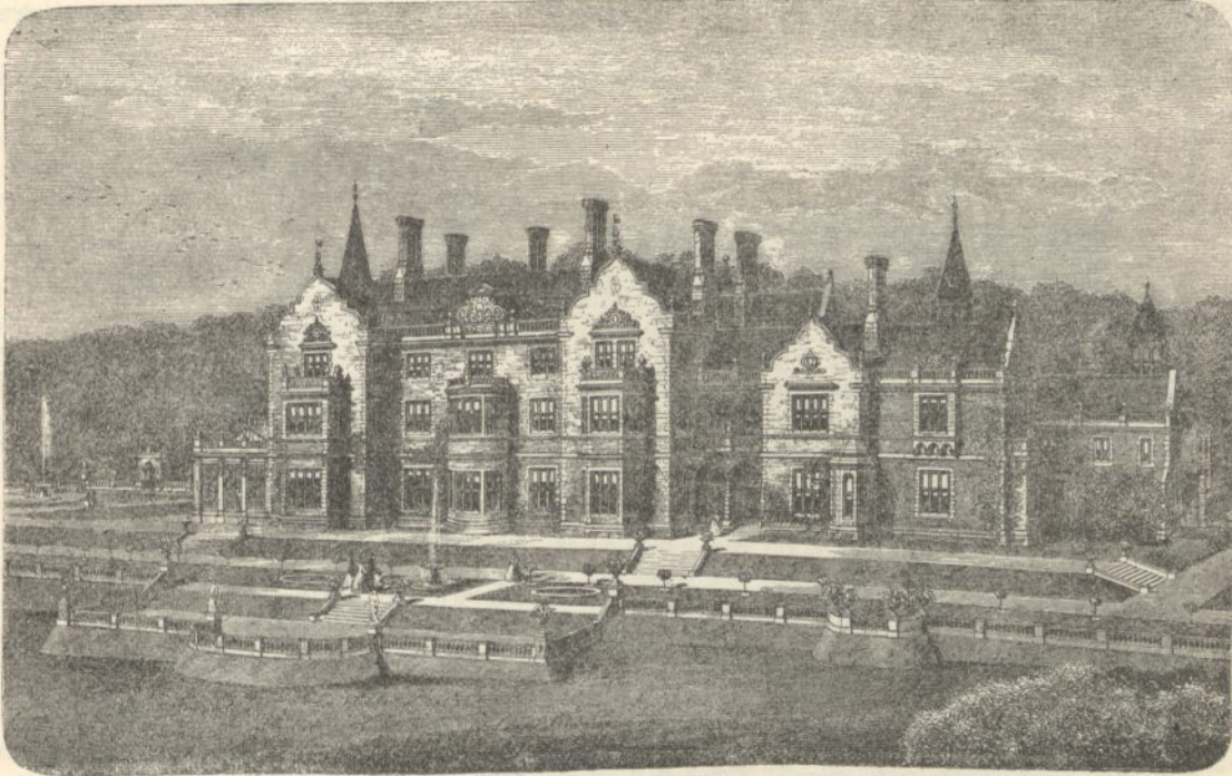
Fig. 45. Schloss des Marquis Camden (Architekt D. Brandon).
