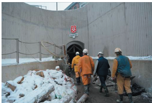
Ryc. 11. Rekonstrukcja wlotu do Głównej Sztolni Dziedzicznej w Zabrze, 2016 r. (fot. W. Preidl)
