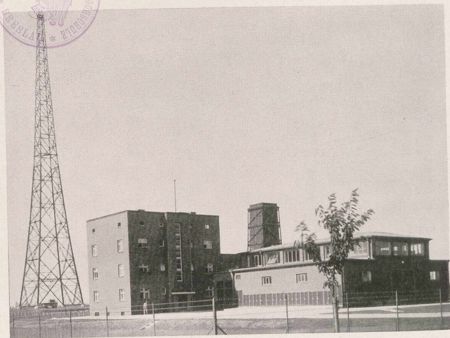
Großsenderanlage in Rothfärben
