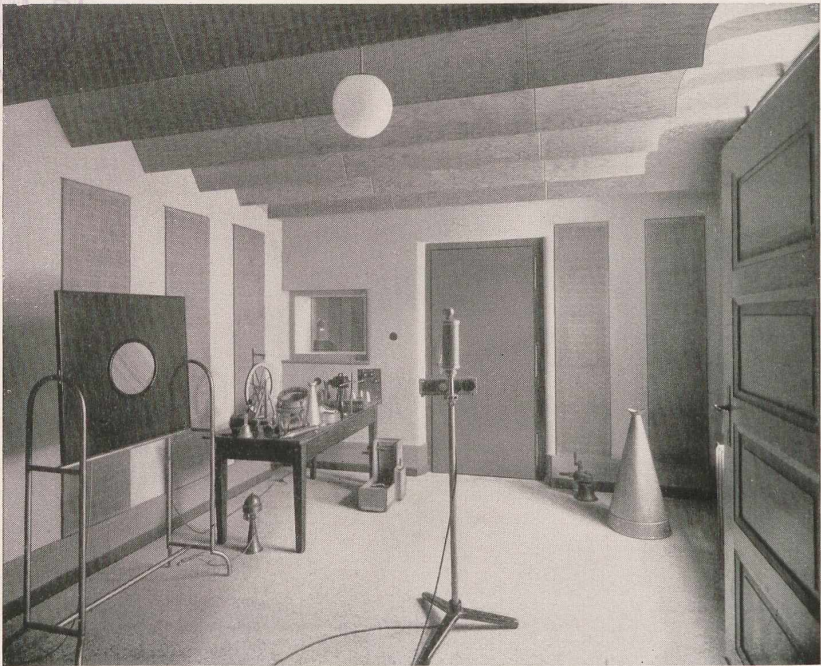
Geräuschraum für akustische Kulissee - Decke schallzerstreuend
