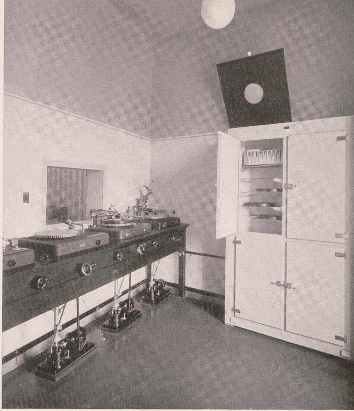
Abspielraum für Schallaufnahmen - Rechts der Kühlschrank für die Wachsplatten
