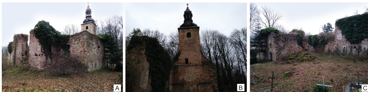
Il. 3. Stan obecny ruin w Nowym Kościele: A – widok na prezbiterium, B – widok na ścianę zachodnią, C – widok od północy (fot. G. Biczak)
