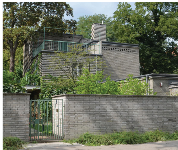
Il. 1. R. Gutt, dom własny przy ul. Hoene-Wrońskiego, 1926–1928, widok od ulicy (fot. K. Szumiński)
